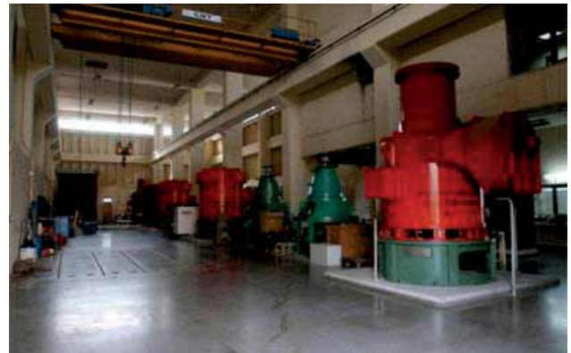
Çiğli Atıksu Pompa Tesisi İstasyonu
