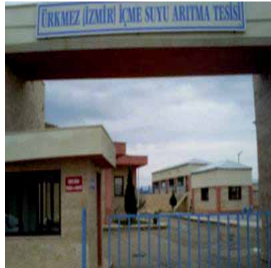
Ürkmez İçme suyu Arıtma Tesisi
