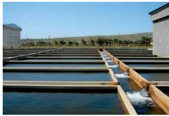
Tahtalı Barajı ve içme suyu arıtma tesisi havalandırma havuzları
