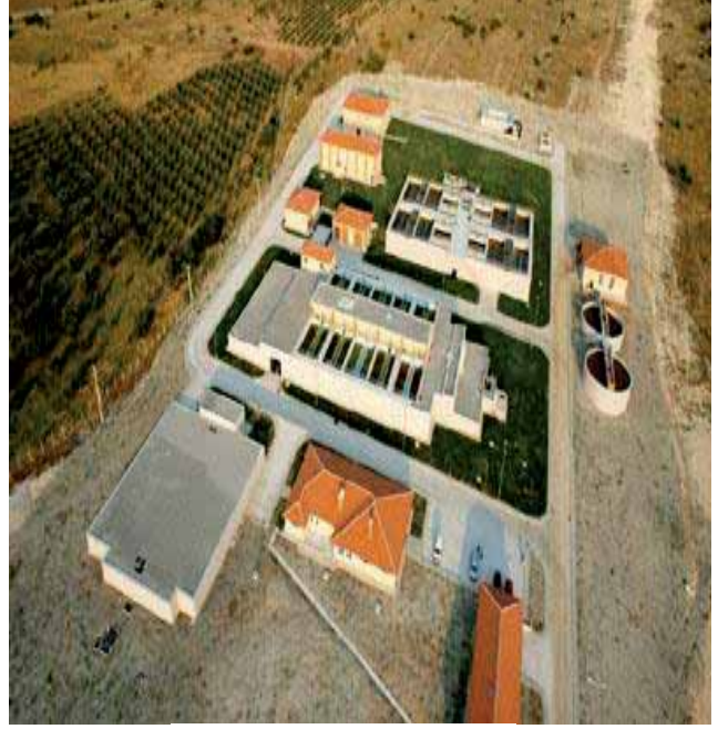
Sarıköz İçme Suyu Arıtma Tesisi
