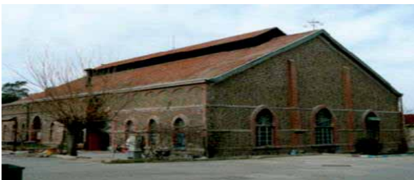
Halkapınar tarihi pompa istasyonu binası
