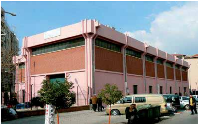
Gümrük Pompa İstasyonu
