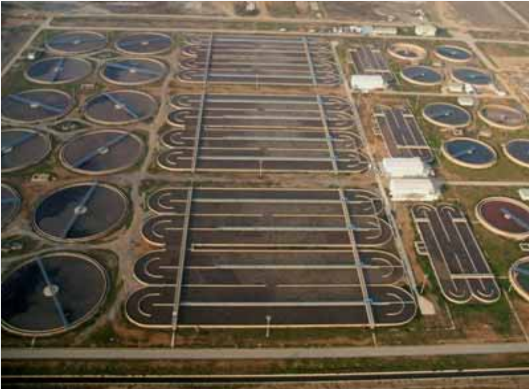
Çiğli Atıksu Arıtma Tesisi (ÇAAT)
