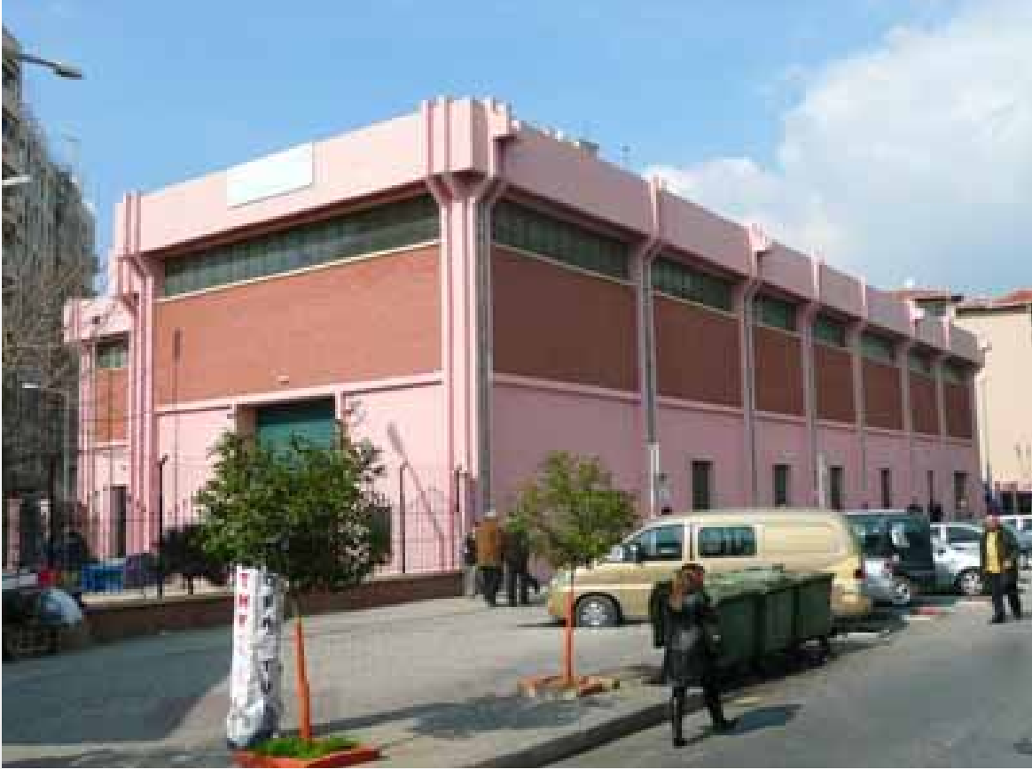
Gümrük Pompa İstasyonu
