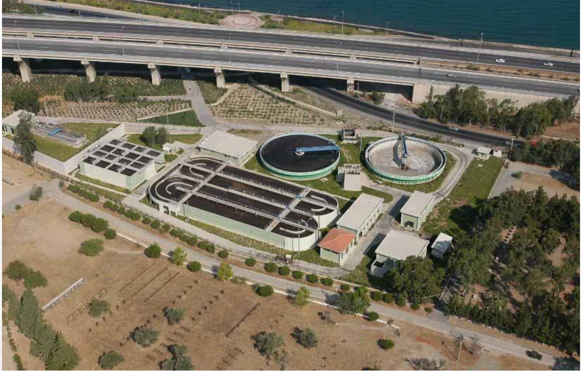
Güneybatı Atıksu Arıtma Tesisi
