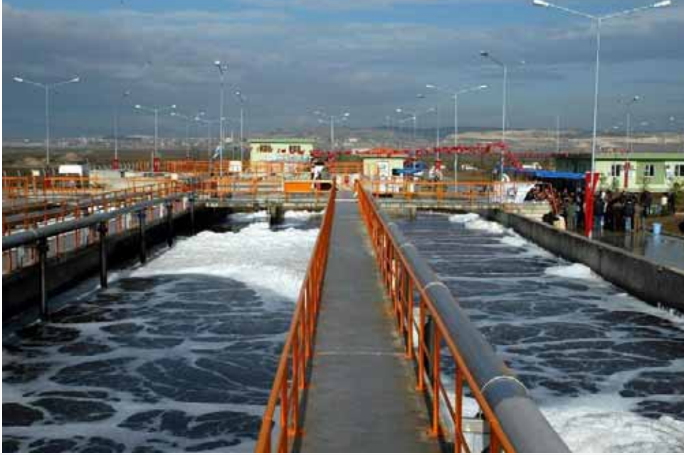
Havza Atıksu Arıtma Tesisi
