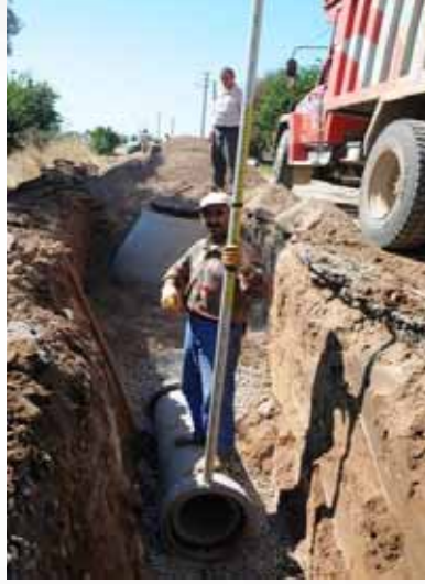
Kanalizasyon fotoğrafları (Seferihisar Orhanlı Köyü Kanalizasyonu)
