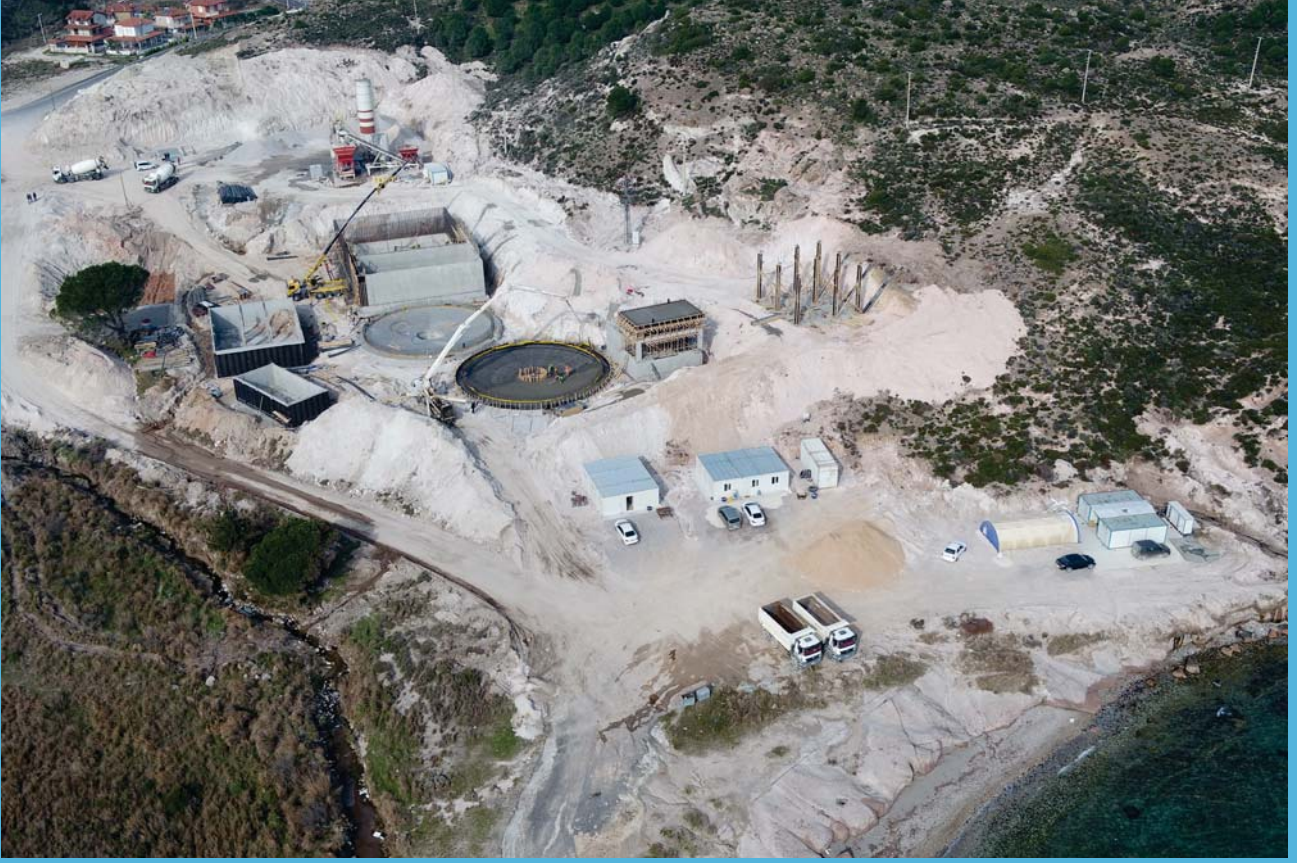
KARABURUN MORDOĞAN ATIK SU ARITMA TESİSİ İNŞAATI
