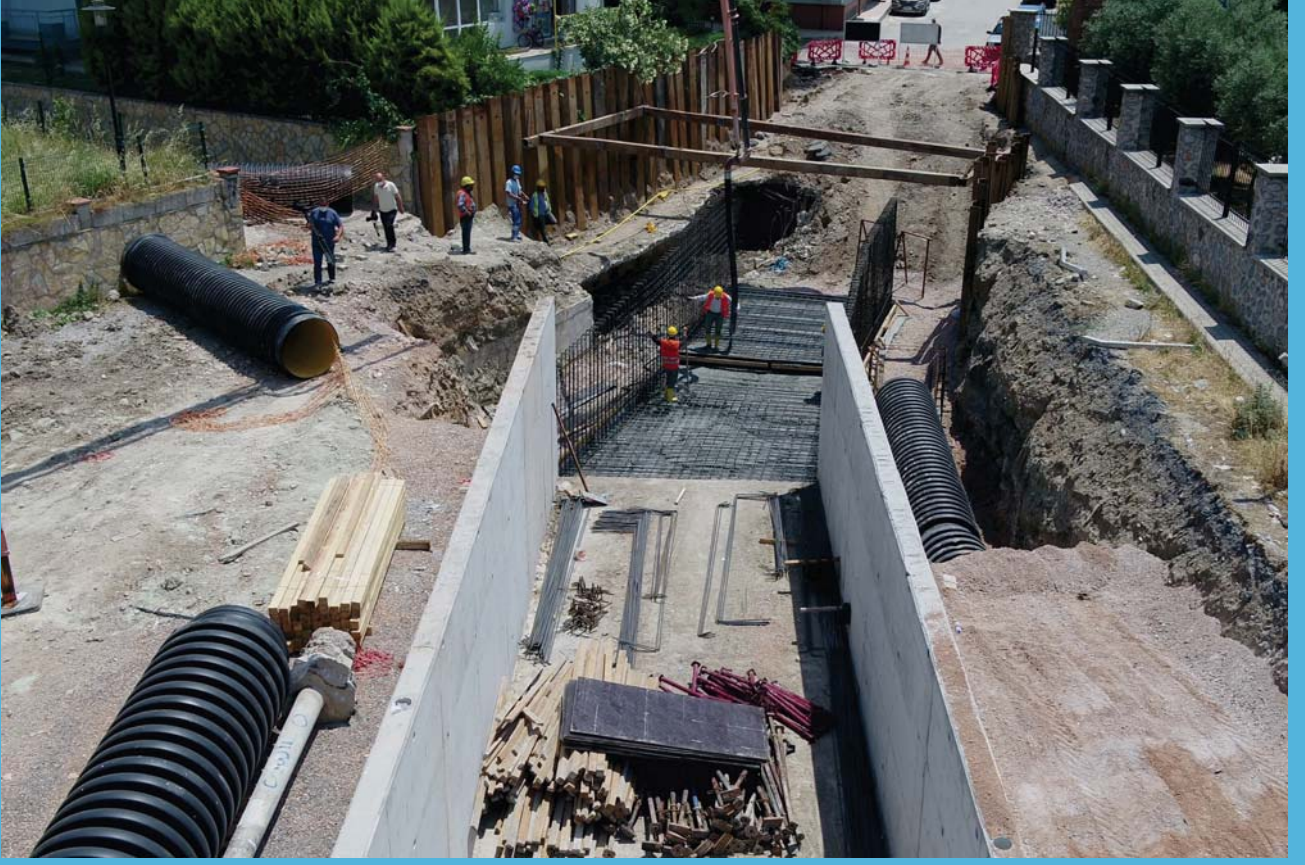
BUCA ATIK SU, YAĞMUR SUYU ve KOZAĞAÇ DERESİ ISLAH İNŞAATI
