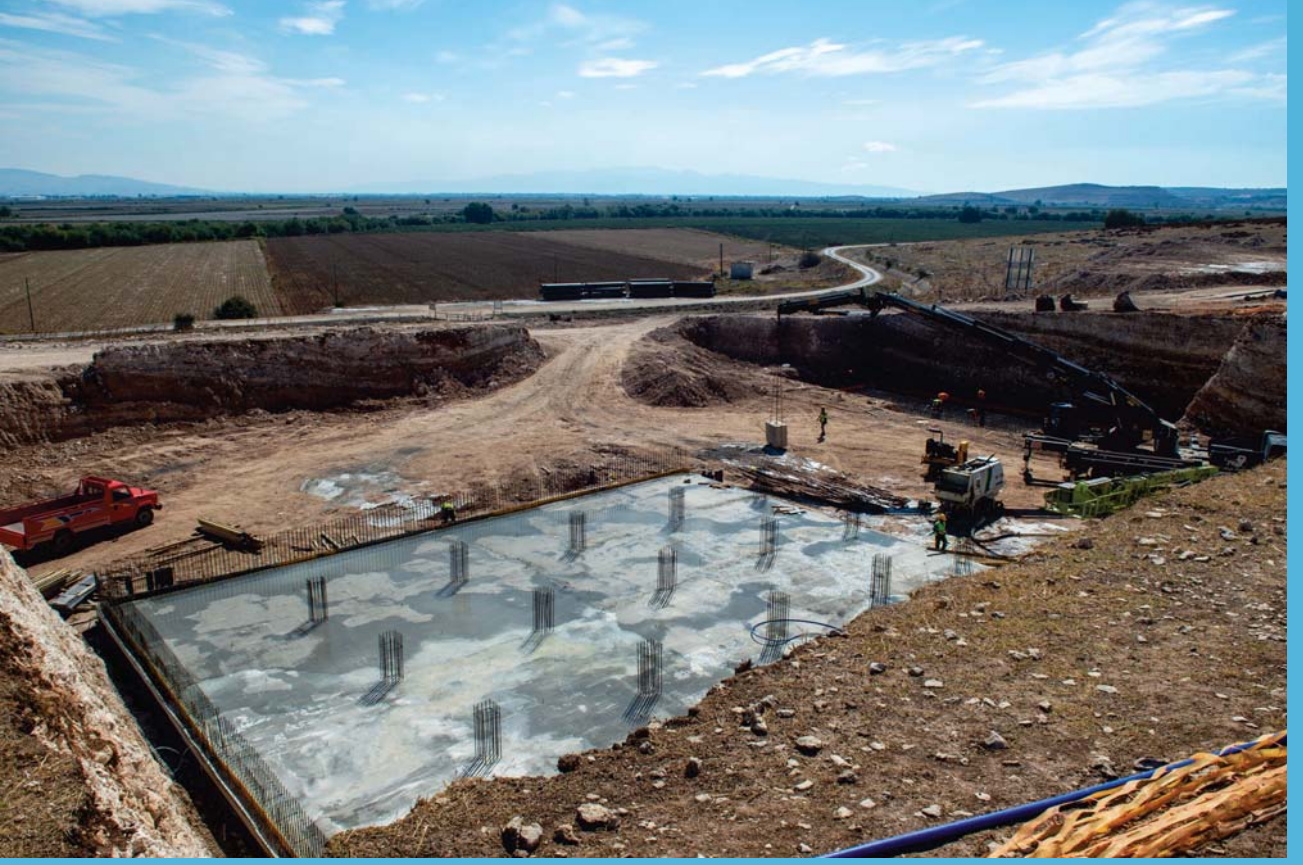
FOÇA, YENİ FOÇA, MUSABEY KUYULARI İÇME SUYU ARITMA TESİSİ İNŞAATI
