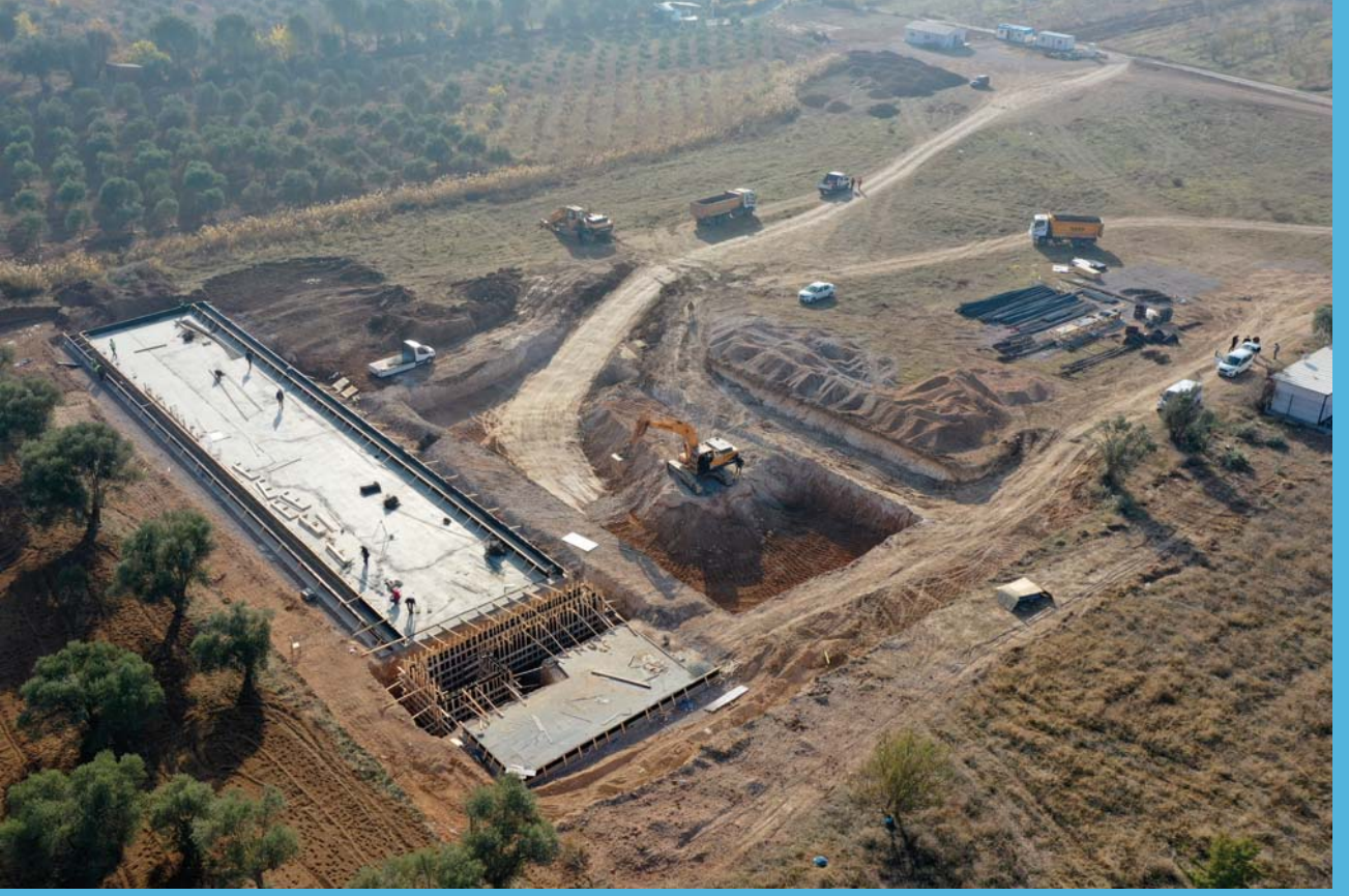
KEMALPAŞA ULUCAK ATIK SU ARITMA TESİSİ İNŞAATI
