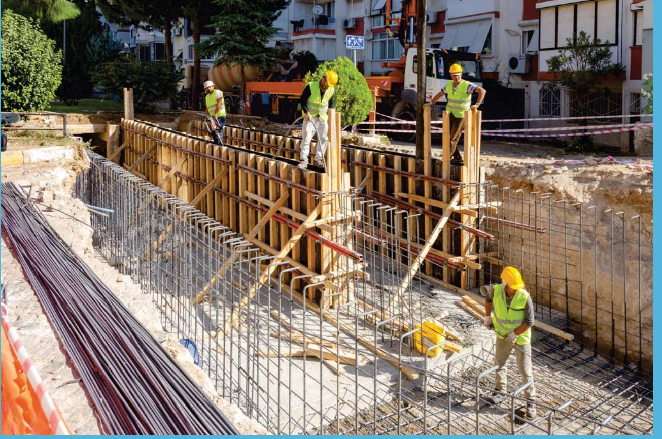
BALÇOVA HACI AHMET DERESİ ISLAHI İNŞAATI
