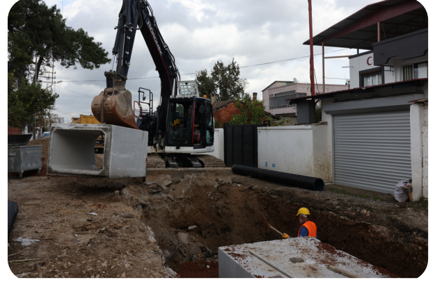
Torbalı İlçesi Subaşı Mahallesi Atık Su ve Yağmur Suyu Şebeke İnşaatı İşi
