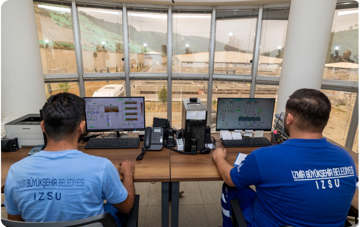
Kavaklıdere SCADA İzleme
