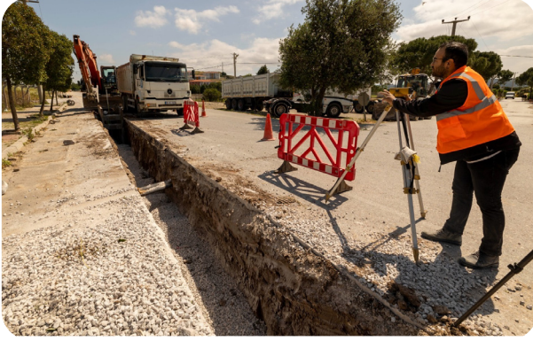
Çeşme 3. Etap İçme Suyu İnşaatı İşi
