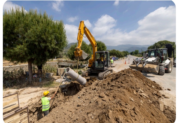
Ödemiş İlçesi Birgi Mahallesi Atık Su Şebeke İnşaatı İşi
