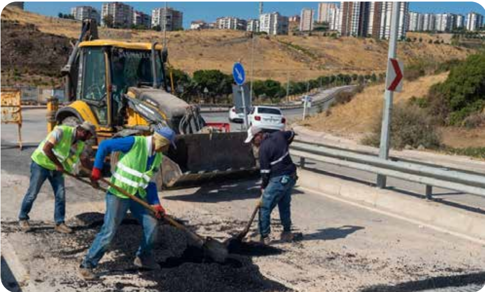
Çiğli İlçesi Asfalt Kaplama Çalışmaları
