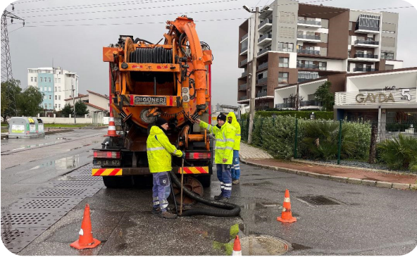
Çiğli İlçesi Tekli Yağmur Suyu Izgarası Temizliği
