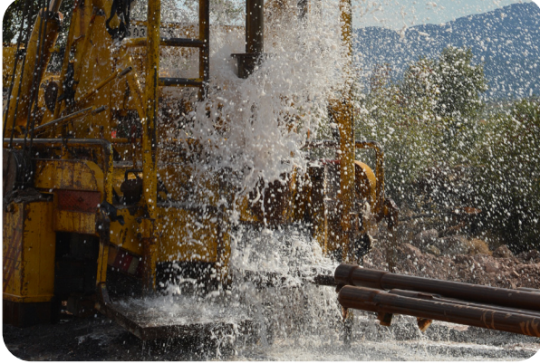
Aliağa Bergama Su Sondaj Kuyusu İnşaatı
