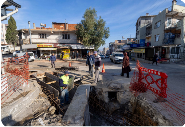
Karabağlar İlçesi Arıza Giderim Çalışmaları
