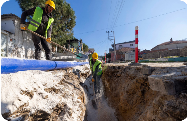
Urla ve Karaburun İlçeleri İçme Suyu İnşaatı İşi
