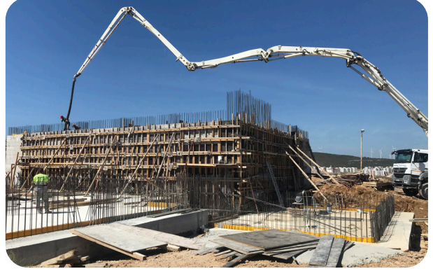
Seferihisar İlçesi Su Deposu İnşaatı İşi
