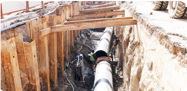
Konak İlçesi Kısa Metrajlı Kanalizasyon Hattı Çalışmaları
