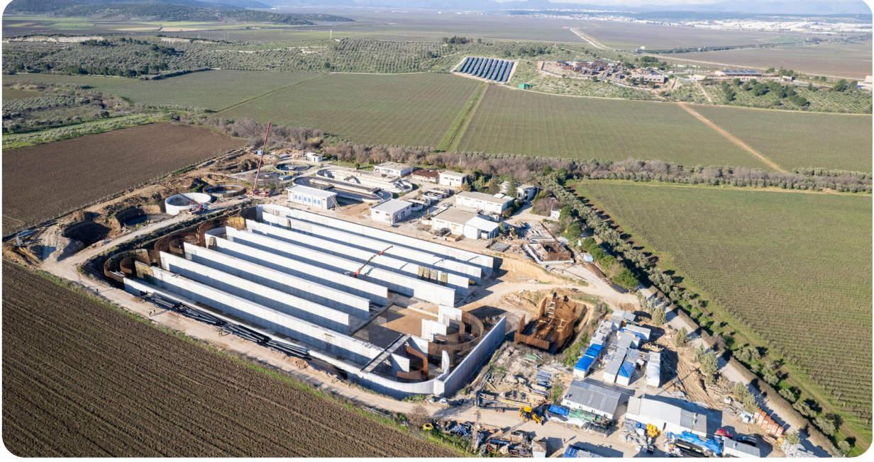
Torbalı Yazıbaşı-Ayrancılar Atık Su Arıtma Tesisi 2. Etap İnşaatı
