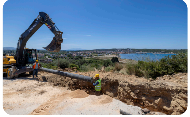
Seferihisar İlçesi İçme Suyu İnşaatı İşi
