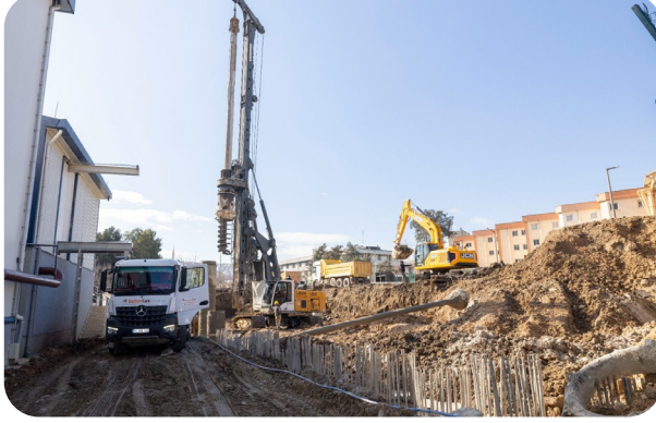
Halkapınar Kuyuları İletim Hatları ve 7.000 m 3 lük Depo İnşaatı İşi
