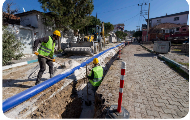
Bergama İlçesi Yukarıada ve Zeytindağ Mahalleleri İçme Suyu Şebeke İnşaatı İşi
