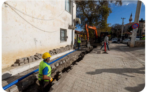
Urla Demircili Mahallesi İçme Suyu İnşaatı İşi
