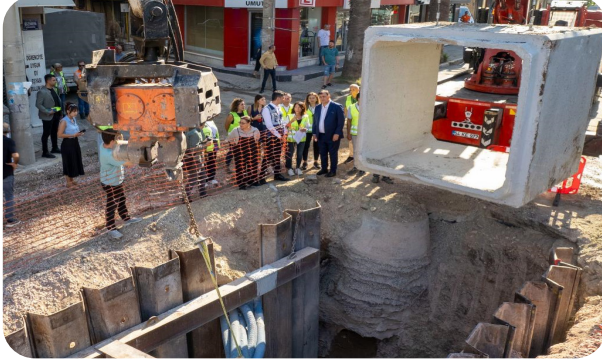
Bornova İlçesi Yağmur Suyu İnşaatı İşi
