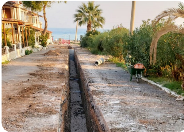
Karaburun İlçesi Muhtelif Mahalleleri Atık Su Şebeke ve İletim Hattı ile Baca İçi Terfi Merkezleri İnşaatı İşi
