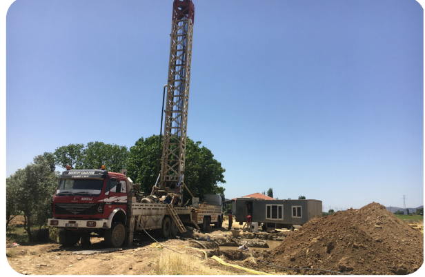
Ödemiş, Kiraz ve Beydağ İlçelerine Bağlı Mahallelerde Su Sondaj Kuyusu İnşaatı
