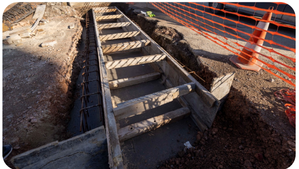
Bayraklı İlçesi Tekli Bina ve Tekli Izzara Yağmur Suyu Bağlantı Hattı Yapılması
