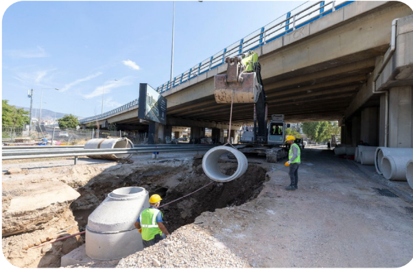
Bornova İlçesi Yağmur Suyu Hattı İnşaatı İşi
