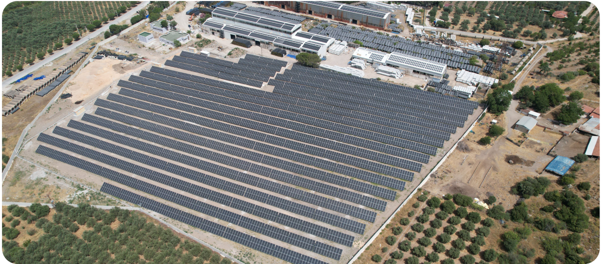
Menemen - Emiralem Çatı/Arazi Tipi Güneş Enerji Santrali Sahası
