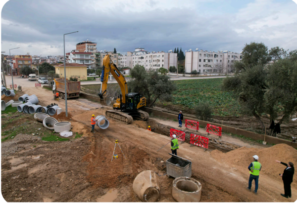
Torbalı Teknik Şube Müdürlüğü Sorumluluk Alanında Kanalizasyon Yağmur Suyu Hattı ve Bina Kolu Yapımı İşi
