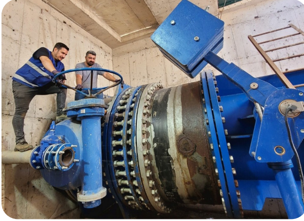
Kavaklıdere İçme Suyu Arıtma Tesisi Mekanik Bakım Onarım Çalışması
