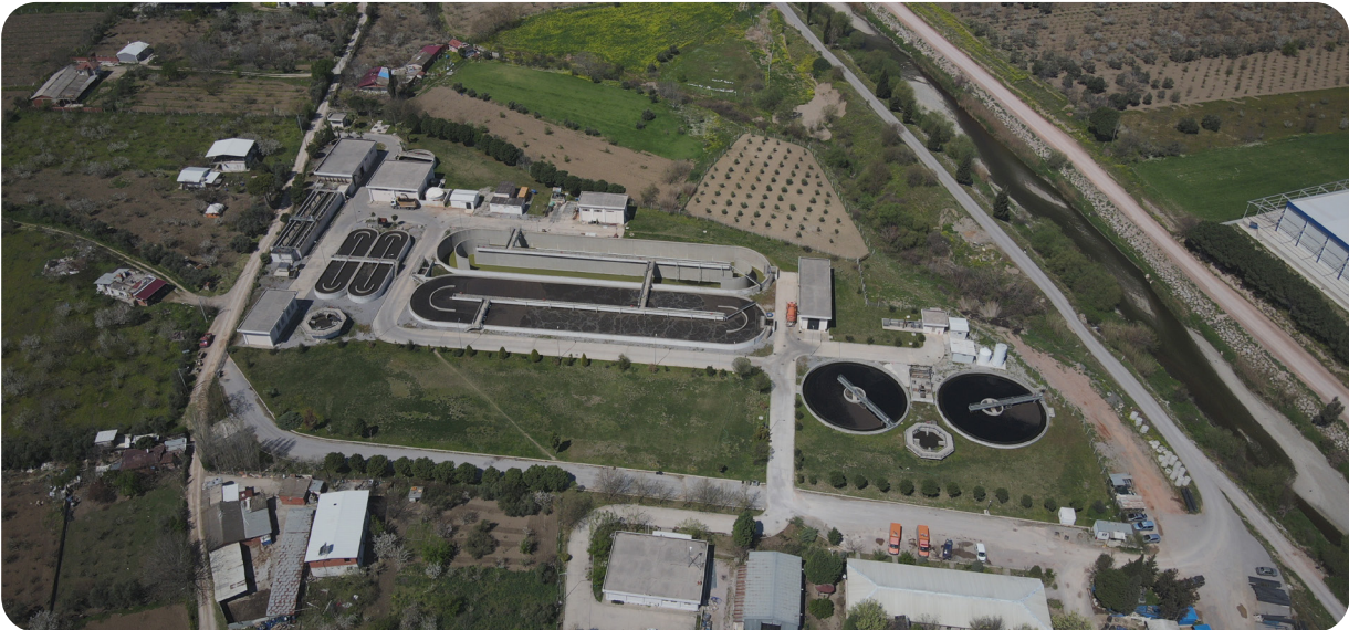
Kemalpaşa Atık Su Arıtma Tesisi Çıkış Suyu Geri Kazanım Tesisi
