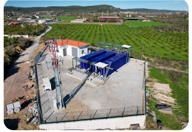
Seferihisar İlçesi Ulaış Mahallesi Paket Atık Su Arıtma Tesisi İnşaatı İşi
