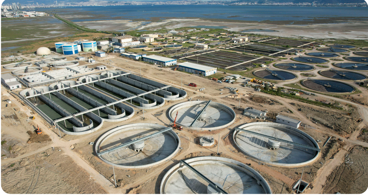
Çiğli Atık Su Arıtma Tesisi 4. Faz 2. İkmal İnşaatı
