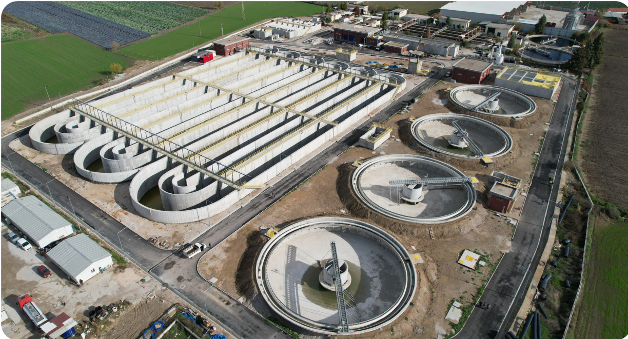
Torbalı Atık Su Arıtma Tesisi 2. Etap İnşaatı
