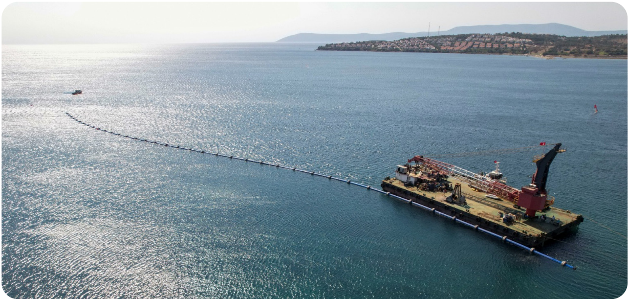
Seferihisar İlçesi Atık Su Arıtma Tesisi Terfi Merkezi ve Deniz Deşarj Hattı İnşaatı
