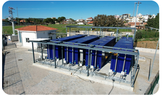
Seferihisar İlçesi Düzce-Turgut Mahallesi Paket Atık Su Arıtma Tesisi İnşaatı İşi
