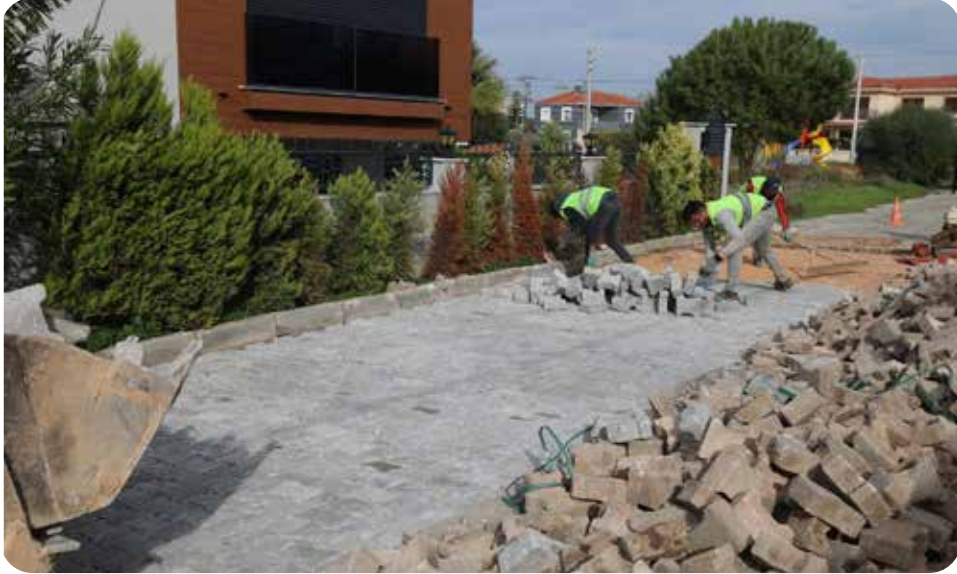
Çeşme İlçesi Parke Döşeme Çalışmaları
