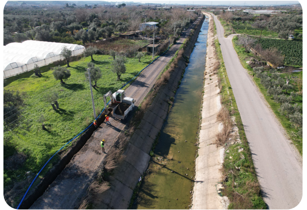
Menemen İlçesi Emiralem ve Türkelli Mahalleleri İçme Suyu Şebeke ve İletim Hattı ve Yeni Foça Grup İnşaatı İşi
