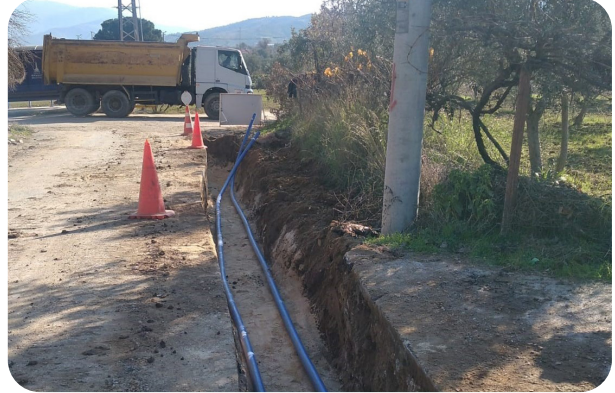
Kiraz İlçesi 1.Etap İçme Suyu İnşaatı İşi
