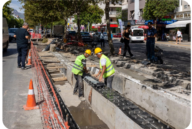
Karşıyaka İlçesi Tekli Yağmur Suyu Izzara Yapımı
