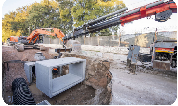
Buca İlçesi Muhtelif Mahalleleri Atık Su, Yağmur Suyu Çalışmaları İşi
