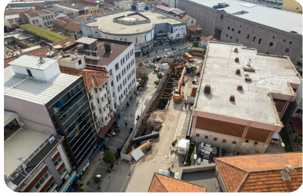
Gümrük Pompa İstasyonu Bakım Onarım Çalışmaları
