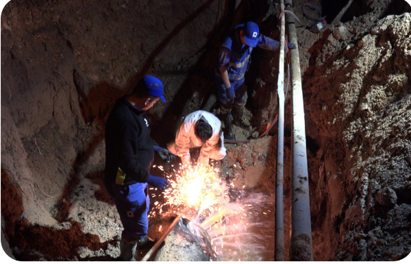
Çiğli İlçesi Branşman Hattı Döşenmesi İşi
