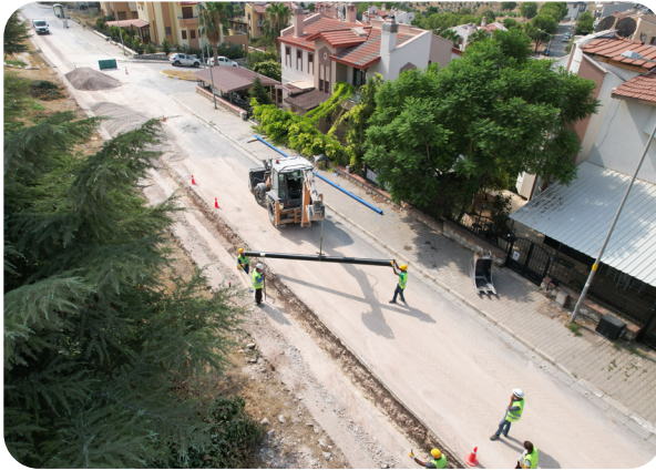
Menemen İlçesi Seyrek Merkez ve Çevre Mahalleleri İçme Suyu İnşaatı İşi
