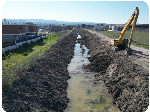
Yarımada Bölgesi Dere Islah Çalışmaları
