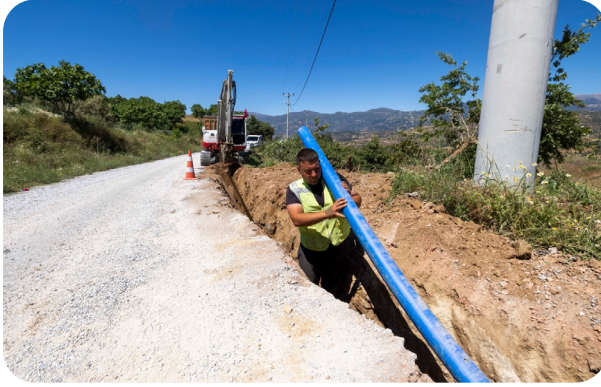
Kiraz İlçesi Cevizli, Bahçearası ve Mersinlidere Mahalleleri İçme Suyu İnşaatı İşi
