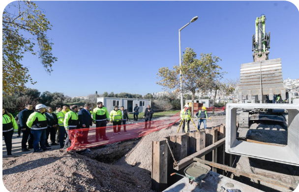
Bayraklı İlçesi Yağmur Suyu Hattı İnşaatı İşi
