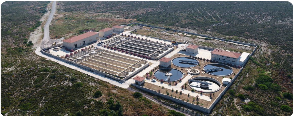
Çeşme Atık Su Arıtma Tesisi
