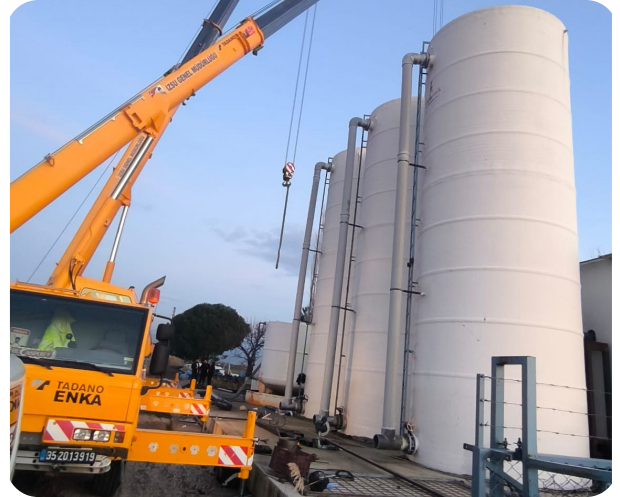
Kınık Merkez Paket İçme Suyu Arıtma Tesisi Mekanik Bakım Onarım Çalışması
