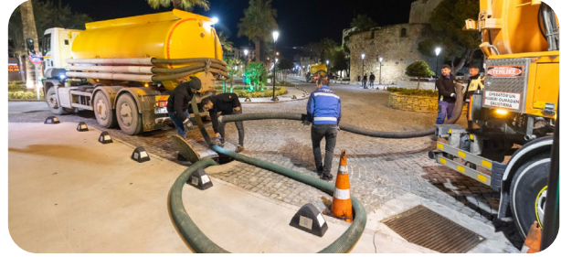
Çeşme İlçesi Tekli Yağmur Suyu Izgarası Temizliği
