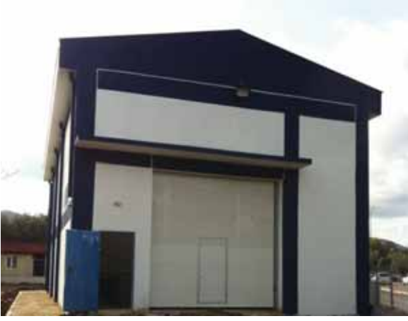
Güzelbahçe İlçesi İçmesuyu Pompa İstasyonu İnşaatı
