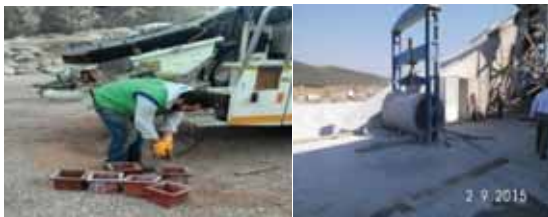
Beton numunesi alımı Beton boruya tepe y k  basıncı testi yapılması
