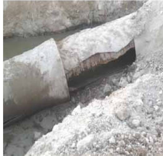
TM18 Atıksu terfi istasyonunun patlamış olan Ø 1200 öngermeli beton borusu yine aynı çapta duktıl boru ile yenilenmesi
