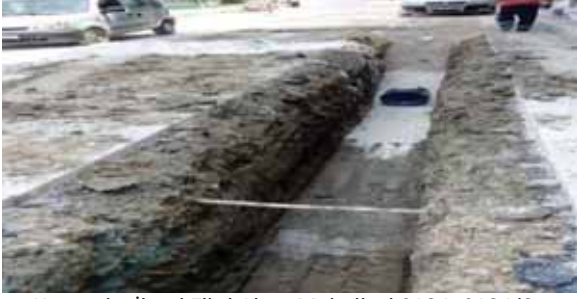
Karşıyaka İlçesi Fikri Altay Mahallesi 6184, 6184/3, 6185/1, 6185/3, 6185/4 ve 6185/9 Sokaklar Yağmursuyu Kanalı İnşaatı
