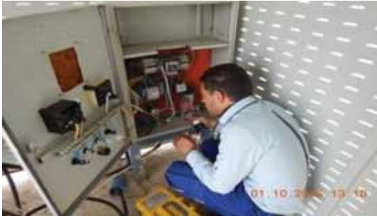
Bergama Eğiller Mahallesi Keson Kuyu Motor Sökümü ve Bergama durmuşlar mahallesi pompa amperi ölçüm çalışması
