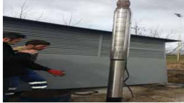
Menderes İlçesi Ataköy A1, Küner K1 Kuyuları Kuyusuna motopomp temini ve Montajı ile Saç Kabin Yapılması
