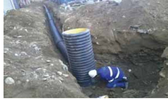
Yeni Kanalizasyon Şebekesi Döşenmesi
