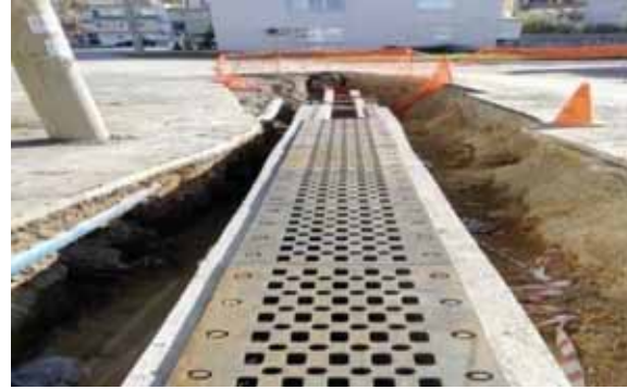
İzmir İli Karşıyaka İlçesi Şemikler Mahallesi 6276, 6303, 6304, 6305/2, 6306, 6314/2, 6316/5 ve 6316/6 Sokaklar Yağmursuyu Kanalı İnşaatı
