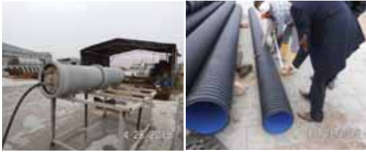
Beton boruların sızdırmazlık testi Koruge borulardan numune alınması
