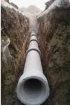
Muhtelif cadde ve sokakaların ,kanalizasyon hattının yenilenmesi çalışmaları
