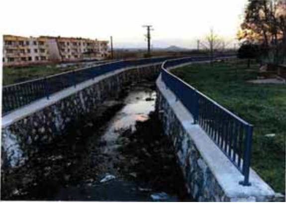
Bergama Ayvaz Ali Deresi korkuluk imalatı yapılmış durumu
