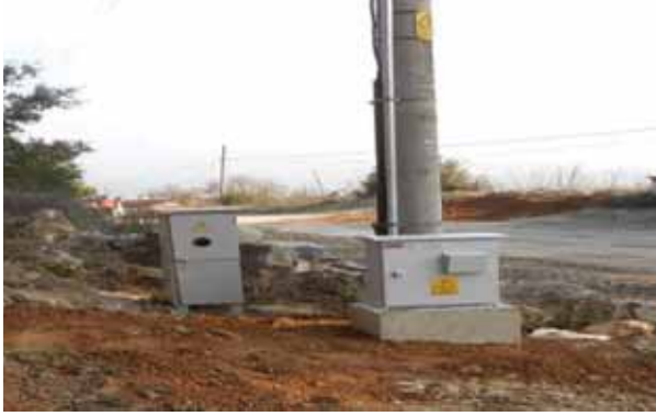
Bornova İlçesi Yakaköy Özbek Mahallesi'nde yapılan İçme suyu Terfi Merkezine Elektrik Temini çalışmaları
