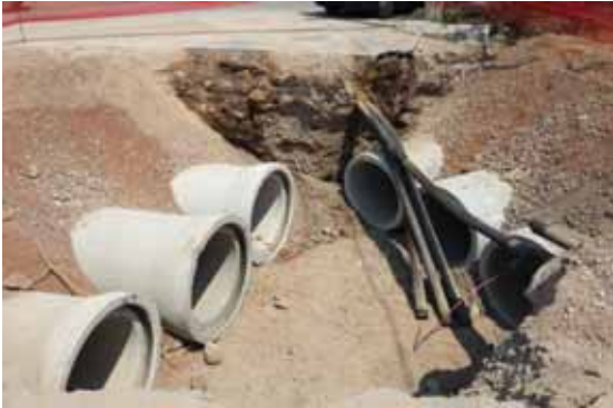
Buca 602/1 Sokakta yapılan kanal deplase çalışması
