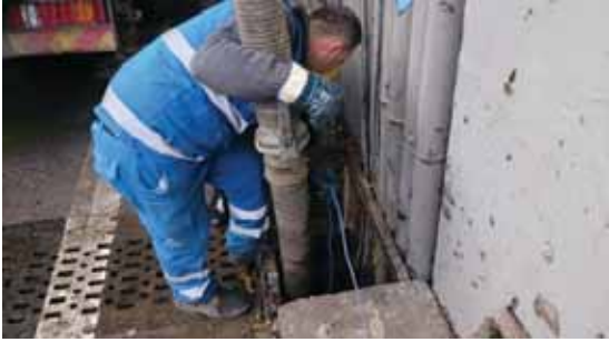
Atıksu Pompa İstasyonlarının Bakım ve Onarım Çalışmaları
