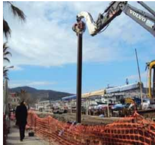
Palplanş çakılması ve basınçlı hatlarda yapılan çalışmalar
