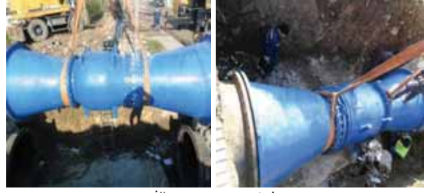
İğne vana montajı
