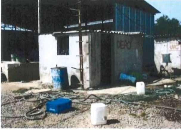
Yıkım Öncesi Kaçak Yapı
