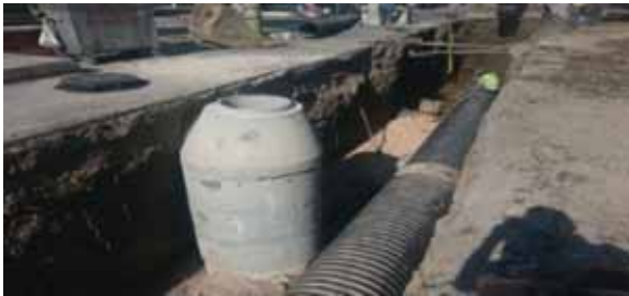
Bayraklı İlçesi Manavkuyu ve Osmangazi Mahalleleri Muhtelif Sokakları Atıksu ve Yağmursuyu Kanalı İnşaatı
