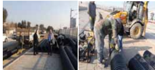
Sahadaki koruge borulardan numune alınması
