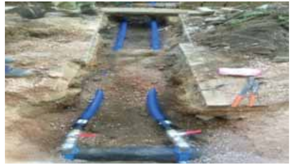
İzmir İli Konak İlçesi Alsancak 4.Etap içmesuyu Şebekesi İnşaatı
