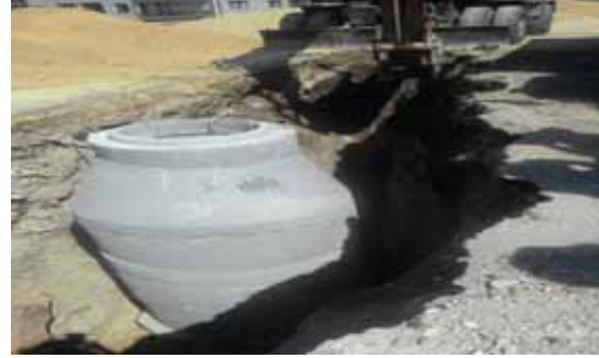
İzmir İli Karabağlar İlçesi Aşık veysel, Araphasan, Bozyaka, Gülyaka, Kazım Karabekir, Bahar, Doğanay Mahalleleri Muhtelif Sokaklar Yağmursuyu Kanalı İnşaatı İş
