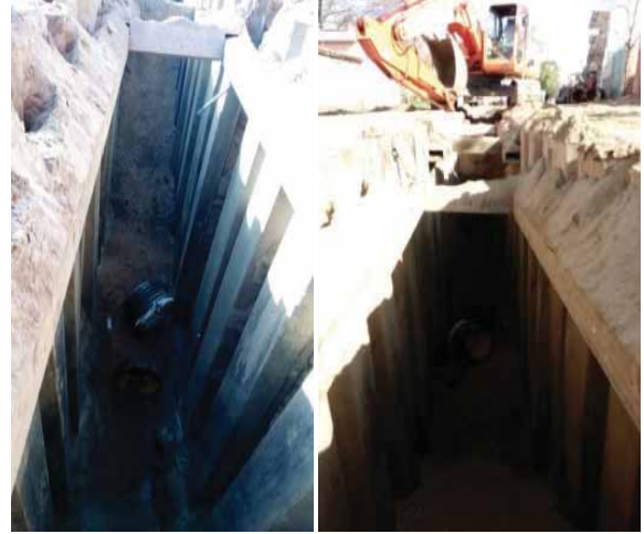
Palplanş hatlarda yapılan çalışmalar
