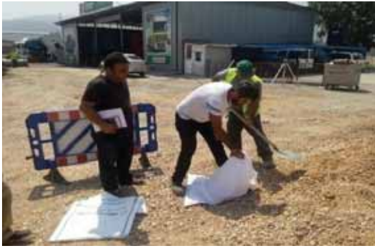
Kırmataş dolgu malzemesi numune alımı ve testi
