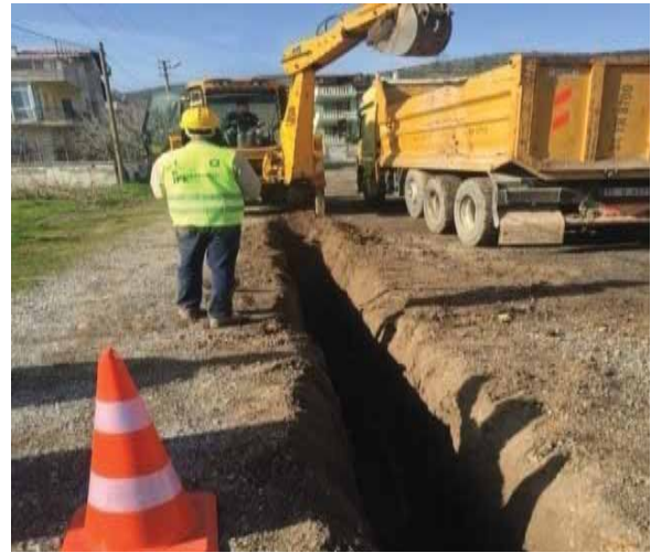
İzmir İli Urla İlçesi Balıklıova, Özbek ve Gülbahçe Köyleri ile Seferihisar İlçesi Ulağış ve Düzce Köyleri İçme Suyu Şebekesi İnşaatı
