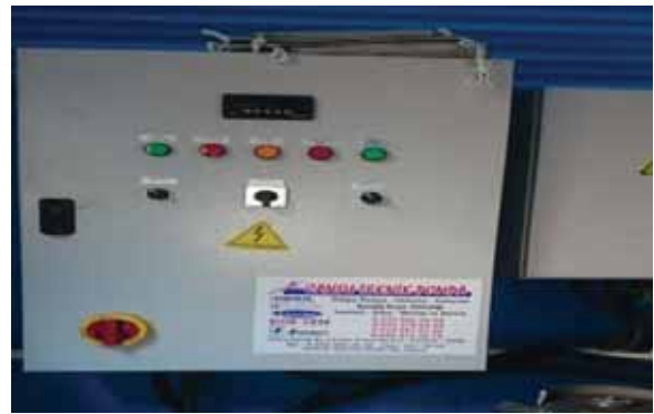
İzmir Torbalı İlçesi Dağkızılca İ  mesuyu Hidrofor Terfi Sistemi Polietilen Su Deposu Temini ve Montajı İ  i
