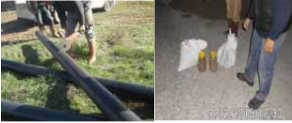
Şantiyedeki Düktil borulardan ve Gömlekleme ve dolgu malzemesinden numune alınması
