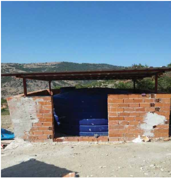
Kınık Elmadere Mahallesi Su deposu çalışması
