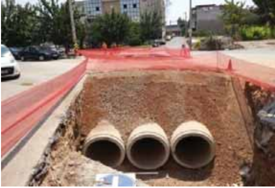
Muhtelif cadde ve sokakaların ,kanalizasyon hattının yenilenmesi çalışmaları
