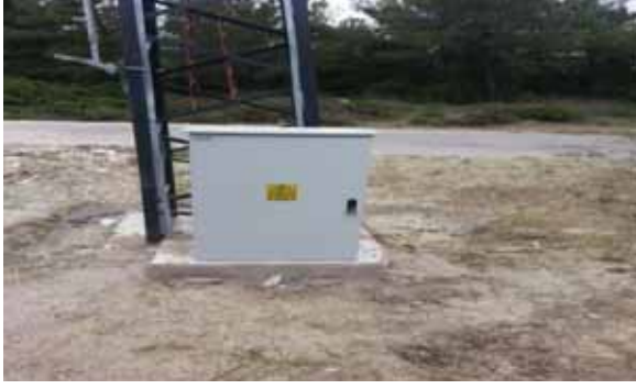
Menemen Alani i K y nde yapılan i me suyu Kuyusuna elektrik temini  alıřmaları
