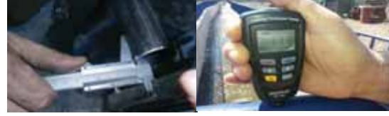
Boru profillerin et kalınlıđı   l  m   Korkulukların boya kalınlıđı   l  m  
