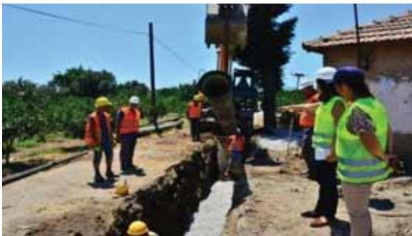
İzmir İli Seferihisar İlçesi Doğanbey Beldesi ve Payamlı Mahallesi İçme Suyu Şebekesi İnşaatı
