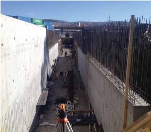
B.A.U kanal çalışmaları
