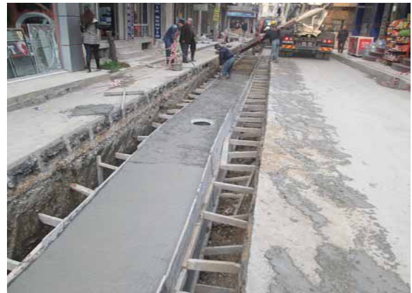
Kutu kesit B.A Yağmursuyu kanalı Çalışmaları
