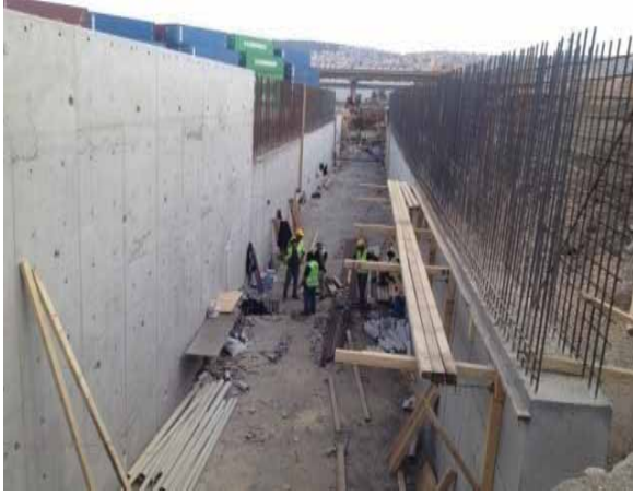
B.A.U kanal çalışmaları
