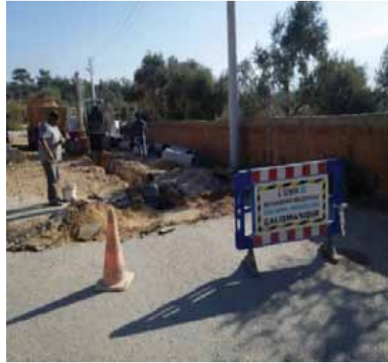
Bornova İlçesi Naldöken Mahallesinde yapılan kanal çalışmaları
