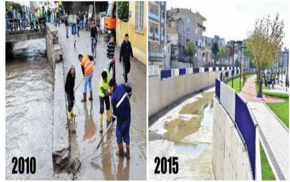
Karşıyaka İlçesi Bostanlı Deresi, 1671 Sokak-Ordu Caddesi Arası Dere Islah İnşaatı
