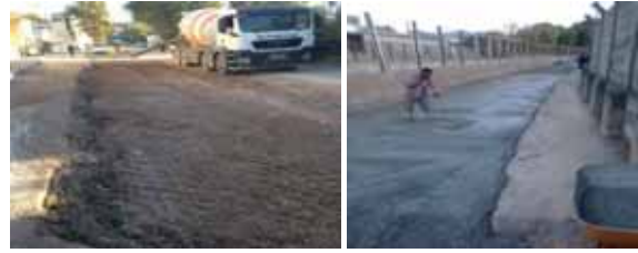
Bornova İlçesi Kazımdirik Mahallesi Sanayi Caddesinde Atıksu Kanalı Yenileme İnşaatı
