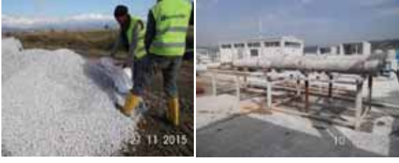
Gömlekleme ve dolgu malzemesinden numune Beton boruların sızdırmazlık testi alınması
