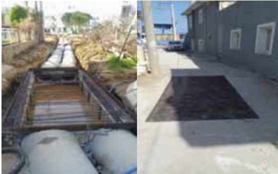
Güzelbahçe 56 Sokakta yapılan Yağmursuyu Hattı İmalatı İşİ
