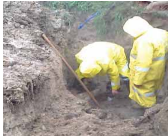
Ekiplerimizin yaptığı çeşitli arıza çalışmaları
