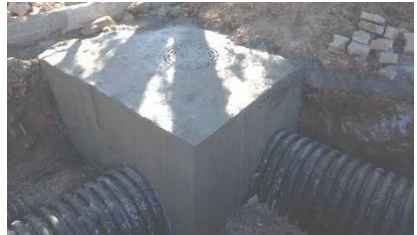
Menderes İlçesi Gümüldür-Özdere Atıksu İletim Hattı ile Özdere Çukuraltı, Orta, Gümüldür İnönü Mahalleleri Atıksu ve Yağmursuyu Şebeke İnşaatı
