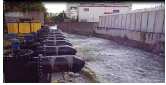
Konak İlçesi Güzelyalı ve Göztepe Mahalleleri Yağmursuyu ve Atıksu Kanalı İnşaatı
