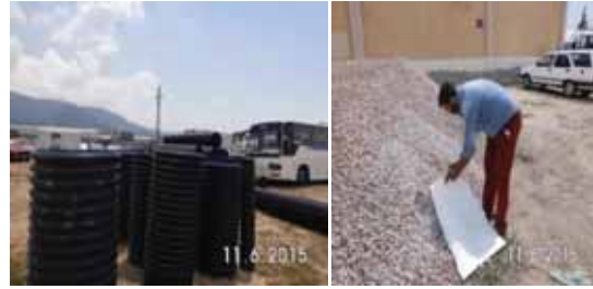
Koruge borulardan ve Dolgu malzemesinden numune alınması
