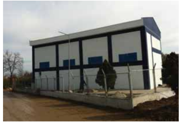
G  zelbah  e İ  esi İ  mesuyu Pompa İstasyonu İnŐ aatı
