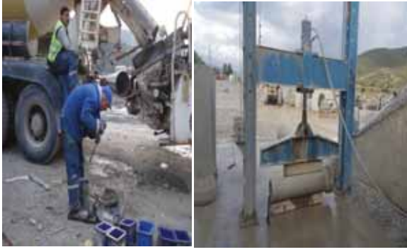
Teste gönderilmek üzere Betondan numune alınması ve beton boruya tepe yükü testi uygulanması
