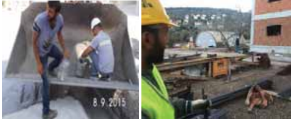
Beton ve demir numunelerinin alınması
