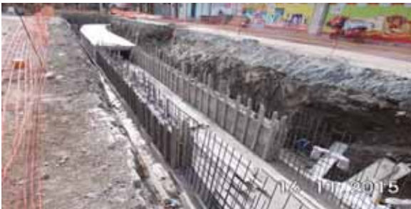
İzmir İli Seferihisar İlçesi Turabiye, Camikebir, Çolak İbrahim Bey ve Hıdırlık Mahalleleri Muhtelif Sokaklar Yağmursuyu Kanalı İnşaatı
