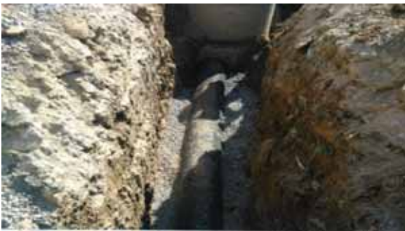
Karabağlar İlçesi Ali Fuat Cebesoy Mahallesi 9516, 9517, 9518, 9596 Sokaklarda Kanalizasyon İnşaatı
