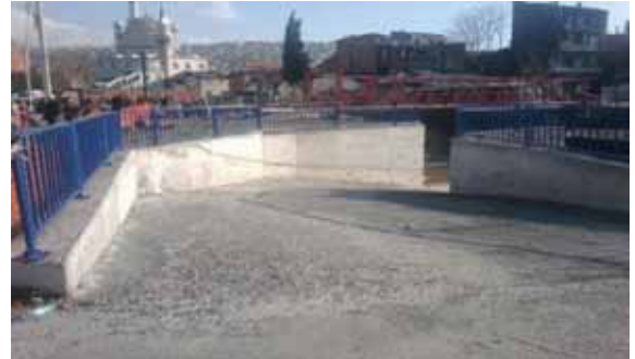
İzmir İli Konak İlçesi Ø1600 mm Melez Atıksu Kollektörü Hattı Üzerinde Çökeltme Havuzu İnşaatı
