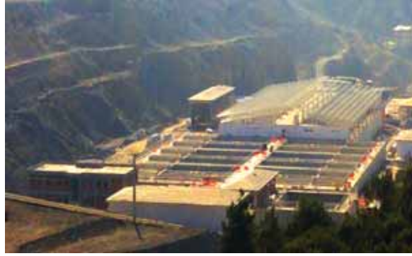
Kavaklıdere İçmesuyu Arıtma Tesisinden genel görünüm
