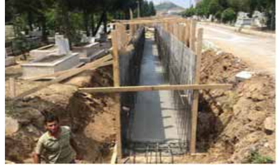
Doğançay Mezarlığı betonarme U kesit imalatı
