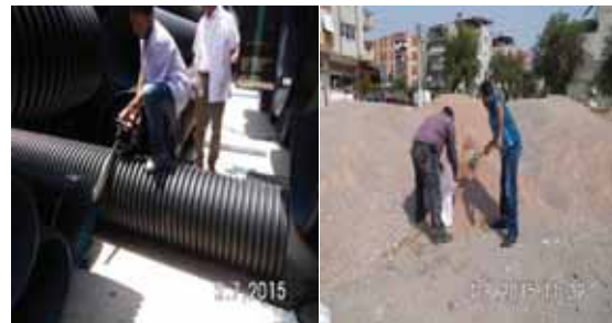
Korige borulardan numune alınması ve Gömlekleme ve dolgu malzemesinden numune alınması
