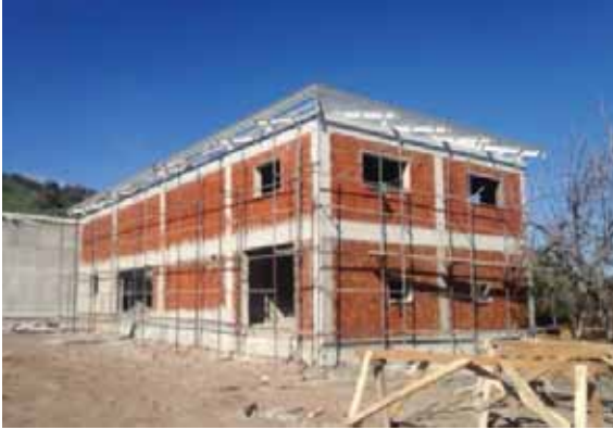
İzmir İli Foça İlçesi Yeni Foça Atıksu Arıtma Tesisi İnşaatından genel görünüm
