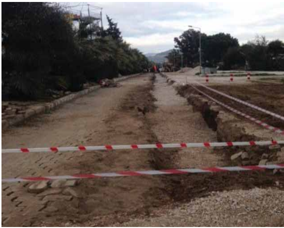
Menderes İlçesi Çukuraltı, Cumhuriyet Mahalleleri ile Gümüldür Atatürk ve Fevzi Çakmak Mahalleleri Muhtelif Sokaklar Atıksu ve Yağmursuyu Şebeke İnşaatı
