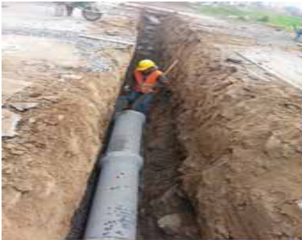
İzmir İli Menemen İlçesi Türkelli-Helvaci-Hatundere Atıksu İletim Hattı İnşaatı
