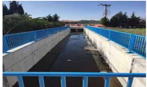
Hayıtlı Deresi Betonarme U Kesit, Menfez ve Korkuluk imalatı – Seferihisar
