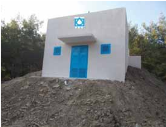
Torbalı İlçesi Çakırbeyli, Dağkızılca, Çapak, Bozk  y ve Saipler K  yleri İ  me Suyu İn  aatı
