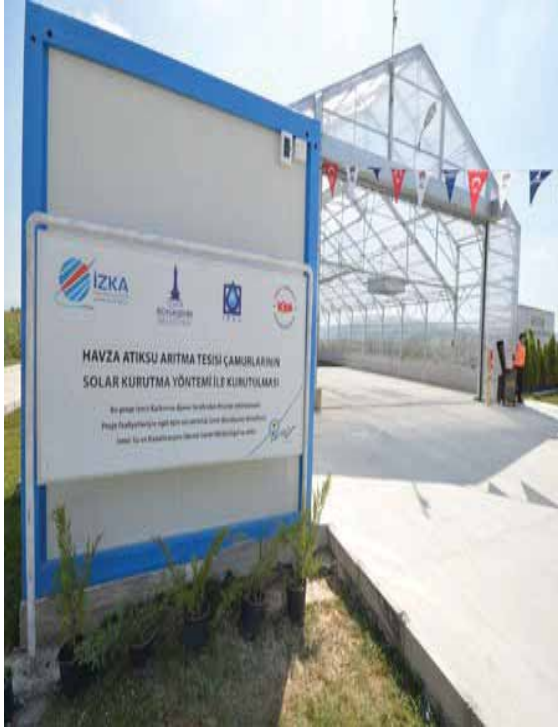
Havza Atıksu Arıtma Tesisi Solar Çamur Kurutma Ünitesi
