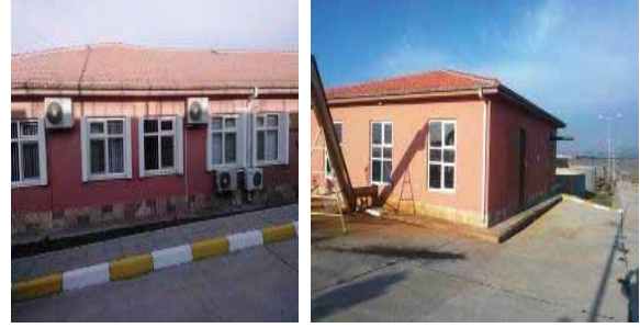
Sarıköz İçme Suyu Arıtma Tesisi Ünite ve Binalarından Bir Görünüm
