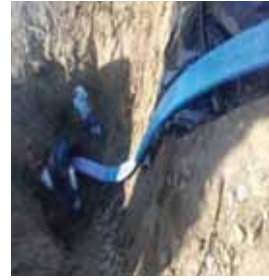
Dikili' deki Kevler Tipi Esnek Bez Boru D  şeme   alışmaları
