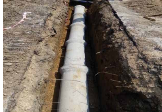
İzmeton A.Ş. önü kanalizasyon hattı yapımı
