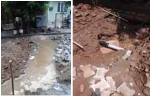
  emi  Atat  rk Mahallesi G  lc  k Sokakta Ø110 Anaboru Patlak Tamiratı
