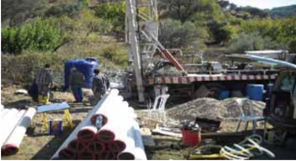
Seferihisar İlçesi Beyler B1 kuyusunda yapılan sondaj kuyusu çalışmaları
