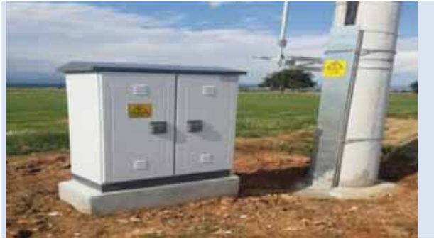
Menemen ilçesi Kesikköy KS1 ve KS2 Kuyuları ile Çavuşköy ÇV1 Kuyusu, Haykıran H1 Kuyusuna yapılan motopomp temini ve Montajı ile Saç Kabin Yapılması çalışmaları
