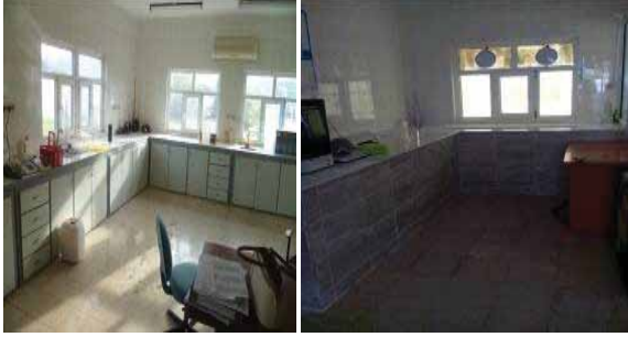
Çeşme İçme Suyu Arıtma Tesisi İdari Bina ve Kimya Binası
