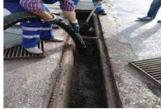
Yağmur mazgallarının temizliği yapılarak yağış anında sorun yaşanması engellenmiştir
