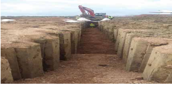
Sasalı ve Kaklıç mahallerinin Atıksularının , Çiğli Atıksu Arıtma Tesislerine, ulaşmasını sağlayan hattın yapım çalışmaları
