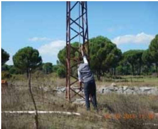
Bergama Aşağıcuma Mahallesi Pompa Hattı Kopuğu Çalışması
