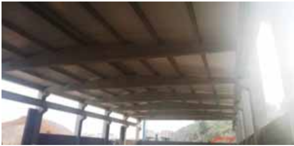
İZSU Karabağlar Ambar Binası İnşaat çalışmalarından görünüm
