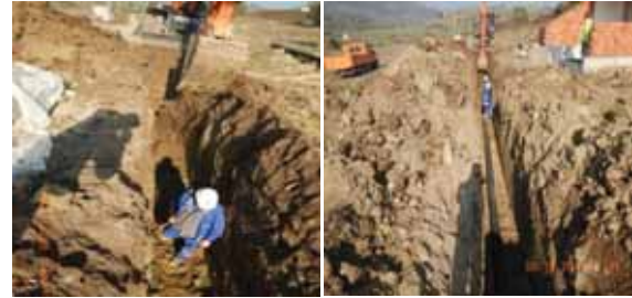
Bergama Bahçelievler Mahallesi 9. ve 10. Sokaklarda Yeni Kanal İmalatı
