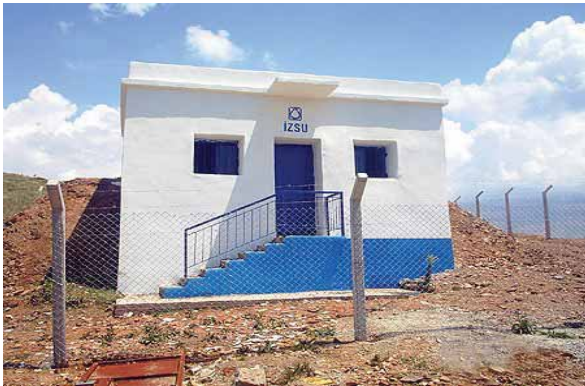
Su Depoları Bakım Onarım Faaliyetleri
