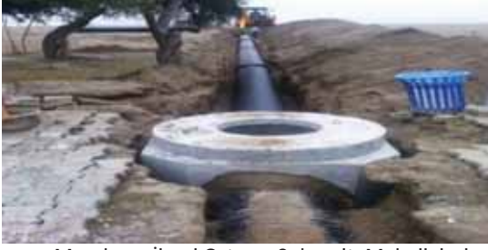
Menderes İlçesi Orta ve Çukuraltı Mahalleleri Yağmursuyu Kanalı
