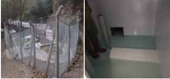
Bornova İlçesi Homeros Vadisi Deli Süleyman Kaynağı Kaptaj İnşaatı
