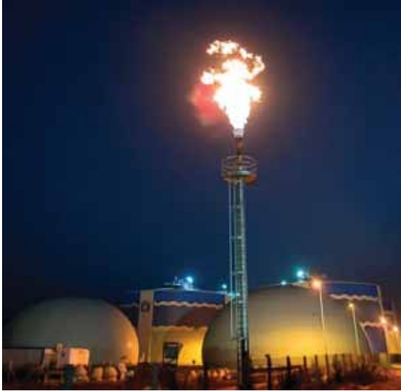
   li Arıtma Tesisinde   amur     tme ve Kurutma Tesisini In aatı I ı
