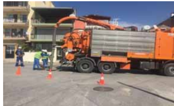
Kanalizasyon hattı temizliği
