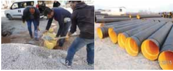
Dolgu malzemesinden numune alınması Sahaya gelen korusu borular
