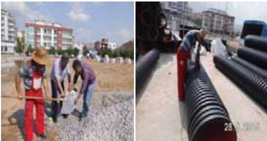
Gömlekleme ve dolgu malzemesinden numune ve Koruge borulardan numune alınması
