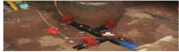
Kemalpa a İlçesi Ovacık ve Halilbeyli K y  i mesuyu in aatı
