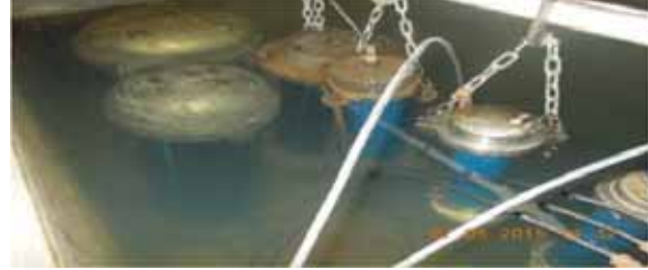
İçmesuyu borularının iç basınca direnci testi
