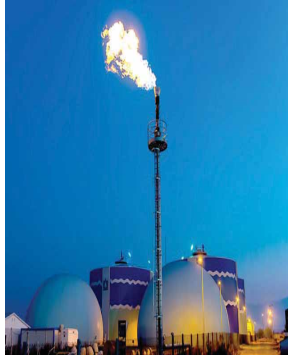
   li Arıtma Tesisinde   amur     tme ve Kurutma Tesisini In aatı I ı
