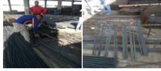
Teste gönderilmek üzere demir numunelerinin alınması
