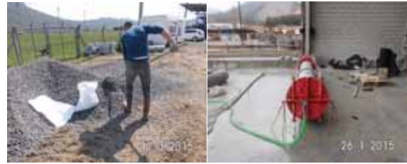
Geri dolgu malzemesinden numune alınması ECBB Beton borulara uygulanan sızdırmazlık testi
