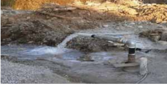
İzmir Menderes İlçesinde yapılan Çatalca Ç1 sondaj kuyusu çalışmaları
