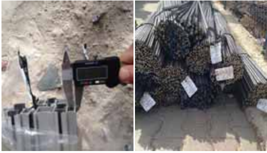
Profil, inşaat demiri ve yalıtım malzemelerinin kontrolü
