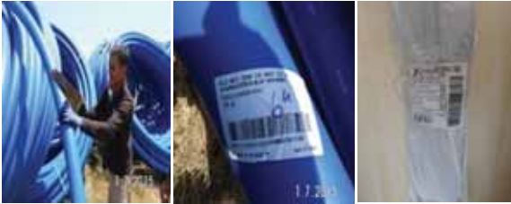
Şantiyedeki içmesuyu borularından numune alınması ve analiz için gönderilmesi
