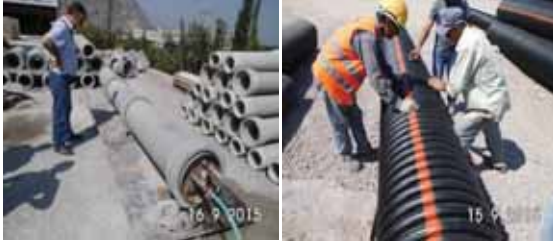
Beton borulara sızdırmazlık testinin yapılması Koruge borulardan numune alınması
