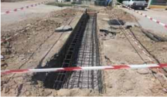
Bornova İlçesi Karacaoğlan Mahallesi 6172 ve 6167 Sokaklar Yağmursuyu Kanalı İnşaatı
