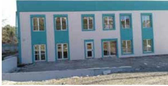
Bornova Kaynaksuyu Dolum Tesisi İnşaat çalışmalarından görünüm
