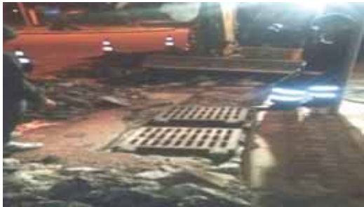
Yağmur ızgaraları hattın çapının büyütülmesi ve yenilenmesi ile sorunsuz hale getirilmesi
