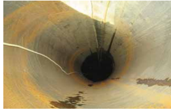
Ankara Caddesi Kemalpaşa yolunda bulunan İzbeton A.Ş. 'nin kanalizasyon problemini çözebilmek adına yatay delgi metodu kullanılarak kanalizasyon sistemine bağlantısı yapılması planlanmaktadır.
