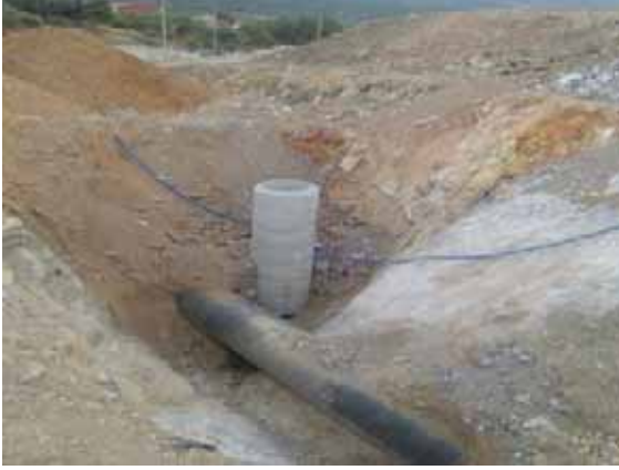
İzbeton A.Ş. önu kanalizasyon hattı yapımı
