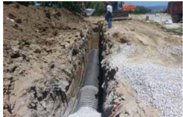
Bornova il  esi Karacao  lan Mahallesi 6172 ve 6167 Sokaklar Ya  mursuyu Kanalı inřaatı
