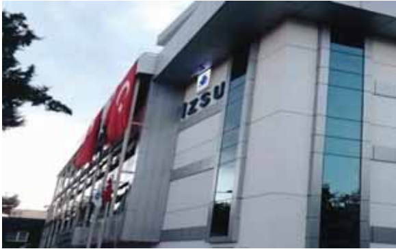
  ZSU Buca Ő ube M  d  rl     Hizmet Binası İnŐ aatı
