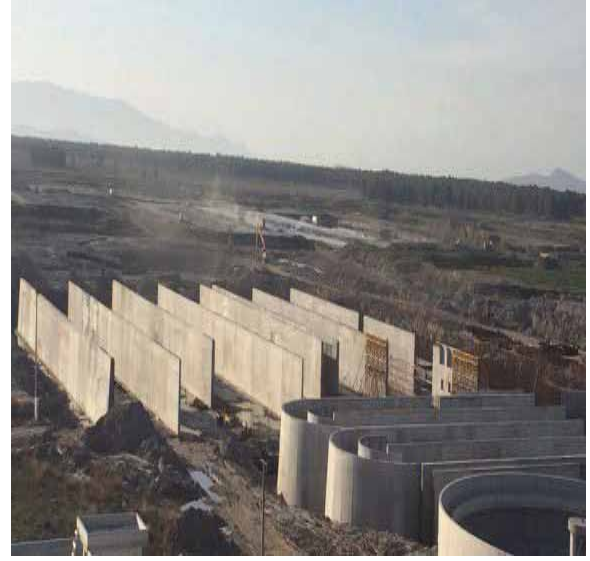
Çiğli Atıksu Arıtma Tesisi 4.Faz İnşaat Çalışmaları
