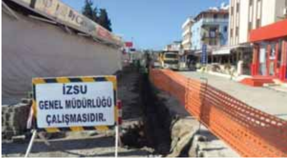
İzmir İli Menderes İlçesi Gümöldür Beldesi İçme Suyu Şebeke İnşaatı
