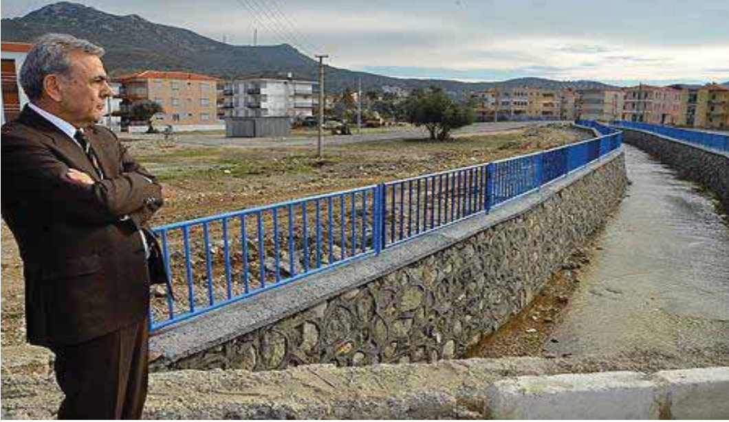
Asarlık çayı dere yataklarının düzenlenmesi çalışmaları
