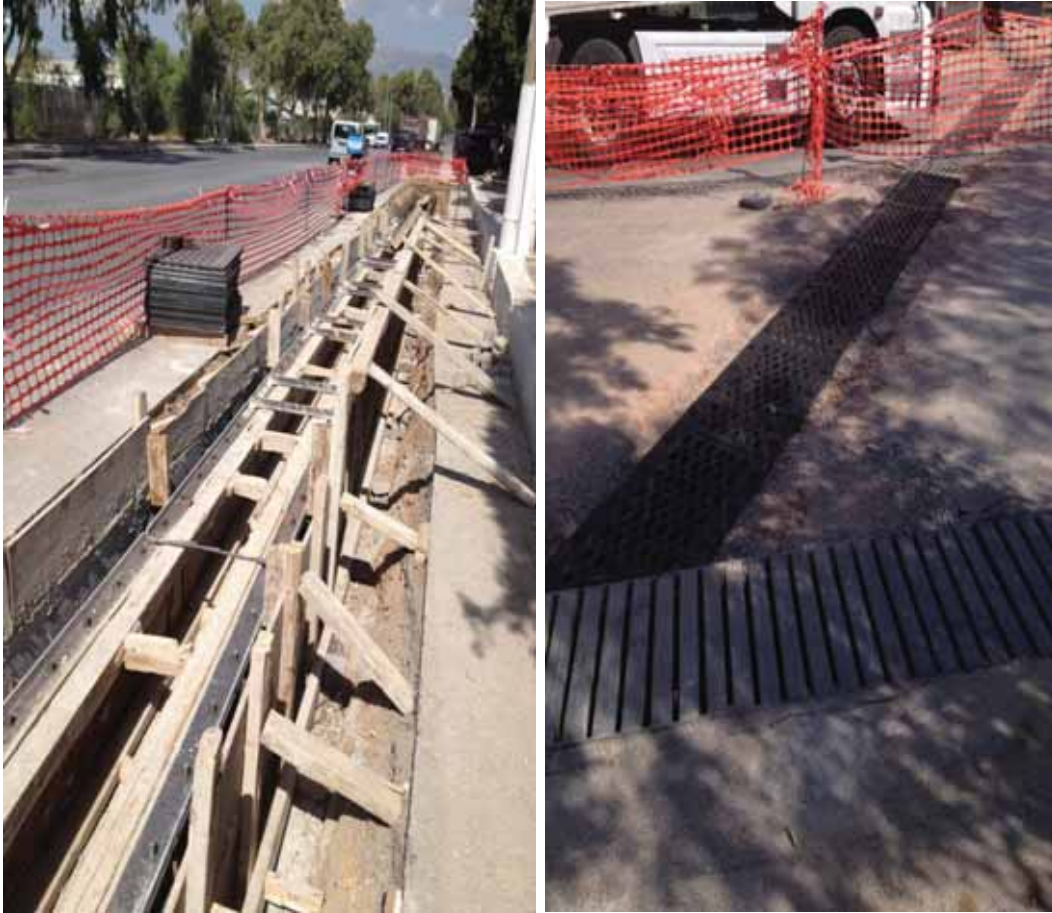
Kemalpaşa Mahallesi 5. Sanayi Sitesi Yağmursuyu Kanalı çalışmaları
