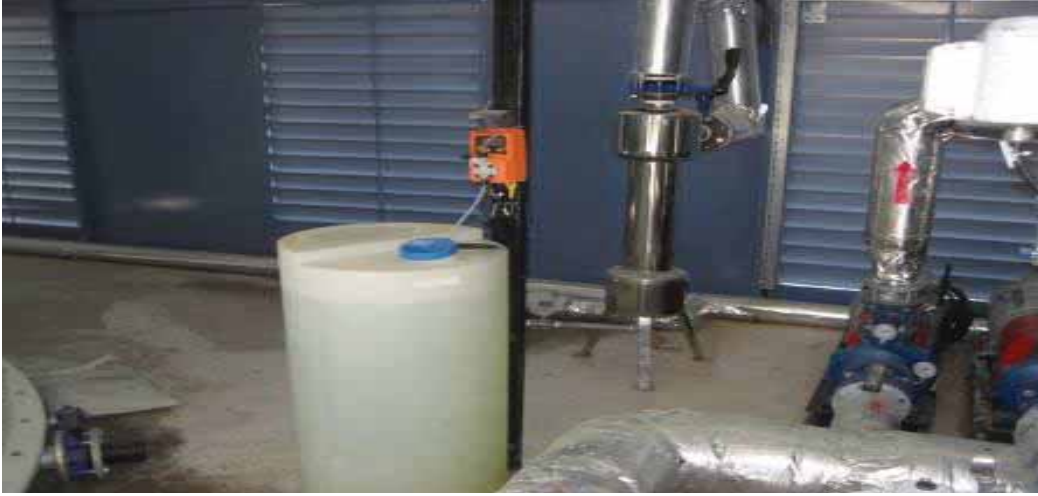
Paket Tipi Arıtma Tesisi Separatör Filtre ve Klor Tankı
