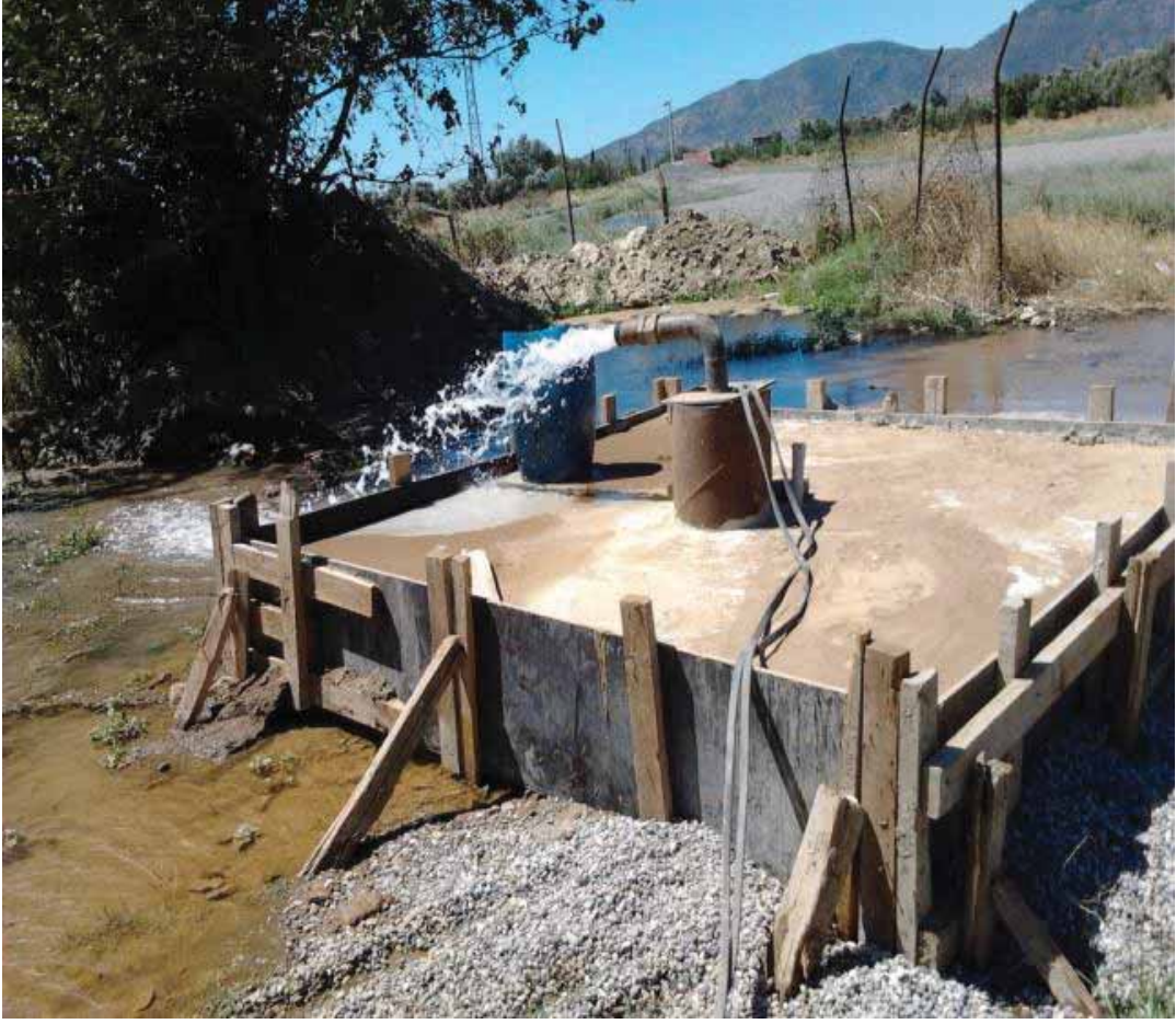
İzmir İli Bayındır İlçesi BY1, Sondaj Kuyusu çalışması
