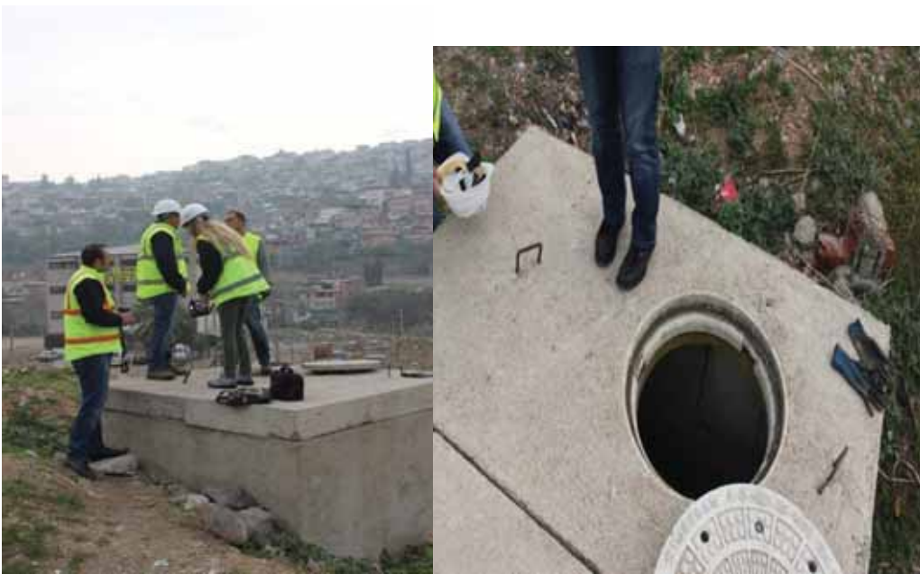
Su İsale ve Dağıtım Dairesi Başkanlığı'nın talebi üzerine Yeşildere'de yapılan içme suyu ana boru tamirati ile ilgili, 14.10.2013 tarihinde İşyeri Sağlık ve Güvenlik Birimimiz tarafından yerinde yapılan incelemeler
