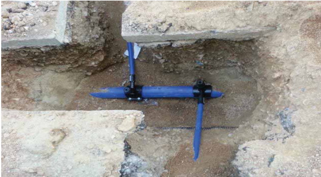
Buca Kırklar köyünde yapılan branşman bağlantı çalışmaları
