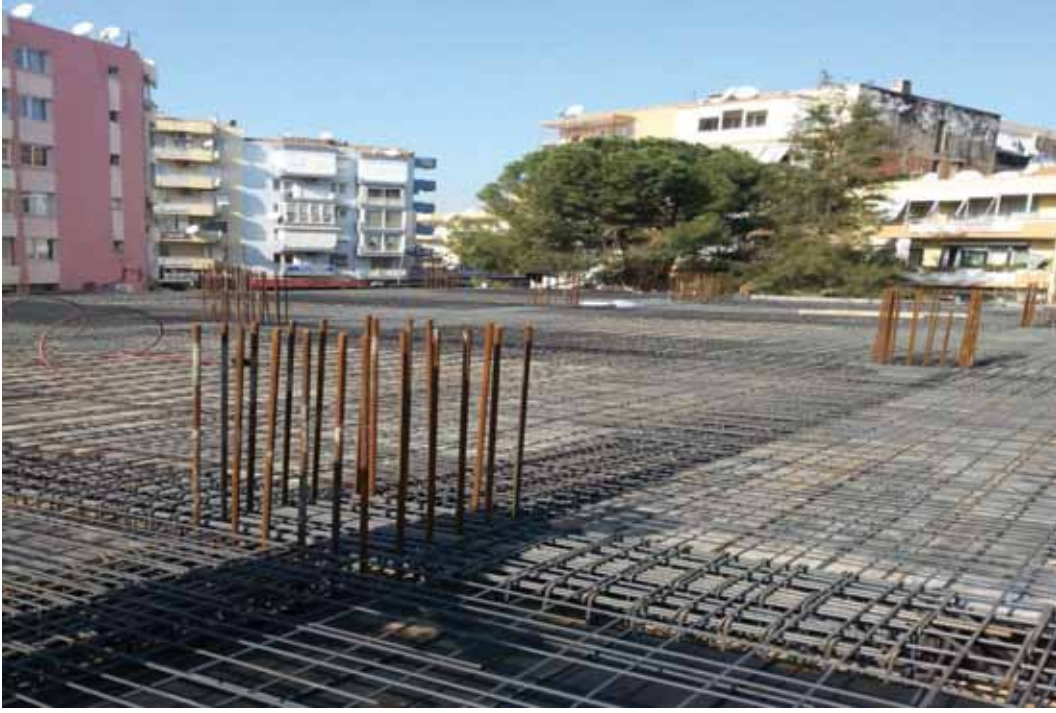
2. Bodrum kat döşeme imalatı
