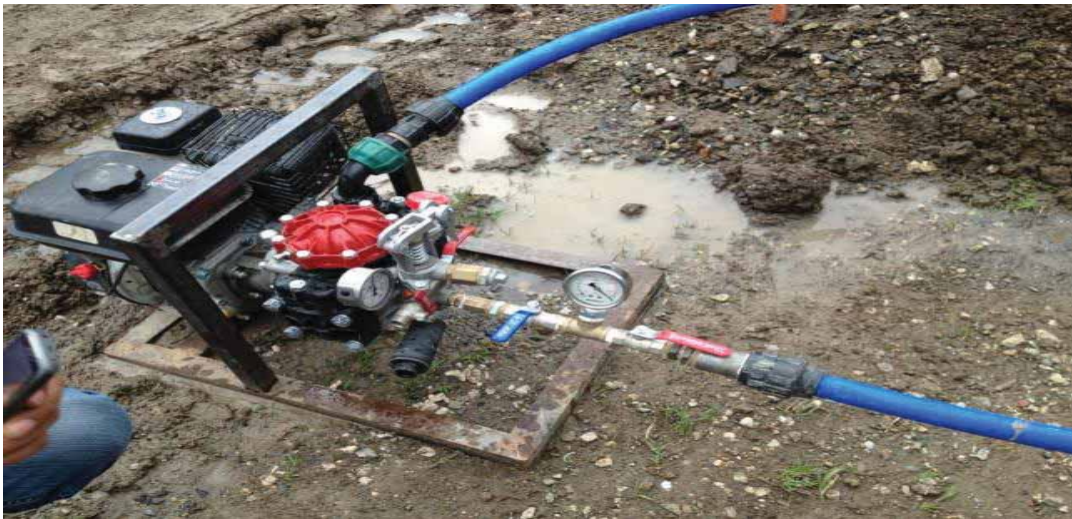
Çaltıldere Köyünde hidrostatik boru test çalışması
