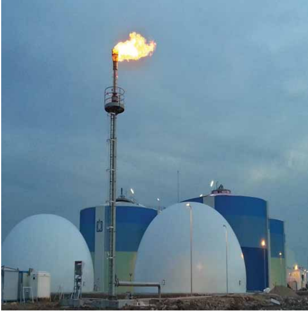
Gaz Toplama ve Çürütme Tankları
