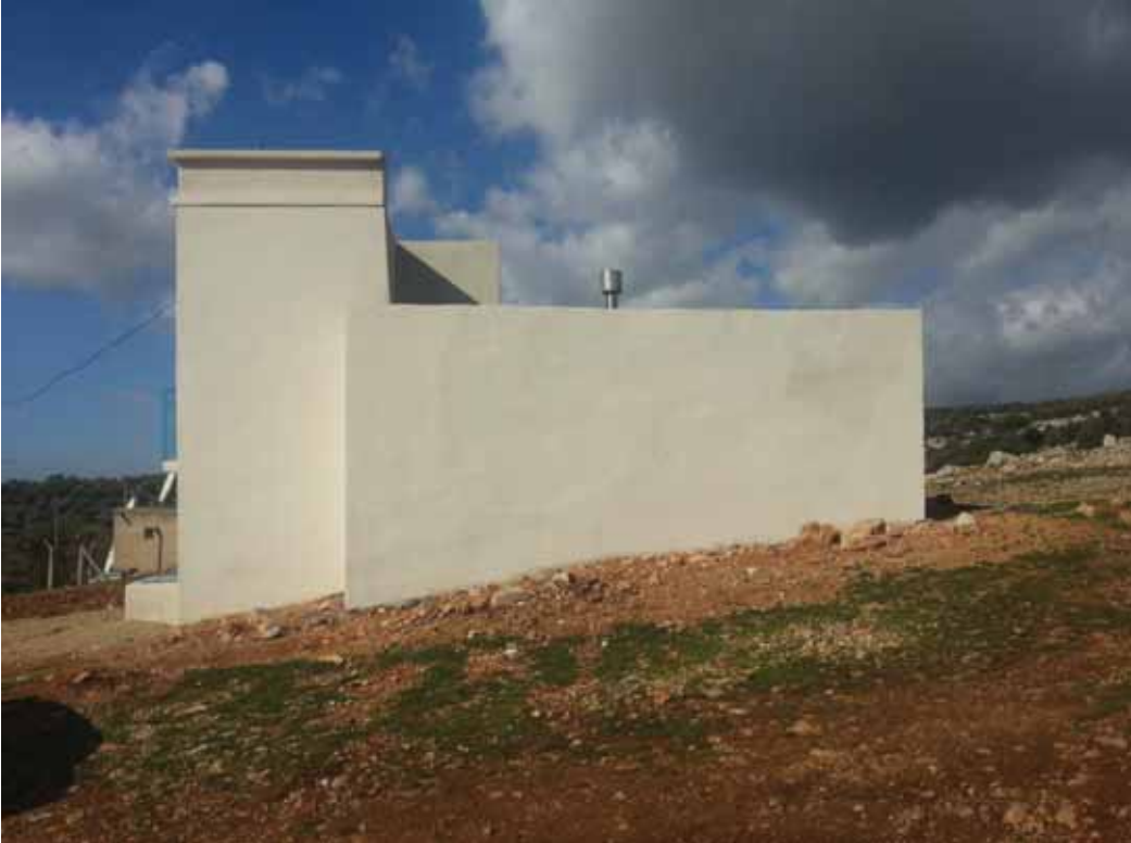
Sütçüler köyü su deposu onan m çalışması
