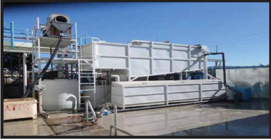
Abaloğlu Su Ürünleri ve Yem San.Tic.Ltd.Şti. Arıtma Tesisi
