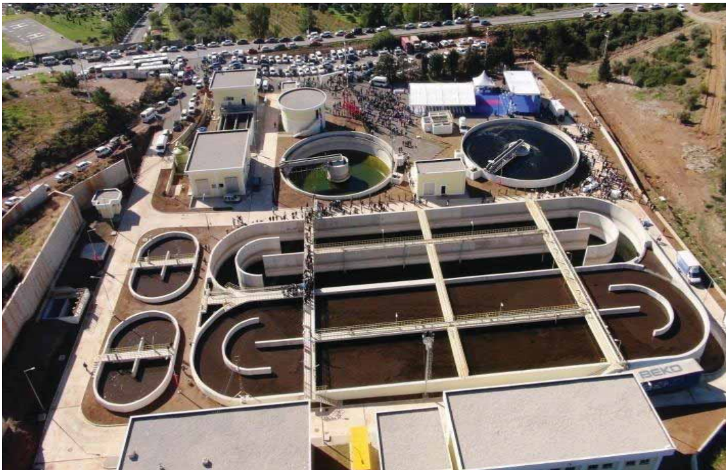
Özdere Atıksu Arıtma Tesisi genel görünümü
