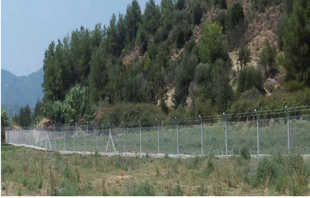
Tahtalı Barajı 6.Etap Mutlak Sınır Tel Çit Yapım İşi
