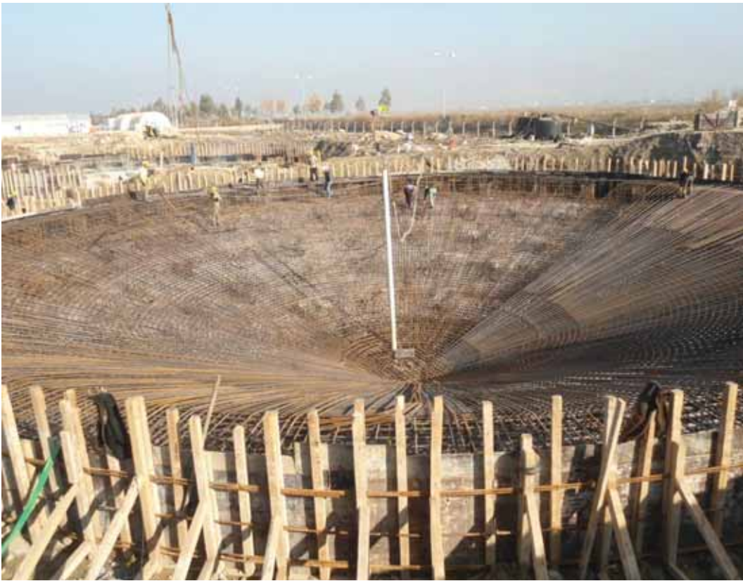
İzasyonu yapılmış koruma şapı atılmış temelde demir d şeme alıřmaları
