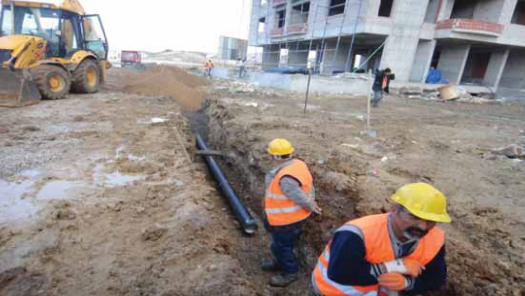
Aliğa İlçesinde içme suyu boru hattı döşenmesi çalışmaları
