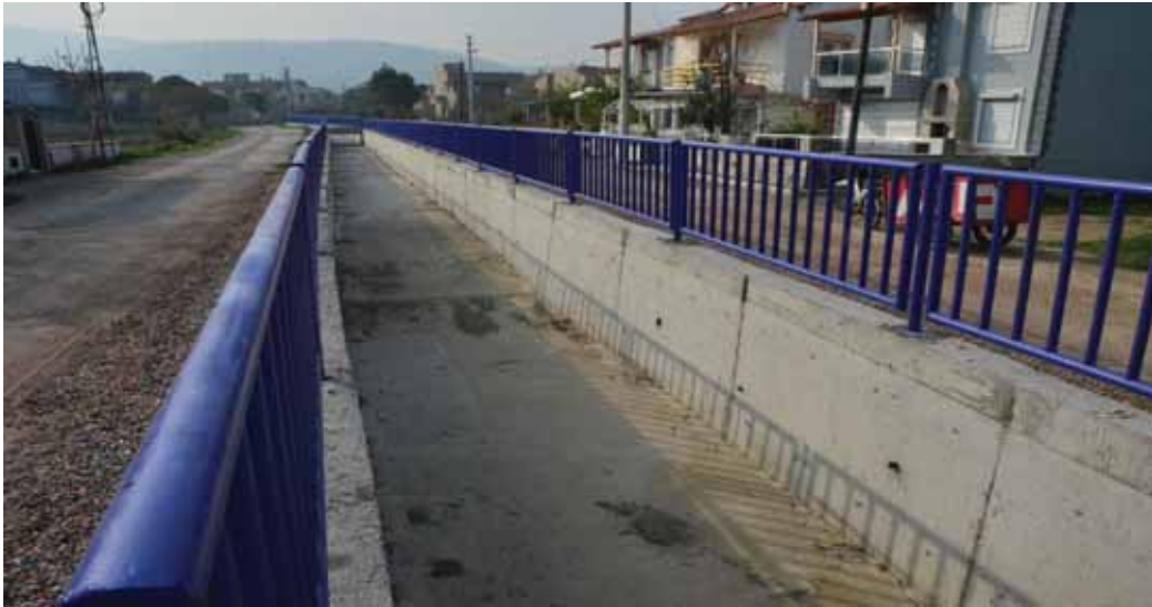
Bozyaka Deresi Islahı ve Kanalizasyon İnşaatı çalışması
