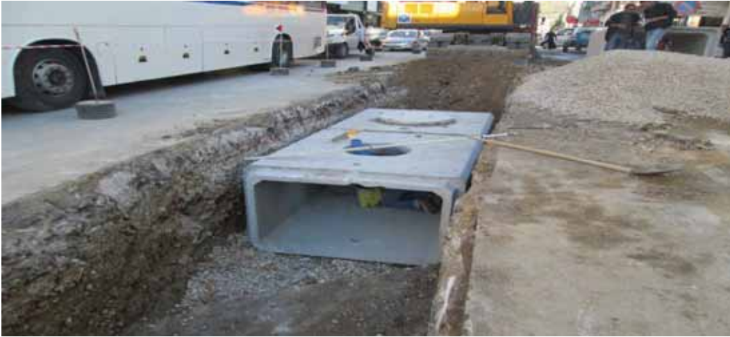
Kemalpaşa caddesi prefabrik menfez uygulamasıyla yağmursuyu çalışması
