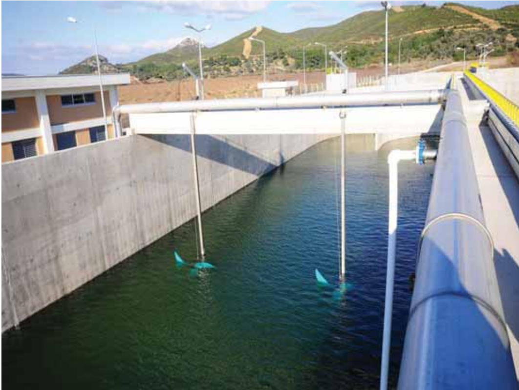
Doğ anbey Atıksu Arıtma Tesisinden görünüm
