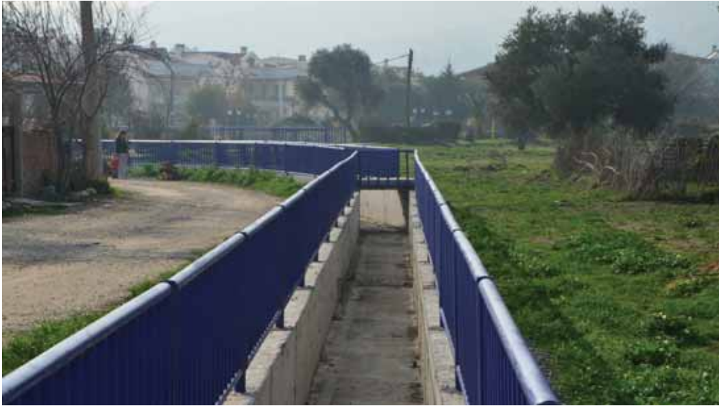
Bozyaka Deresi Islahı ve Kanalizasyon İnşaatı çalışması
