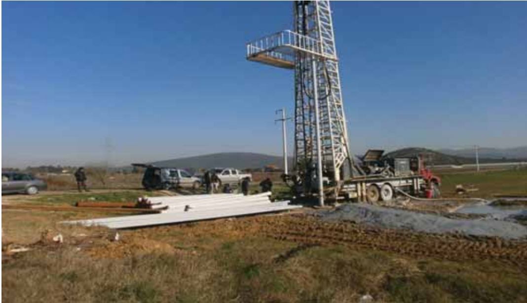
Menderes İlçesi Ataköy A-1 boru indirme çalışması
