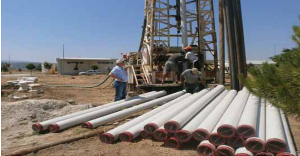
Torbalı İlçesi Ayranalar Antma tesisi T6, boru indirme hazırlıkları
