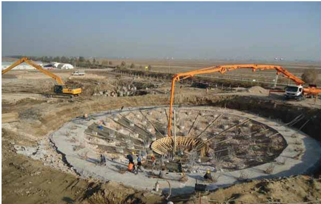
Grobeton çalışmaları
