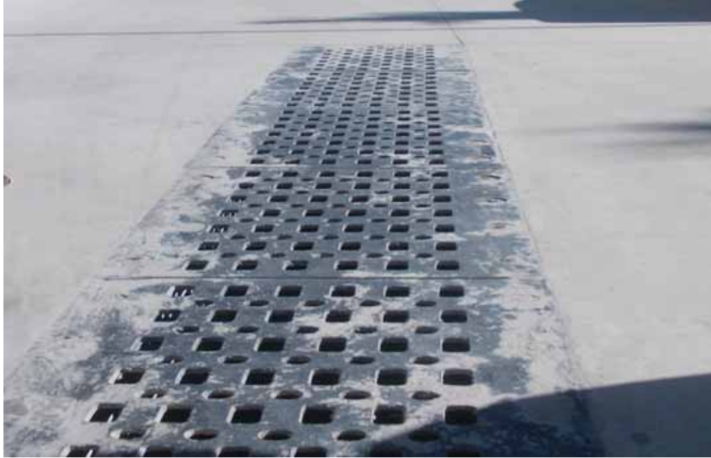
Kemalpaşa Mah. 7093/1, Sokak Yağmursuyu çalışmaları
