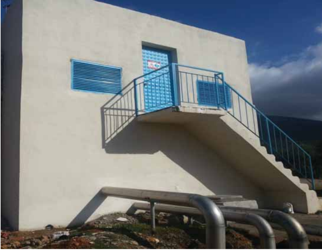
Yenmiş köyü su deposu onan m çalışması
