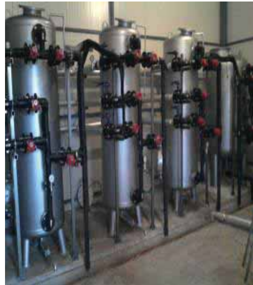
Paket Tipi Arıtma Tesisi Filtre Tankları ve Tesisatı
