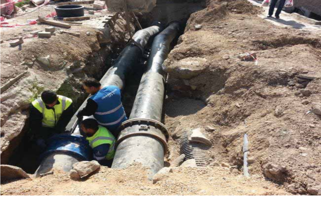
Selvili Pompa Kadifekale Arası Terfi Hattı İnşaatı çalışmaları
