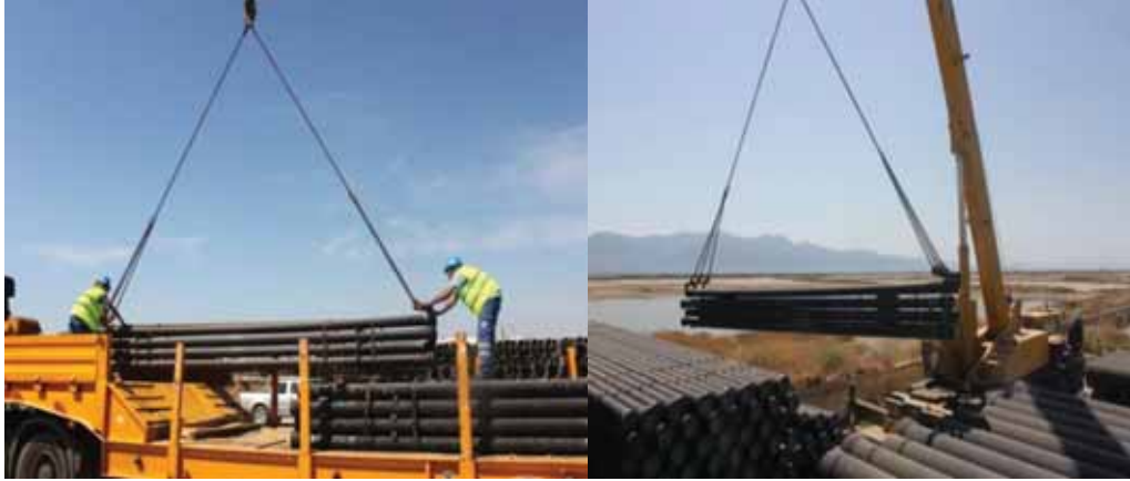
Çiğli Atıksu Arıtma Tesisi boru stok sahası
