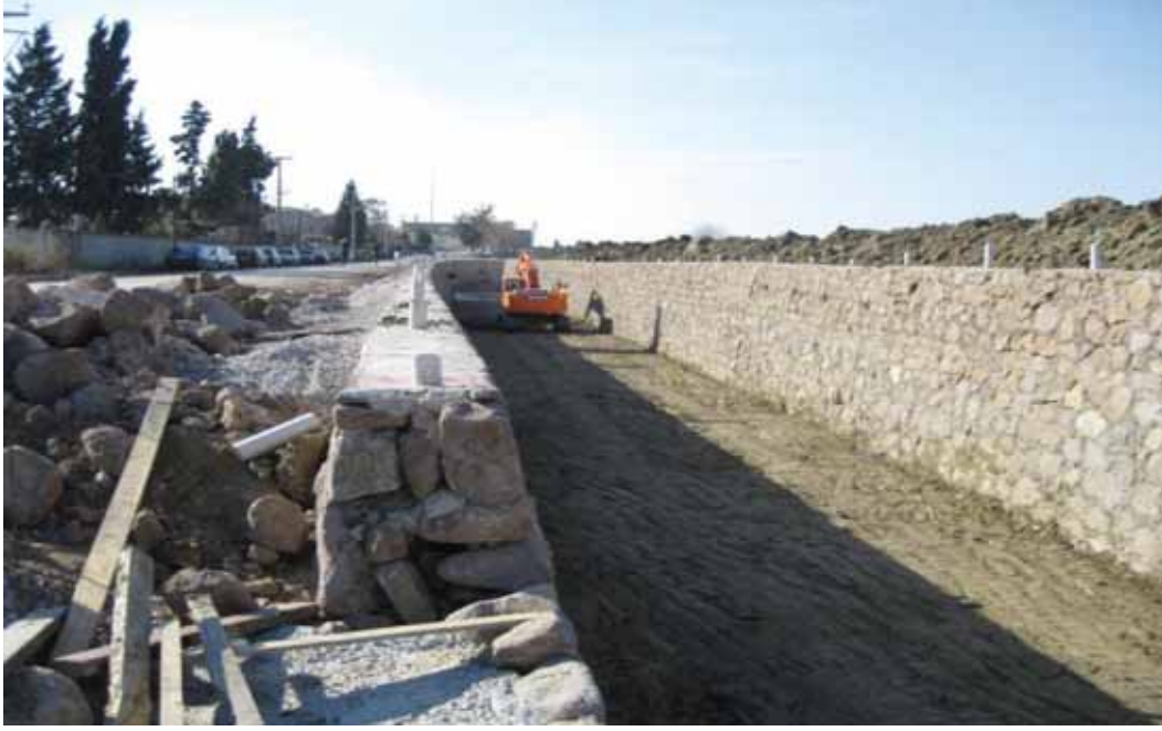
Ahıhdır deresi taş duvarlı dere ıslah çalışmaları
