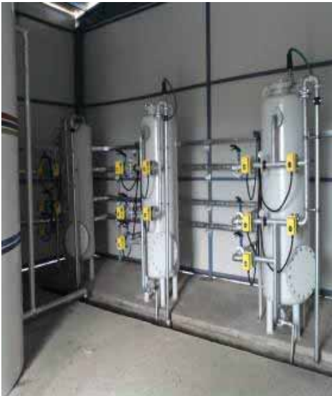
Paket Tipi Arıtma Tesisi Filtre Tankları ve Tesisatı
