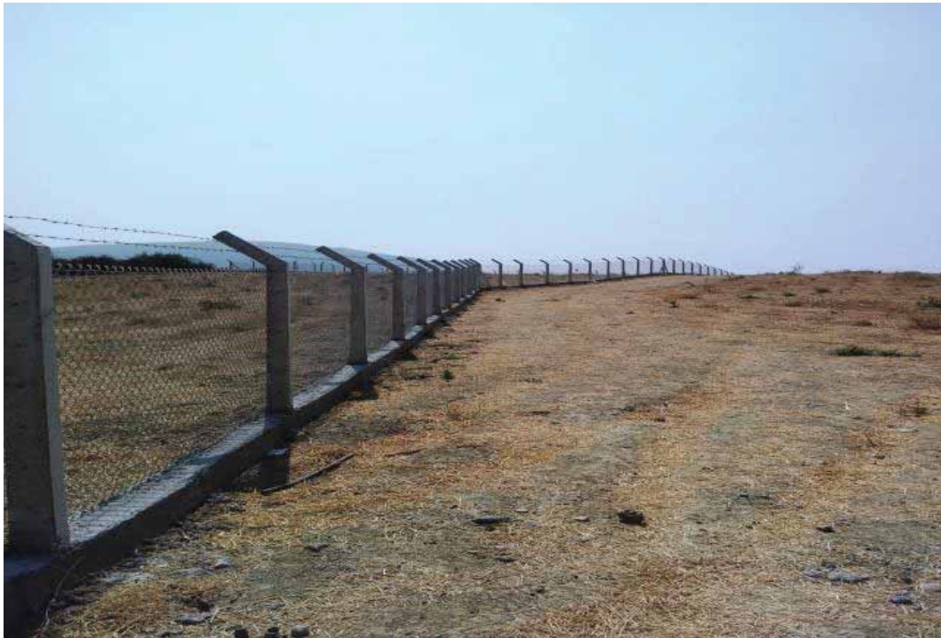
Tahtalı Barajı 6.Etap Mutlak Sınır Tel Çit Yapım İşi
