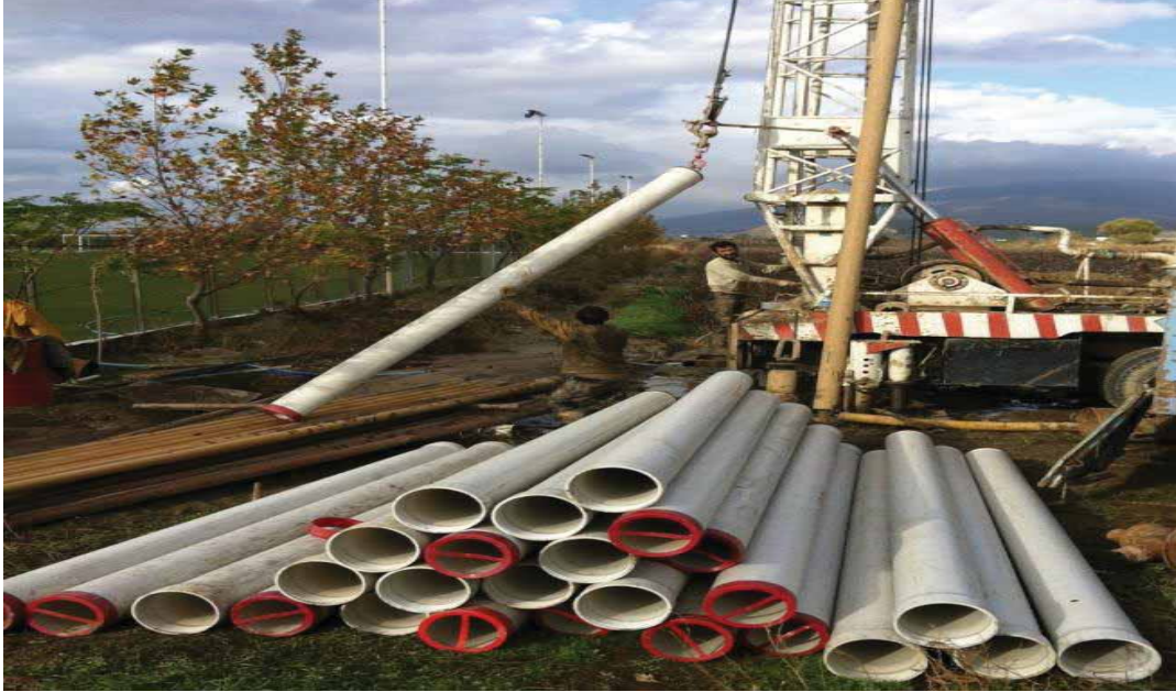
Menemen İlçesi ÇV1, Sondaj Kuyusuna boru indirme çalışması
