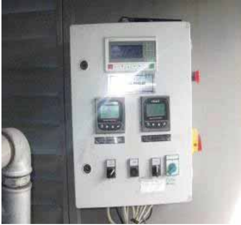
Paket Tipi Arıtma Tesisi Kumanda Panosu
