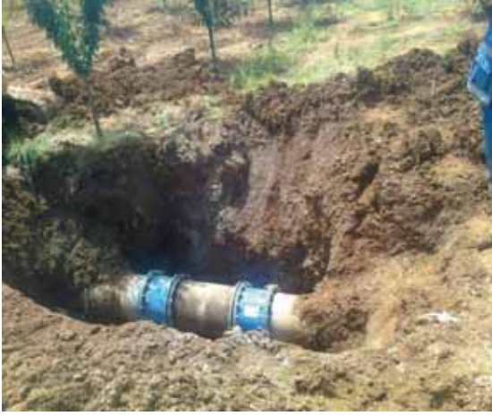
Ekiplerimizin yaptığı Ana Boru arıza çalışmaları
