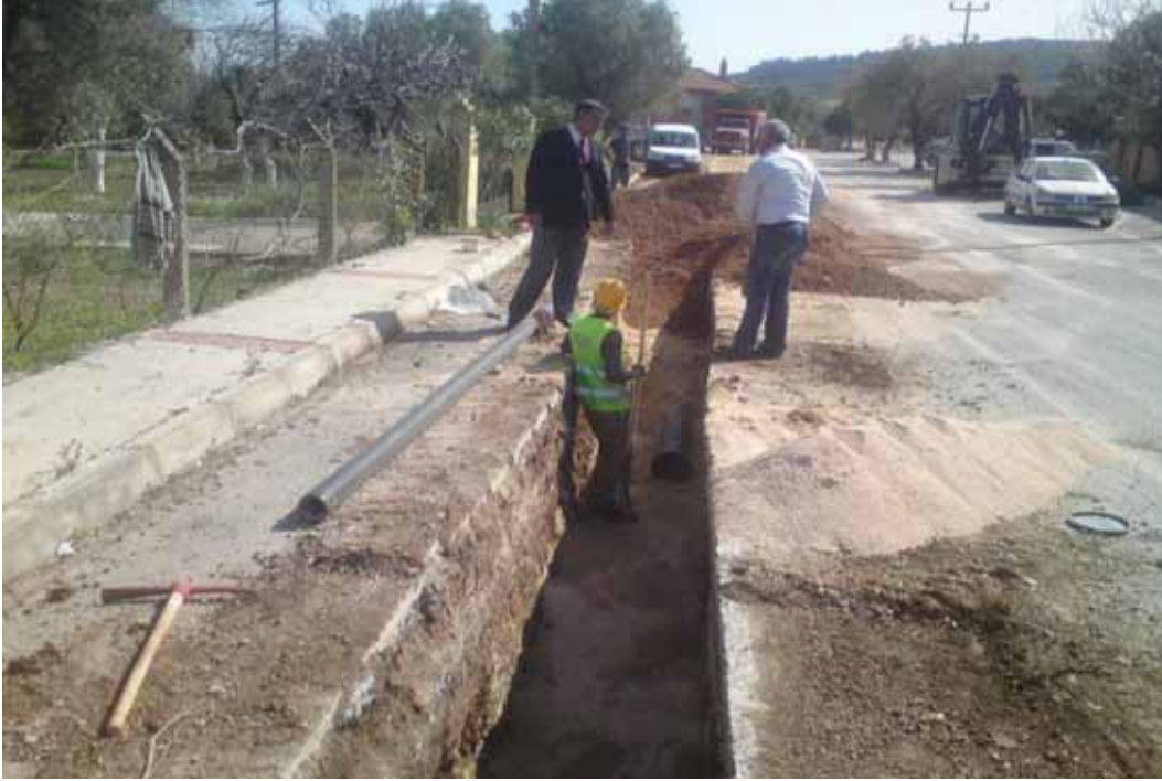
İskele Mahallesi İçmesuyu Şebeke Çalışması
