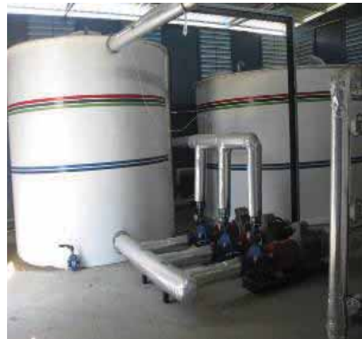
Ham su ve ürün suyu depoları
