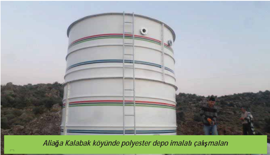
Aliağa Kalabak köyünde polyester depo imalatı çalışmaları
