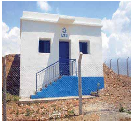
İçmesuyu Deposu Yeni Hali
