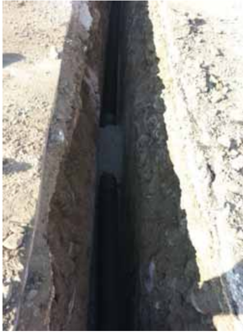
Urla İlçesi Atatürk Mahallesi HDPE koruğu boru döşenmesi ve dolgu çalışması
