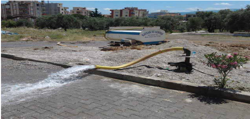
Kemalpaşa İlçesi A3 Su Sondaj Kuyusu çalışması
