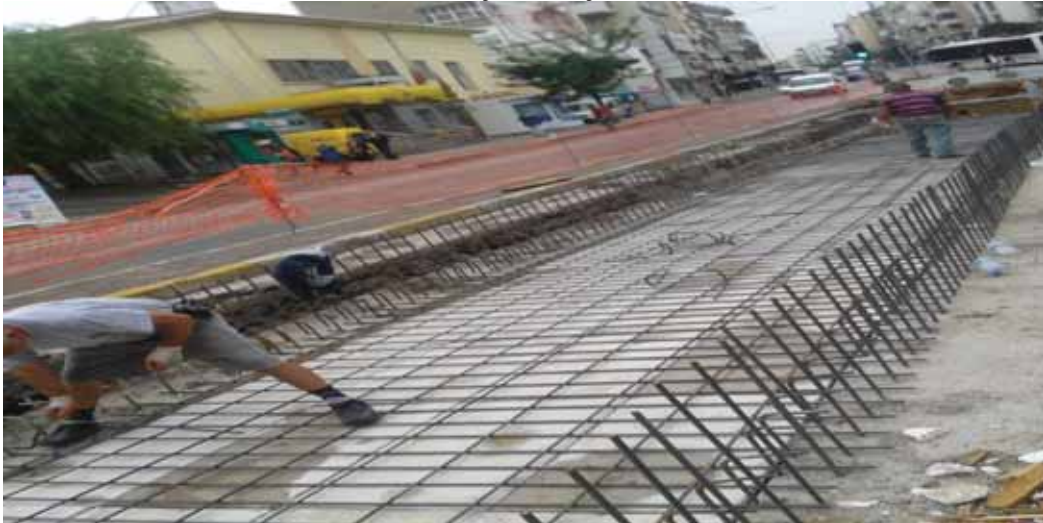
Mehmet Akif caddesi Yağmursuyu Kanalı çalışması
