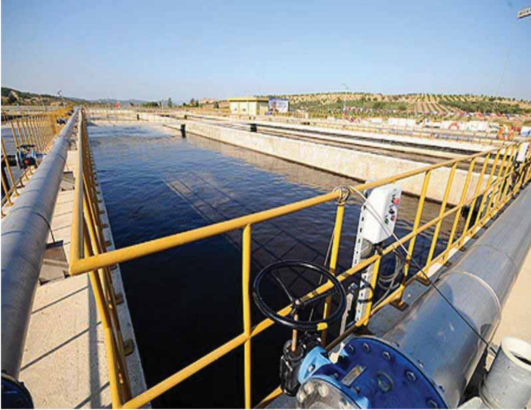
Doğ anbey Atıksu Arıtma Tesisinden görünüm
