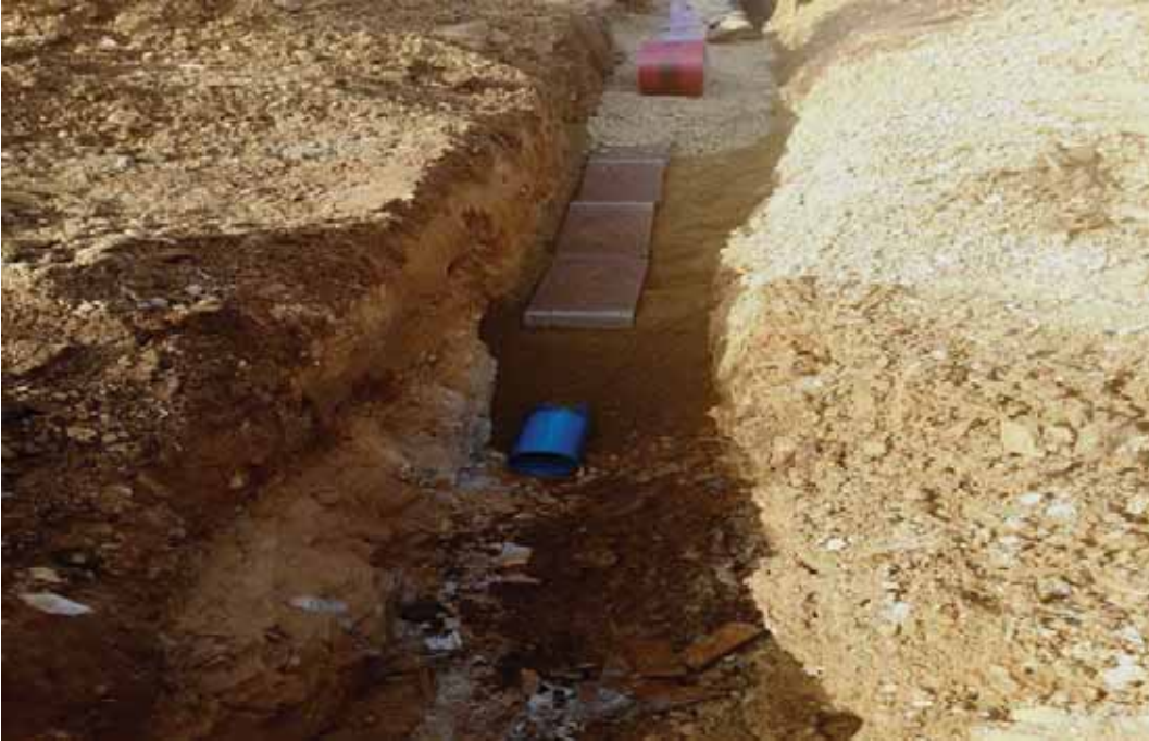
Helvacı ve Ormanköy köyüne içme suyu elektrik hattı döşenmesi çalışmaları
