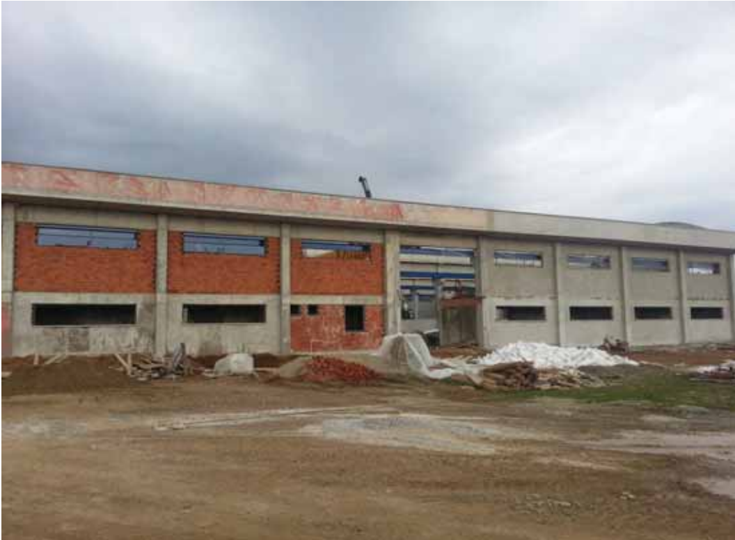
Görece Ambar Binası İnşaatı
