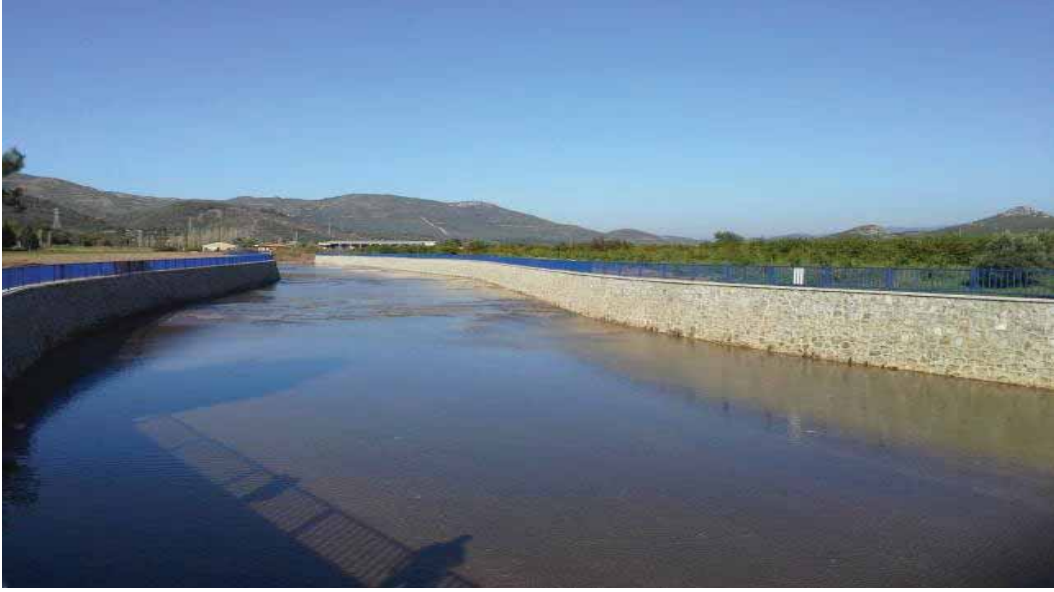
Karakoç Deresi taş duvar kesitli ıslah çalışması
