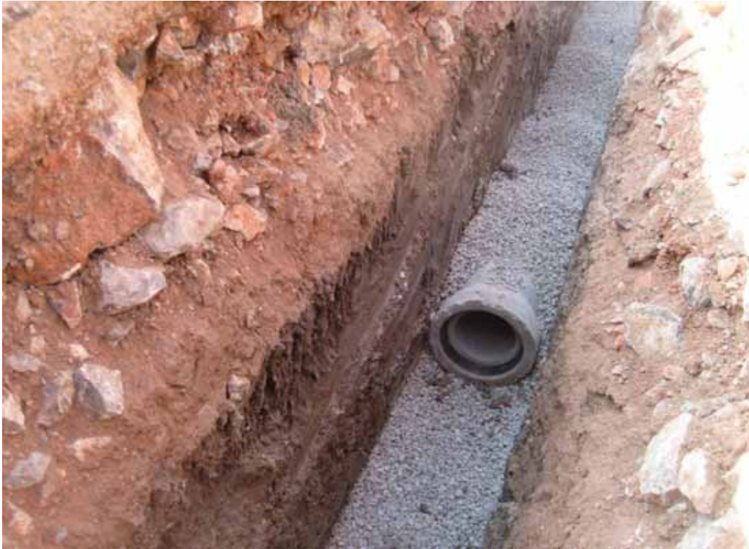
Gaziemir İlçesi Sarnıç'da E.C.B.B döşenmesi
