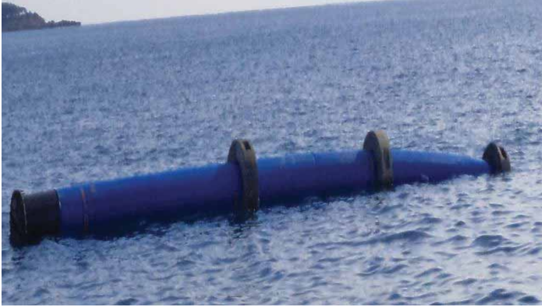
Atıksu Antma Tesisi Deşarj hattı boruları denize indirilirken
