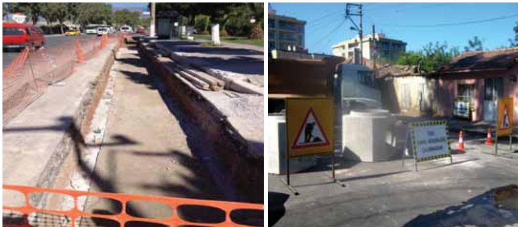
Yağmursuyu Kanalı çalışmaları
