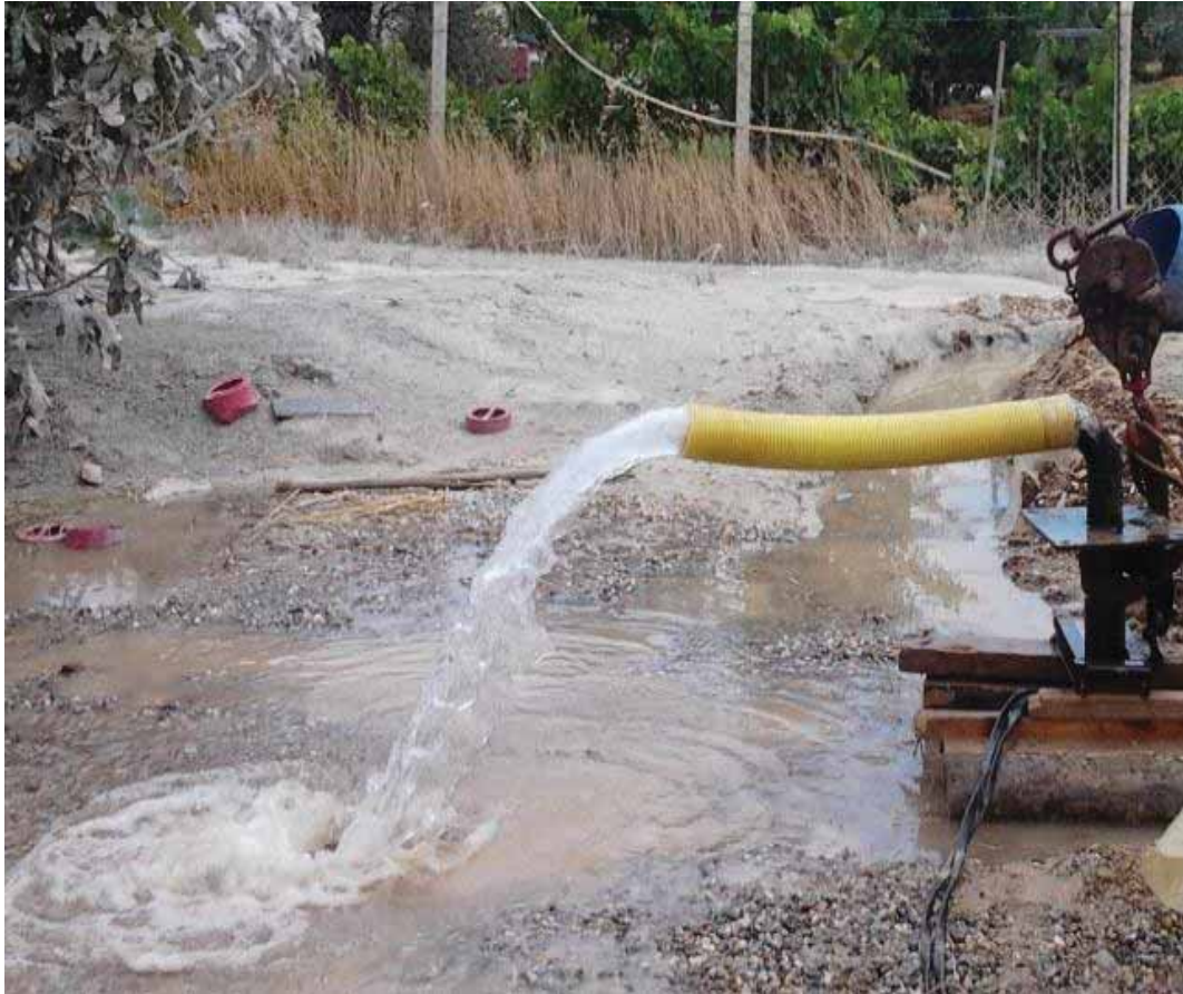
Urla İlçesi Kuşçular Köyü K1, sondaj kuyusu çalışmaları
