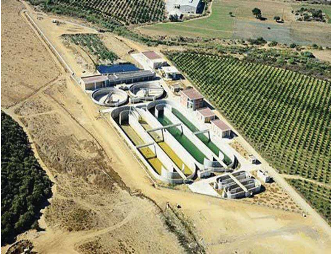
Doğanbey Atıksu Antma Tesisinden görünüm
