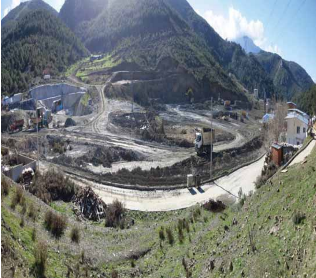
İçmesuyu Arıtma Tesisi Kazı çalışmaları
