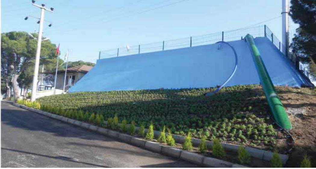
Menemen Tepe Depo ve Terfi Merkezi Yeni Hali
