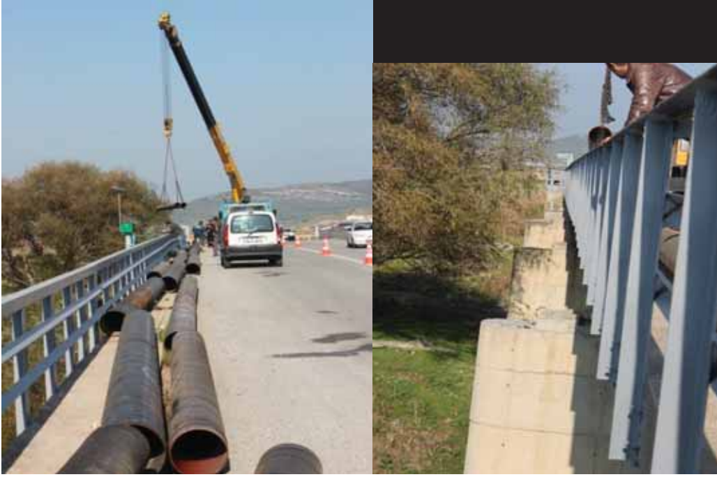
Menemen dere geçişi işiyle ilgili , 18.11.2013İşyeri Sağlık ve Güvenlik Birimimiz tarafından yerinde yapılan incelemeler
