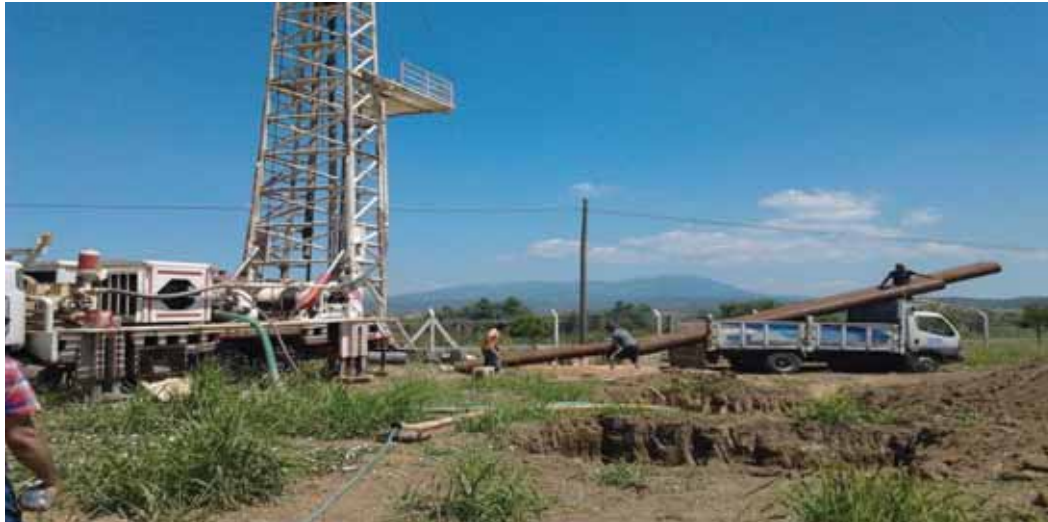
Torbalı İlçesi Çaybaşı Eyerici Mahallesi T7, boru indirme çalışması
