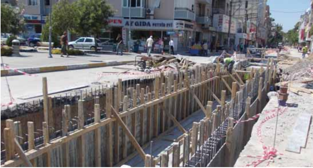
Mehmet Akif caddesi yağmursuyu kanalı çalışması
