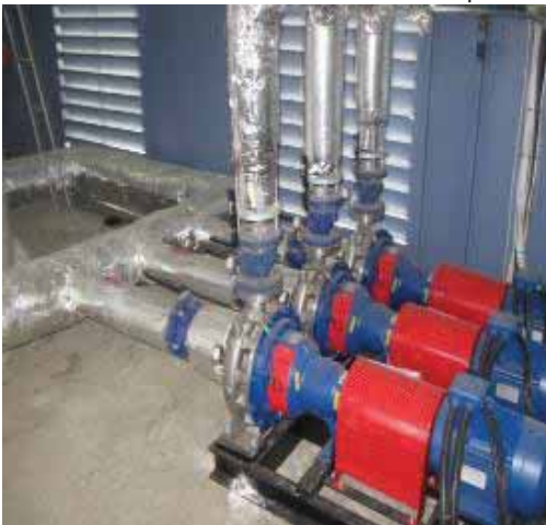
Paket Tipi Arıtma Tesisi Pompası
