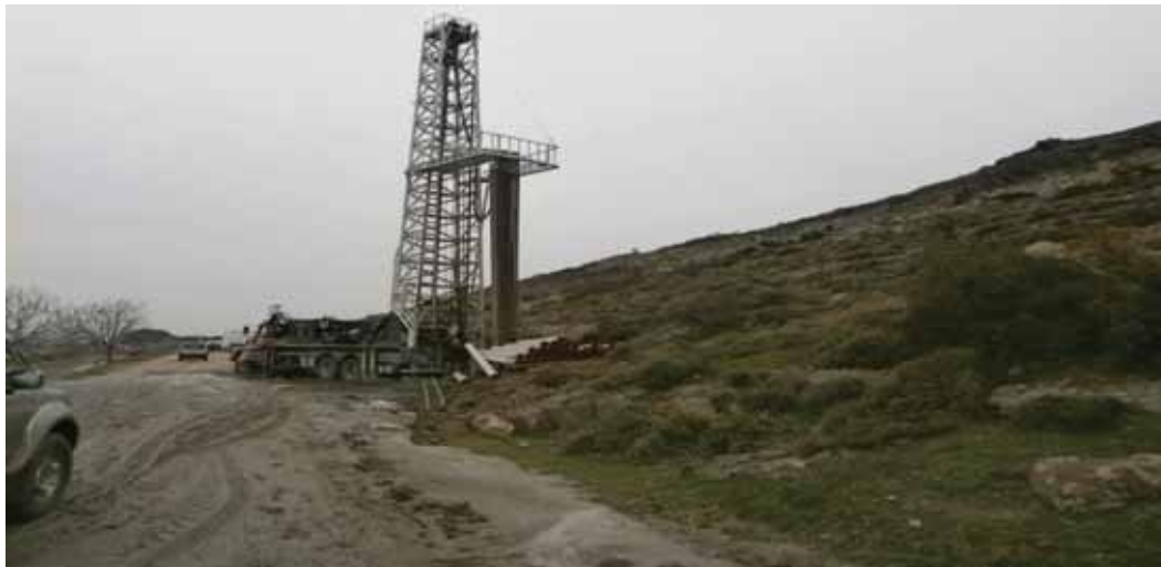
Menemen İlçesi Haykıran Köyü H-1 kuyusu sondaj çalışması
