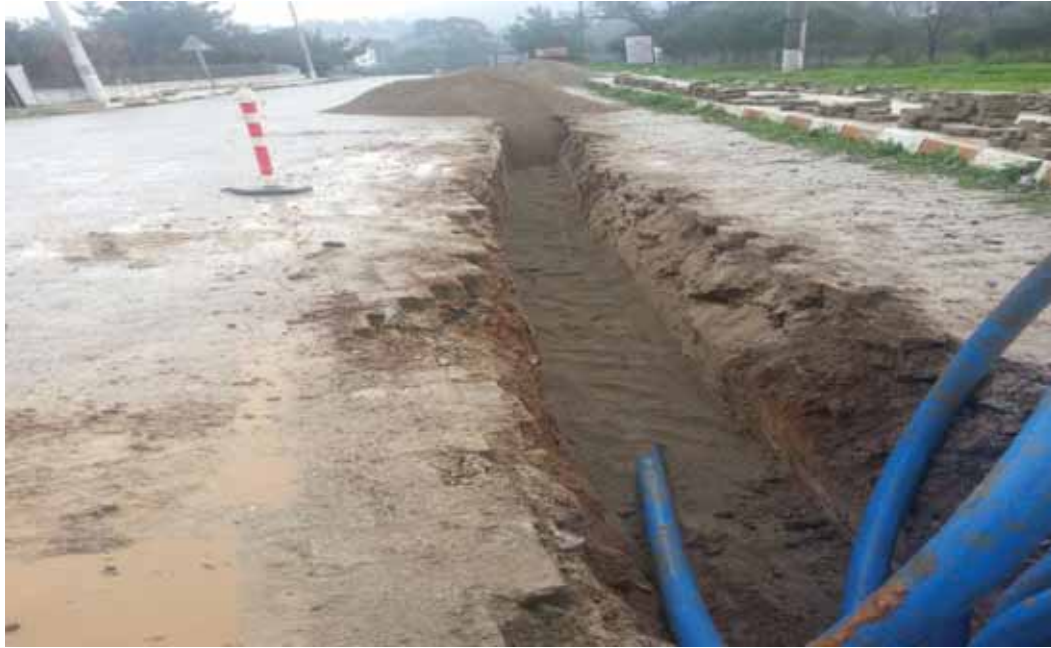
Seferihisar İlçesi Orhanlı köyü İçmesuyu Şebeke Çalışmaları
