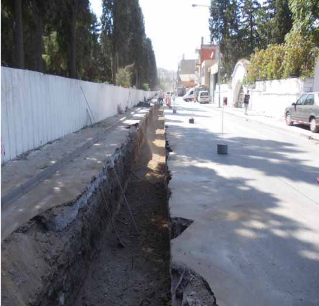
Kemalpaşa Caddesi Yağmursuyu kazı çalışmaları
