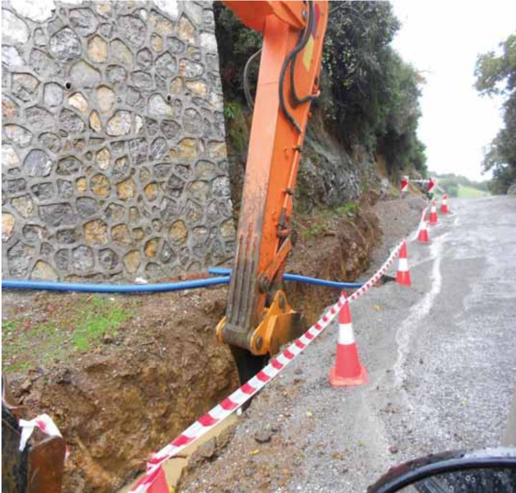
Seferihisar İlçesi Orhanlı köyü İçmesuyu şebeke çalışmaları
