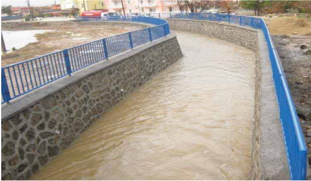
Yeni Foça da Dere Yataklarının Düzenlenmesi çalışması
