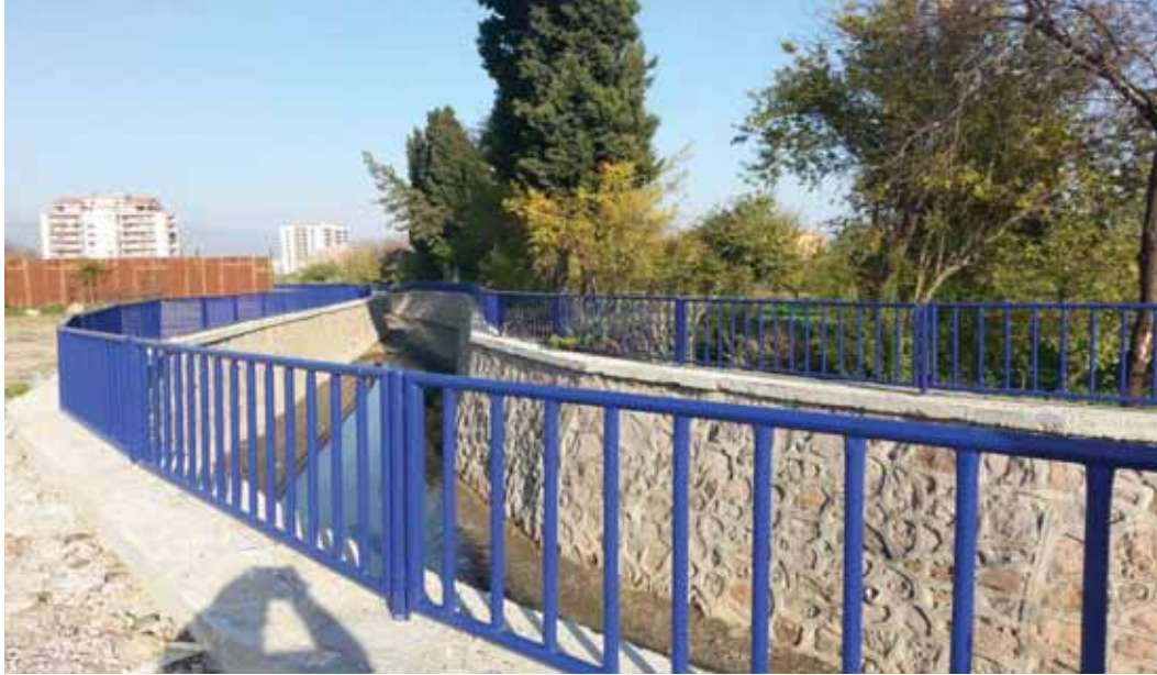
Dere ıslah çalışmaları tamamlanmış durumu
