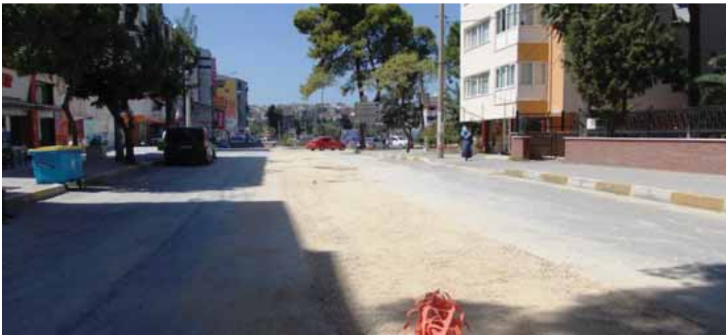
Mehmet Akif caddesi Yağmursuyu Kanalı tamamlanmış durumu
