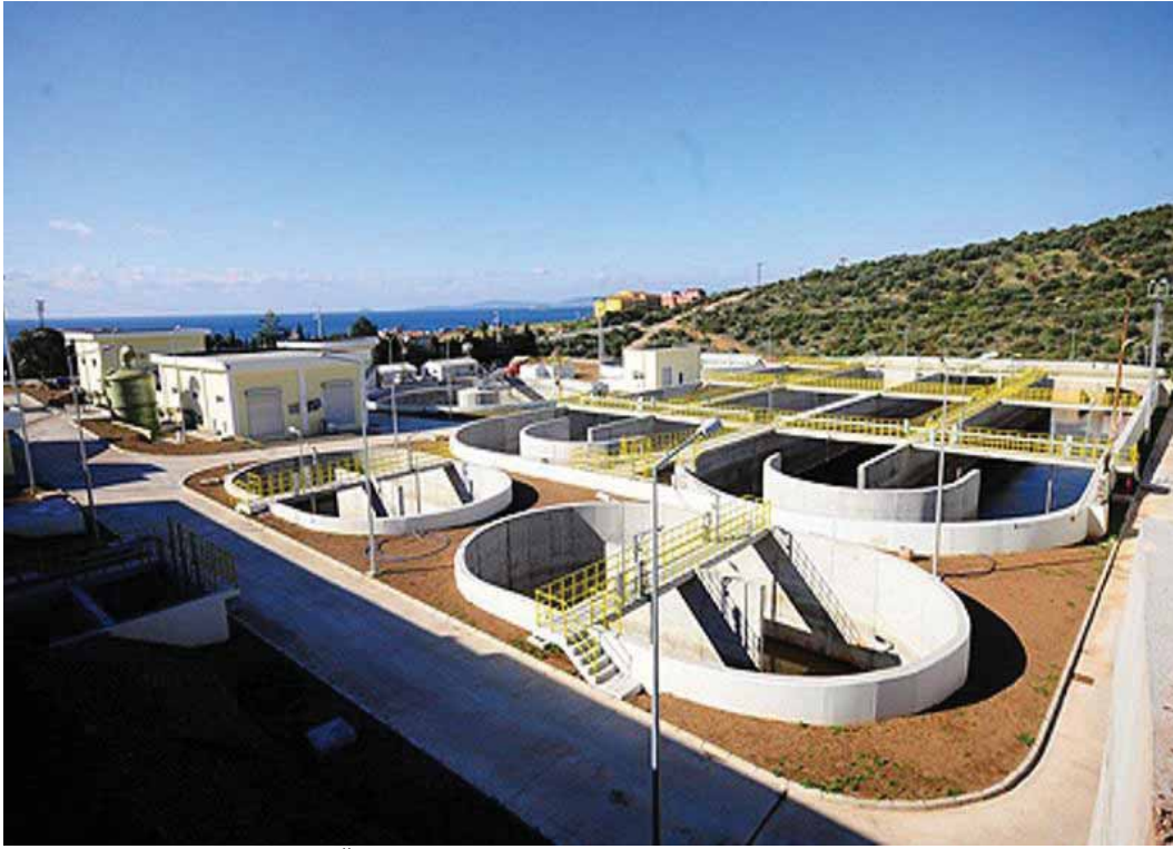
Özdere Atıksu Arıtma Tesisi genel görünümü
