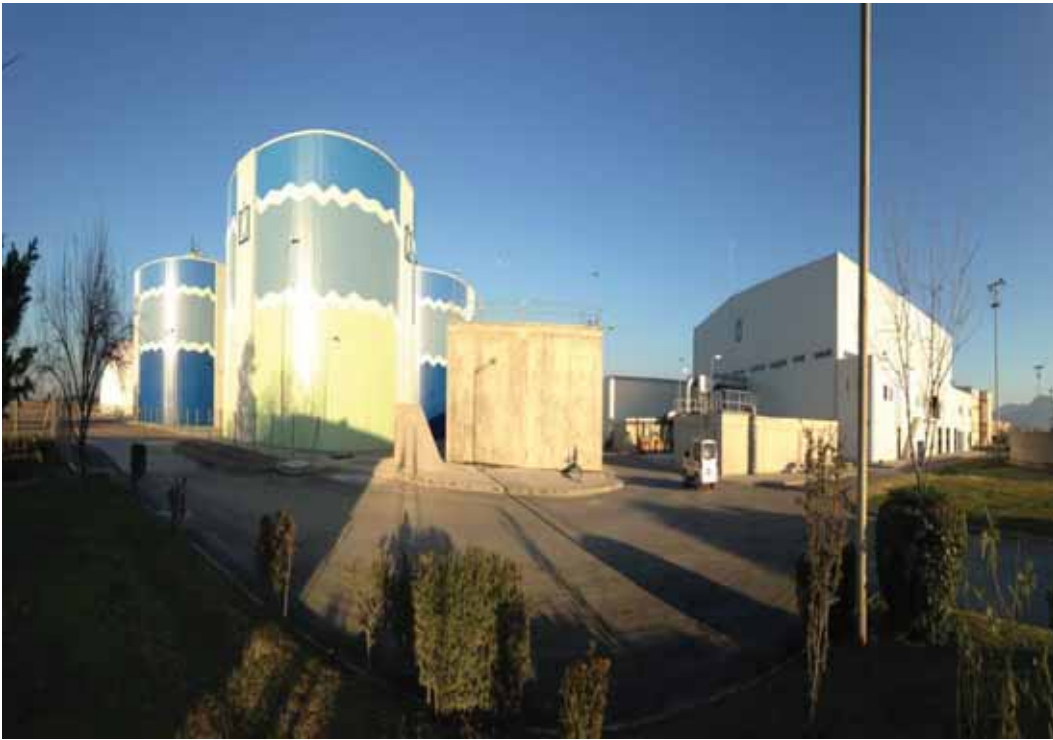
Çamur Çürütme ve Kurutma Tesisi genel görünüm
