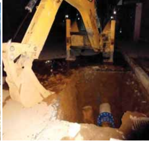
Ekiplerimizin yaptığı Ana Boru arıza çalışmaları
