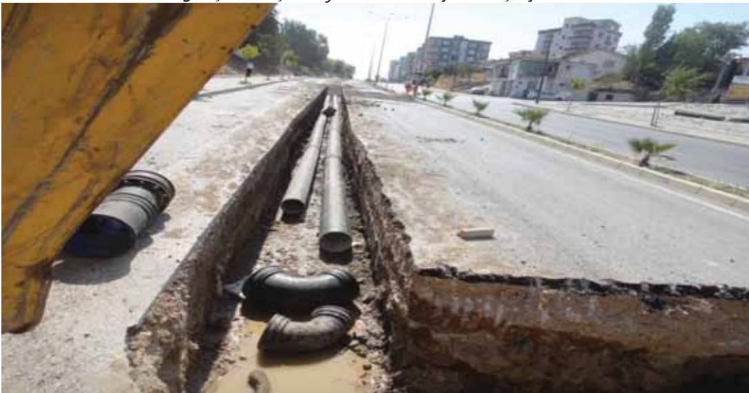
Aliğa İlçesinde içme suyu boru hattı döşenmesi çalışmaları
