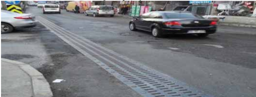
Yağmursuyu çalışmaları tamamlanmış durumu
