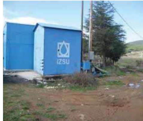
Paket Tipi Arıtma Tesisi Kabini
