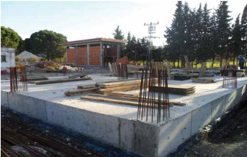
Aliağa Güzelhisar İçmesuyu Pompa binası subasman kotu çalışması
