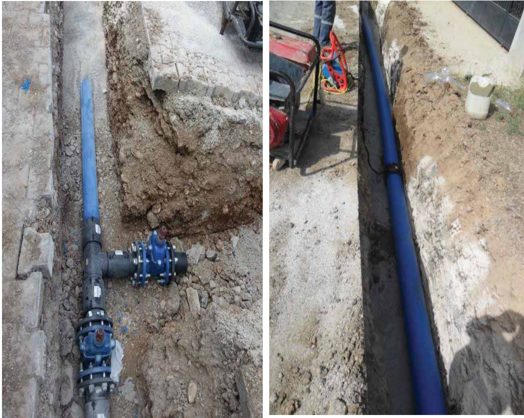
Yenmiş Köylerinde İçmesuyu Şebeke Çalışmaları
