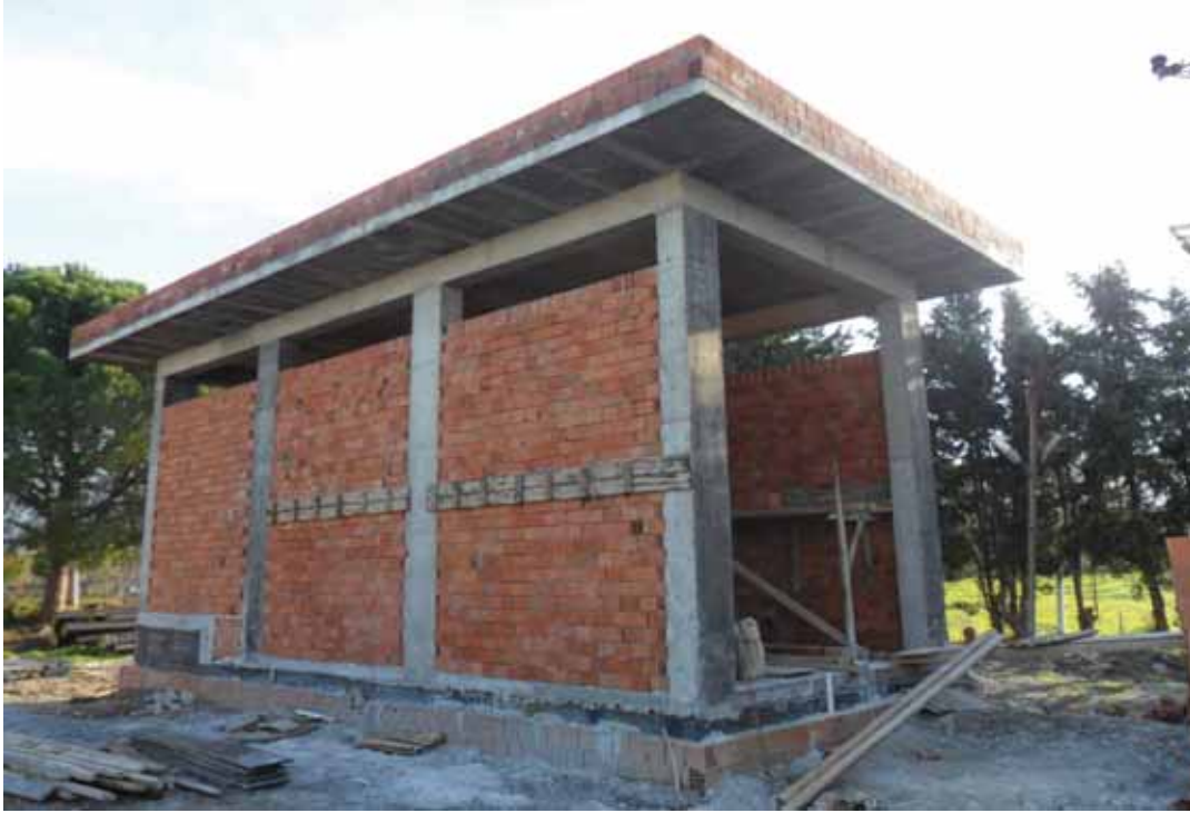
Aliağa Güzelhisar İçmesuyu Pompa İstasyonu İnşaatı çalışmaları
