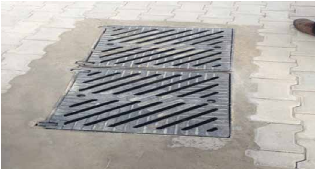
Yağmursuyu ızgarası çalışması
