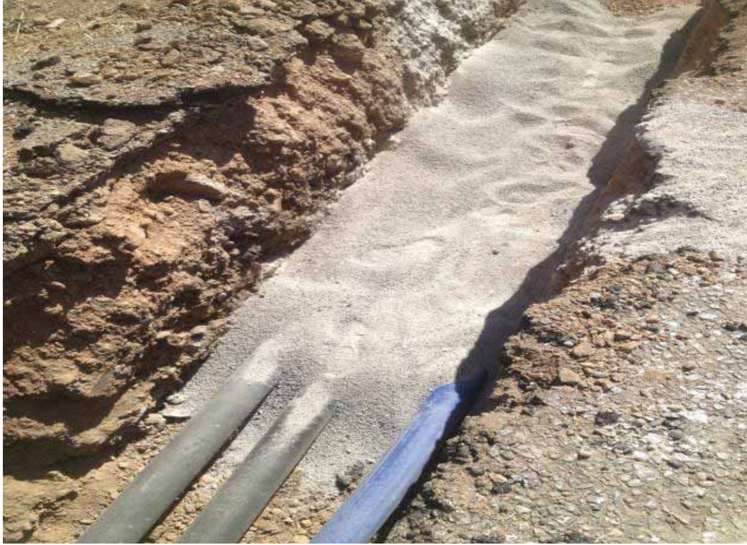
Bulgurca Köyünde yapılan Düktil Font ve HDPE boru döşeme çalışması
