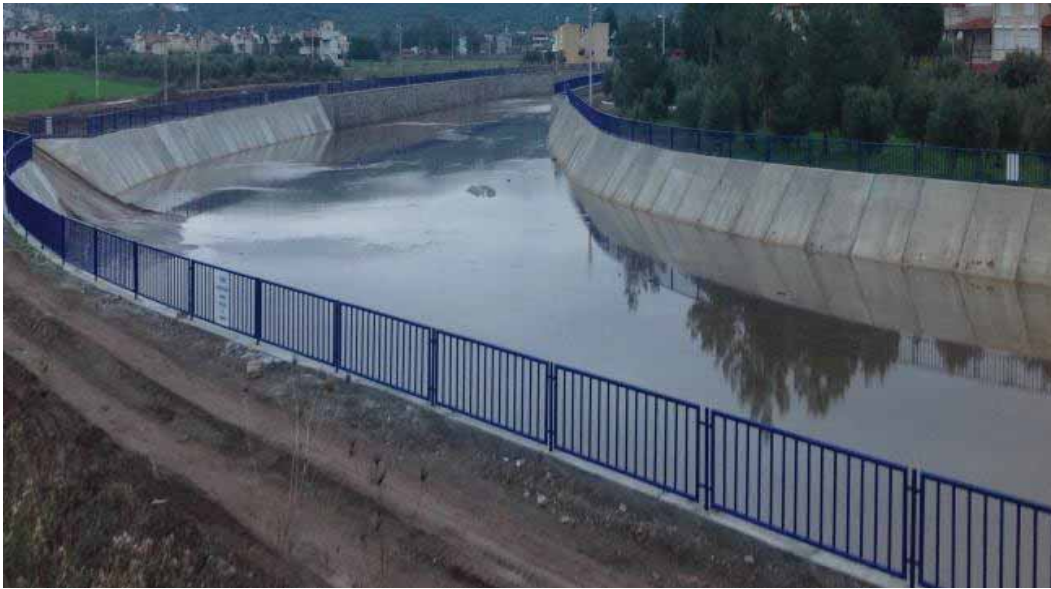
Karakoç deresi betonarme trapez kesitli çalışma örnekleri
