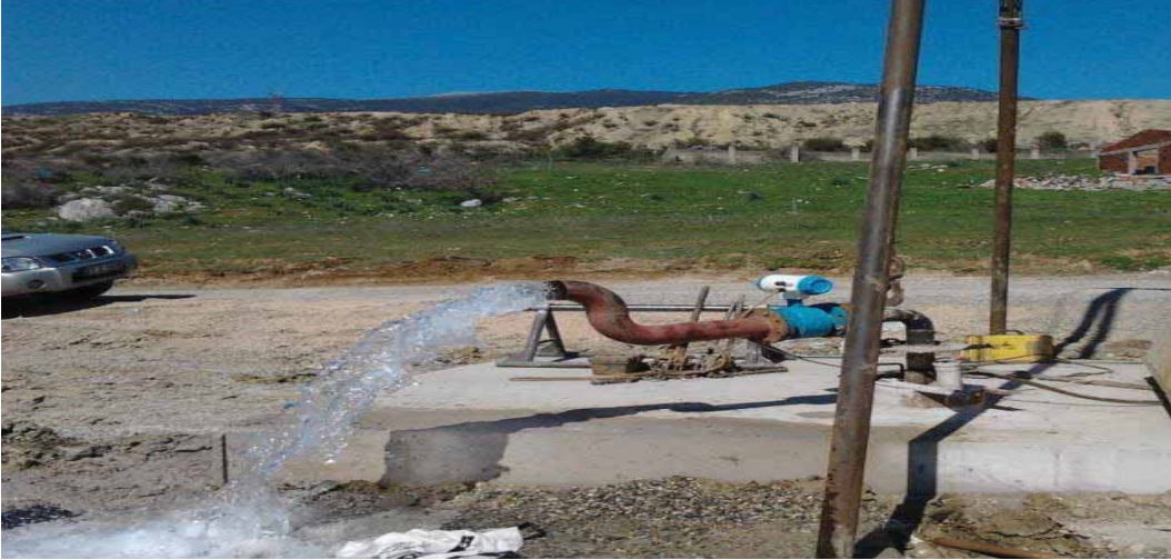
Kemalpaşa İlçesi Çambel Köyü Ç1 Su Sondaj Kuyusu çalışması
