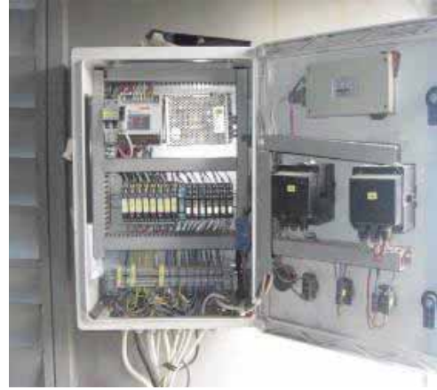
Paket Tipi Arıtma Tesisi Kumanda Panosu
