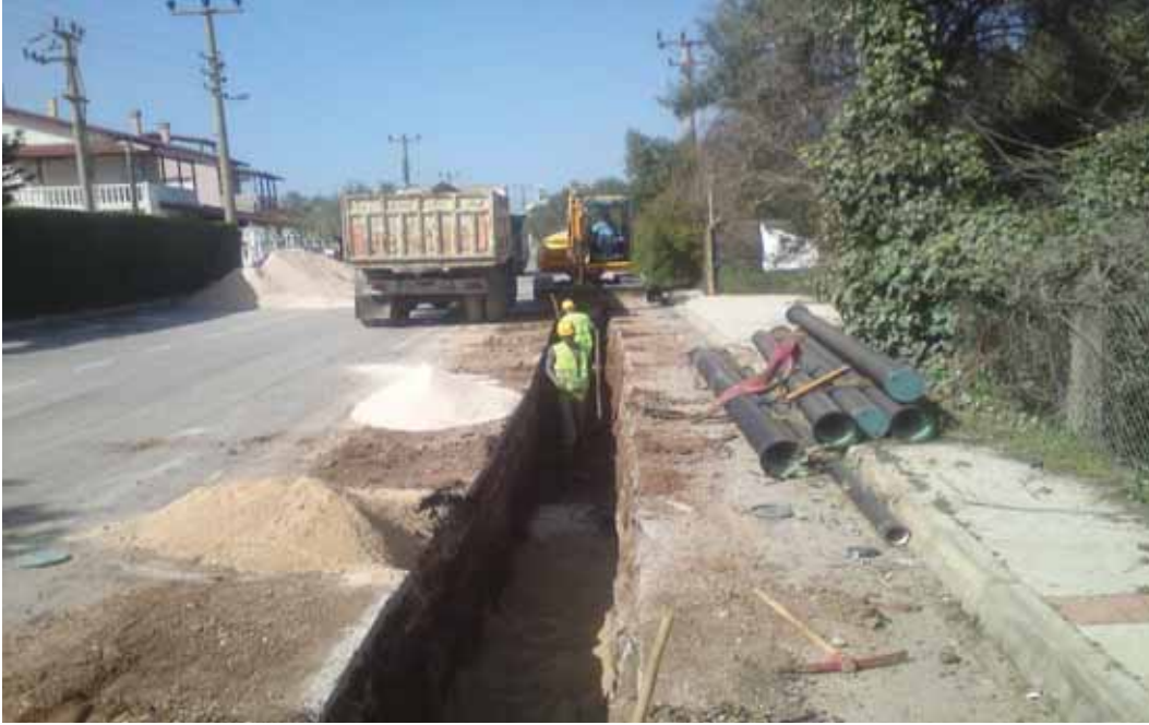
Merkez Mahallesi İçmesuyu DF boru döşeme çalışması
