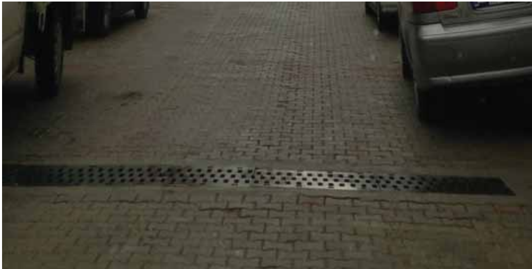
Yağmursuyu Enine bant ızgara çalışması
