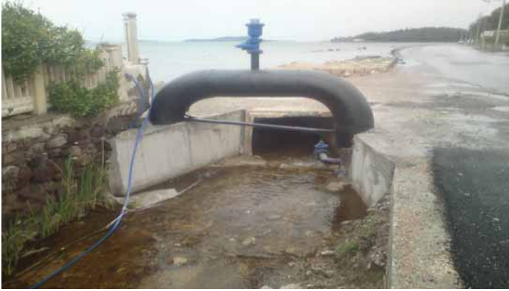
Dere geçişinin çelik boru ile yapılması ve vantuz montajı
