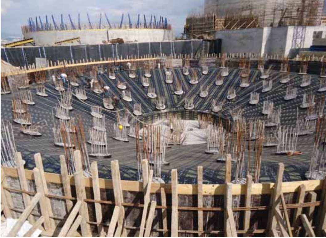
Temelde izolasyon yapılması
