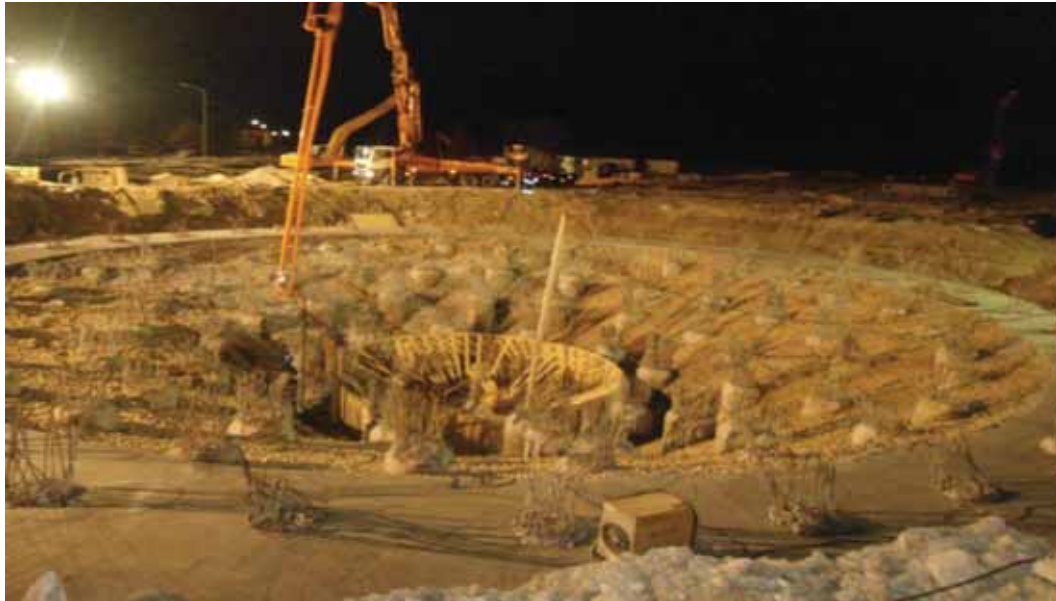
Fore Kazıklı temel çalışması
