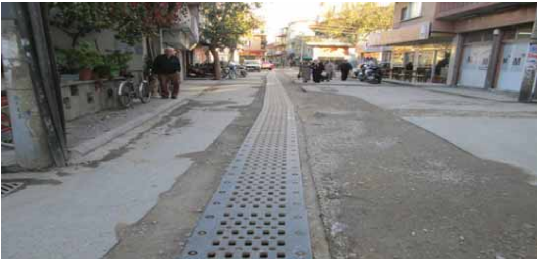
Yağmursuyu Ayrıştırılması imalatının tamamlanmış durumu
