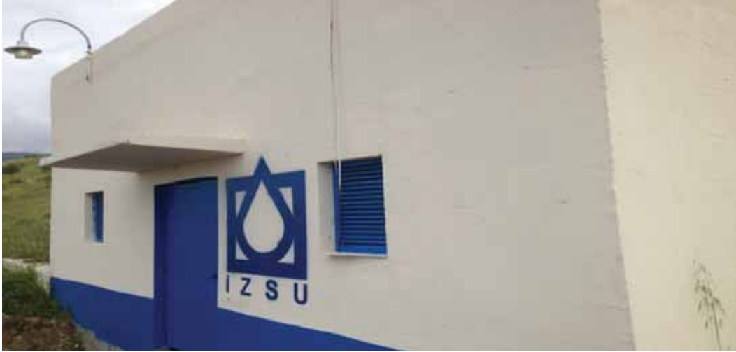
Çaltıldere köyünde su deposu imalatı çalışması
