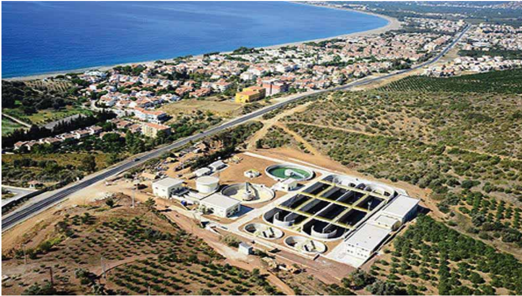
Özdere Atıksu Arıtma Tesisi genel görünümü
