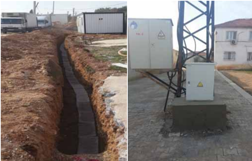
Kemalpaşa İlçesi Yenmiş Köyü İçmesuyu Kuyulan Elektrik Temini çalışmaları
