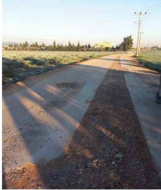
Urla İlçesi Atatürk Mahallesi HDPE koruğu boru döşenmesi ve dolgu çalışması
