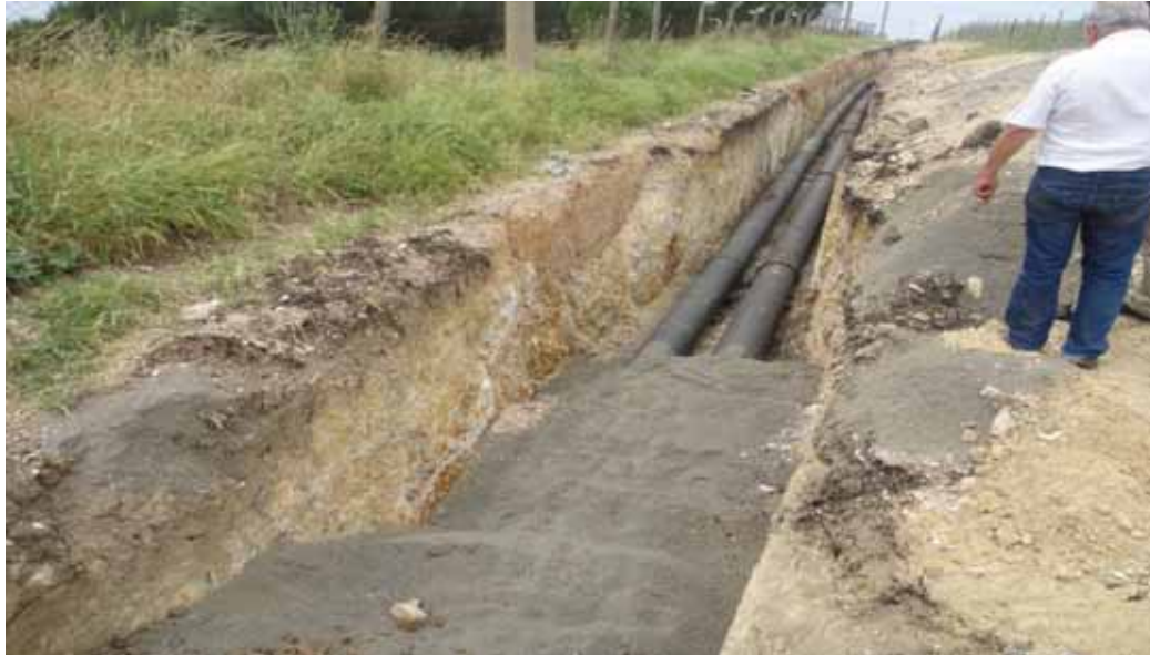
Aliağa İlçesinde içme suyu boru hattı döşenmesi ve dolgu çalışmaları
