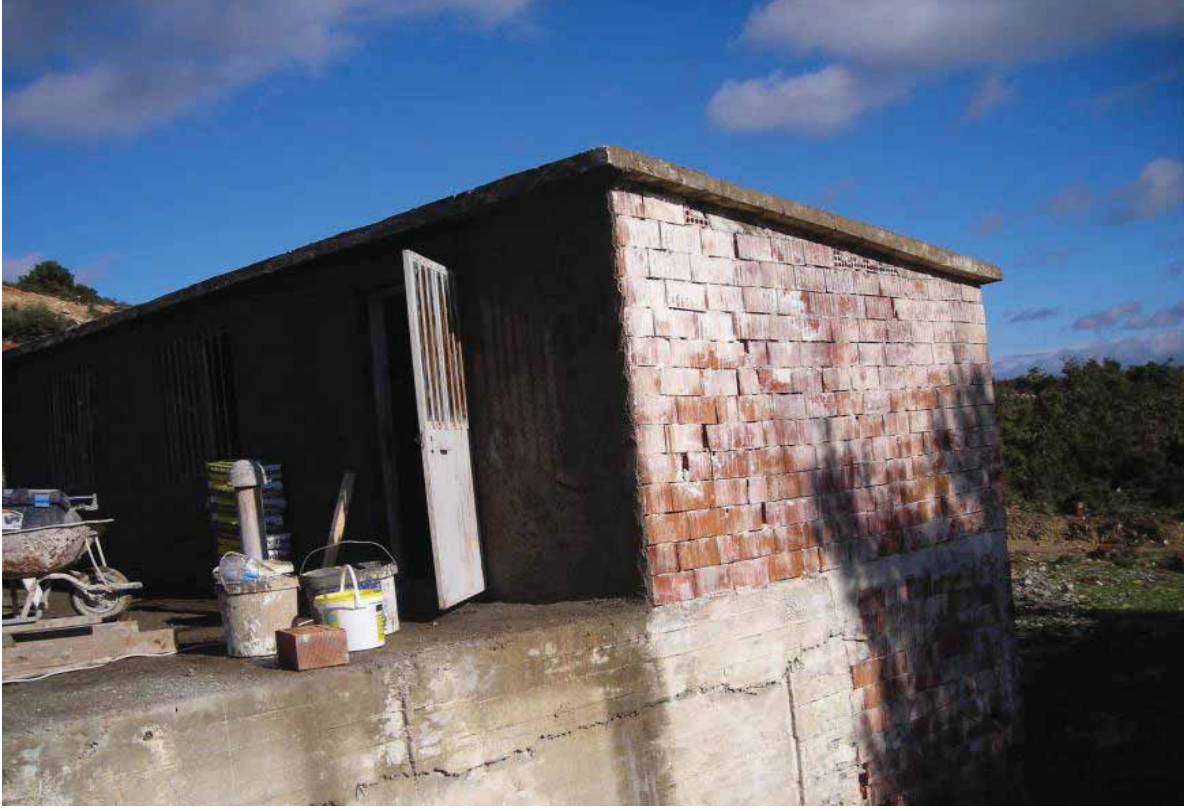
Ürkmez Turgut Köy Deposu Eski Hali
