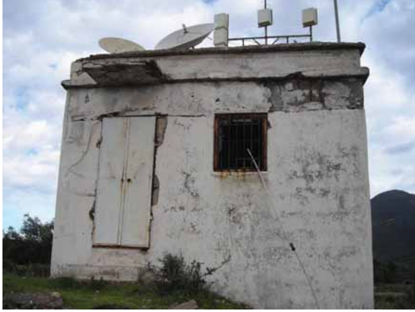
Ürkmez Payamlı Köy Deposu Eski Hali
