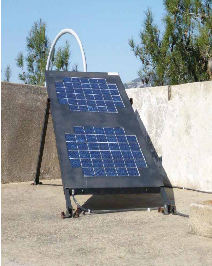
BUCA KAYNAKLAR SOLAR SİSTEM İLE KLORLAMA ÜNİTESİ
