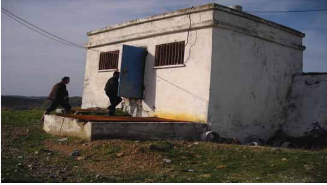
Ürkmez Karakayalar Köy Deposu Eski Hali
