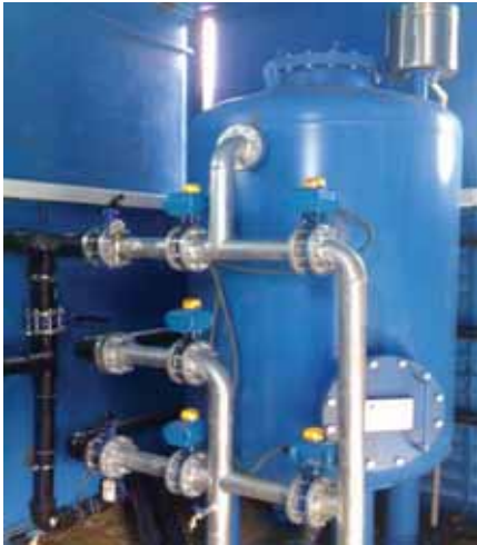
Aliağa İlçesi Bozköy Köyü Kuyusuna Arsenik Arıtım Ünitesi Temini ve Montajı
