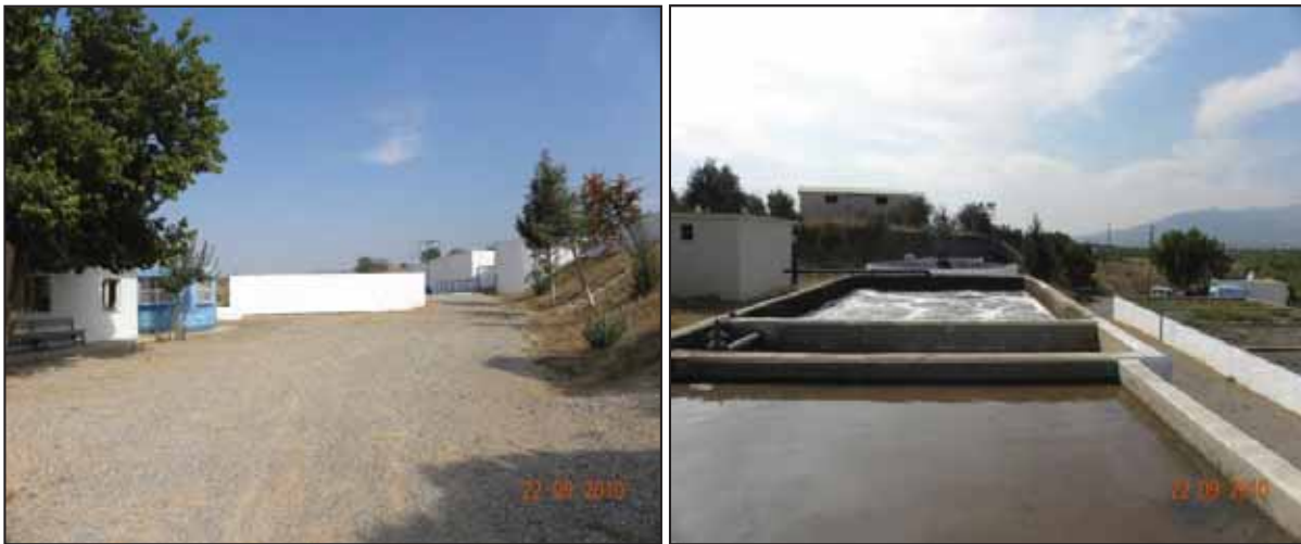
Halilbeyli Atıksu Arıtma Tesisi
