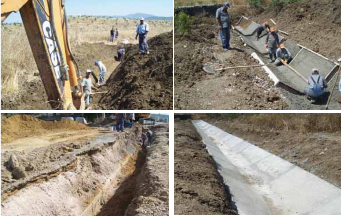
İzmir İli Aliağa İlçesi Atıksu Kanalı İnşaatı
