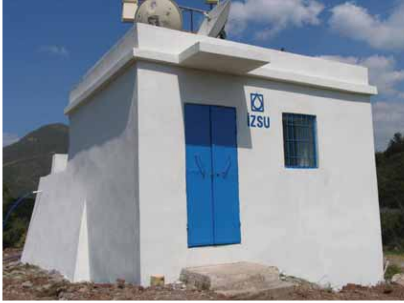
Ürkmez Payamlı Köy Deposu Yeni Hali
