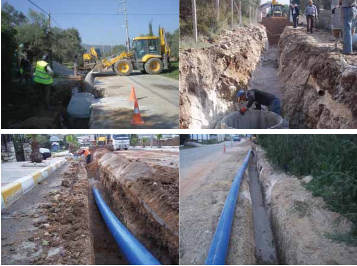
İzmir İli Urla İlçesi 2.Etap Atıksu Kanalı İnşaatı İşi
