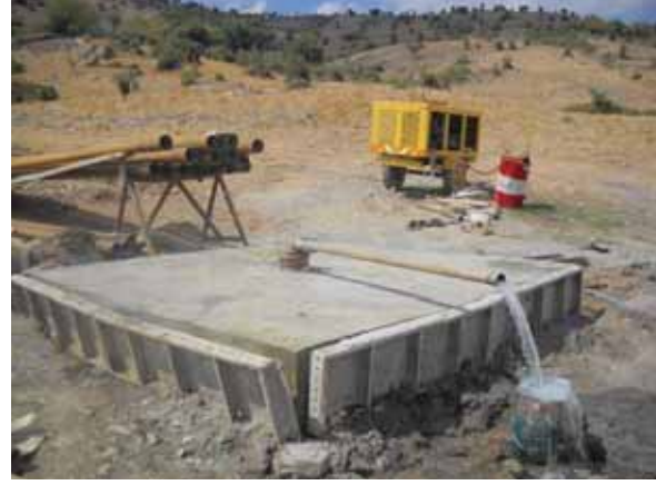
Turgutlar Su Sondaj Kuyusu
