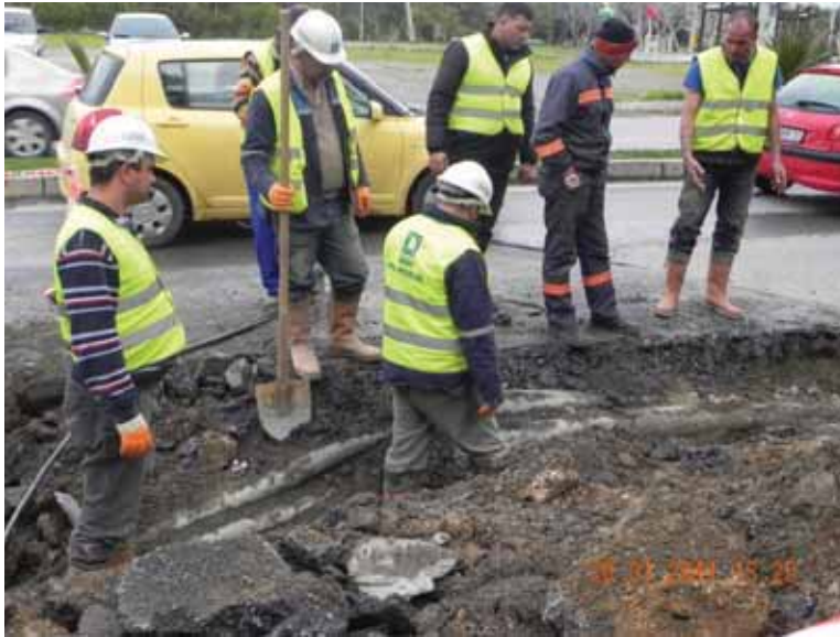
Narlidere Şehitlik Önü Ana Boru Deplasmanı İncelemeleri
