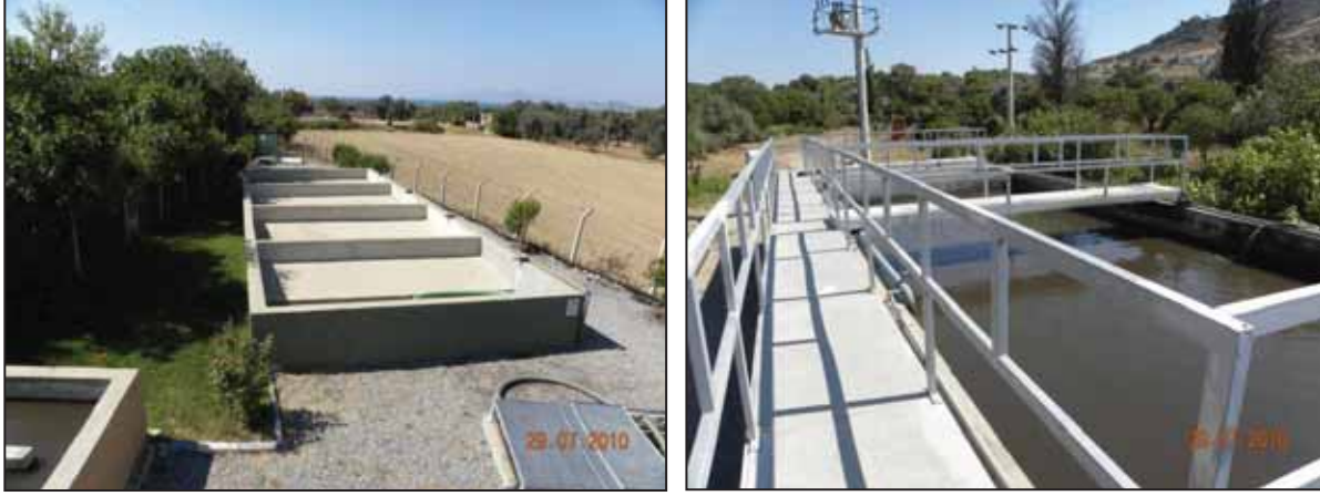
Kozbeyli Atıksu Arıtma Tesisi
