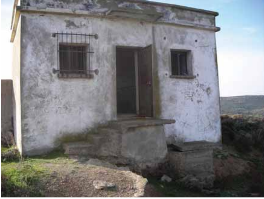
Ürkmez Düzce Köy Deposu Eski Hali
