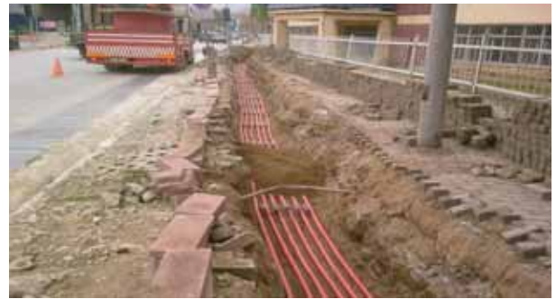
İzmir İli Konak İlçesi Mersinli Havzası Yağmursuyu Terfi Pompa İstasyonu Elektrik Temini
