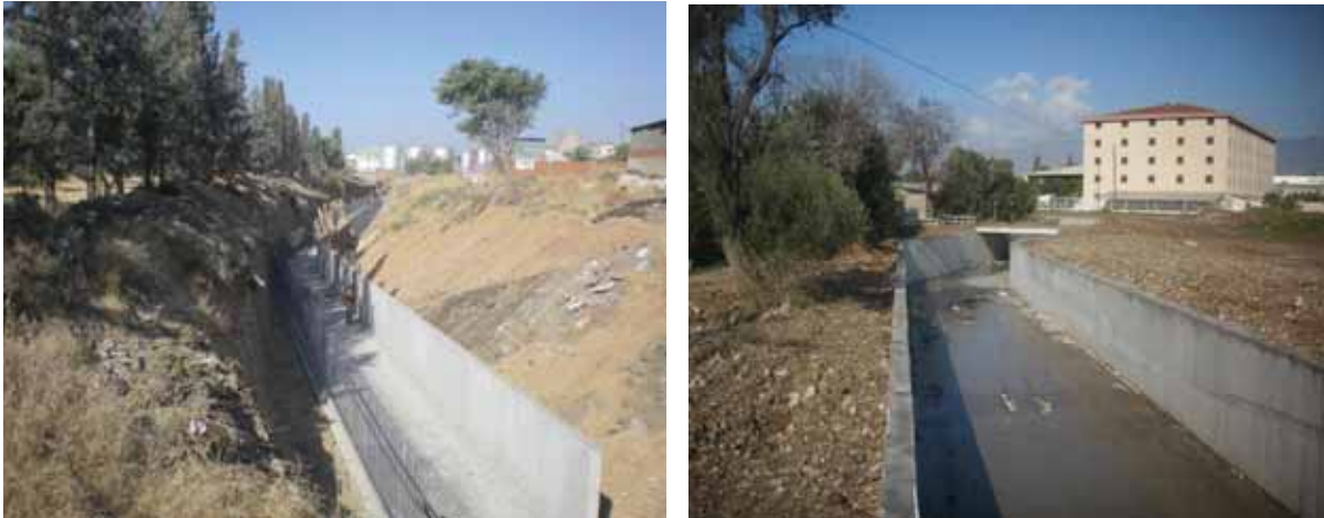
İzmir İli Bornova İlçesi Piçi Deresinin 0+000 ile 4+055 Km'leri Arasının Düzenlenmesi İnşaatı
