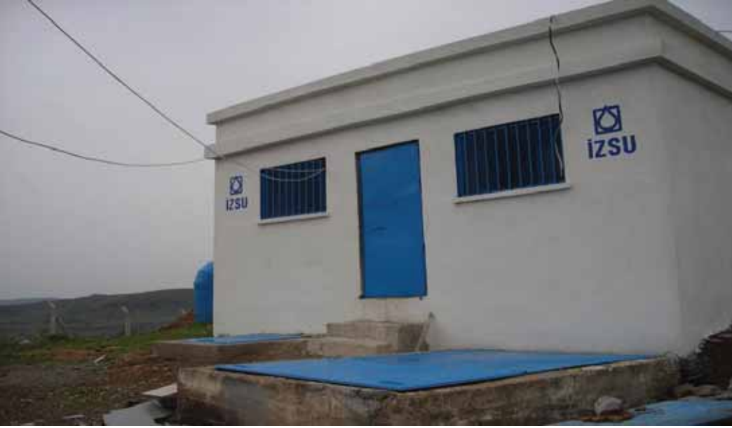
Ürkmez Karakayalar Köy Deposu Yeni Hali
