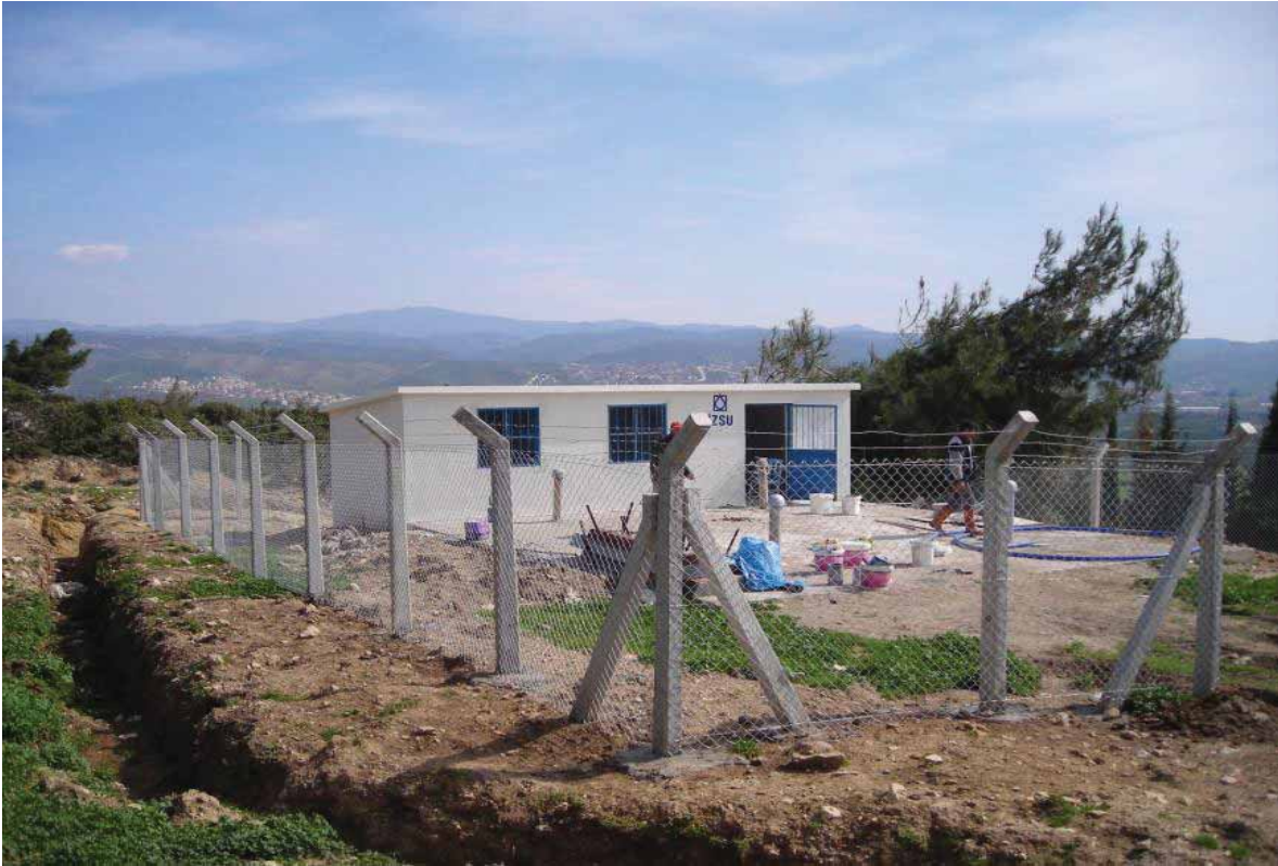
Ürkmez Turgut Köy Deposu Yeni Hali
