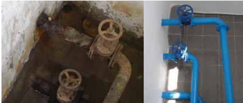
Ürkmez Düzce Köy Deposu Manevra Odası Eski-Yeni Hali
