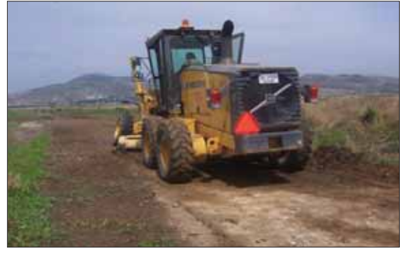
Bakım Çalışması (Yol Bakımı)
