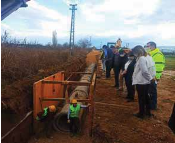
Ödemiş İlçesi Merkez Mahalleleri Atık Su Şebeke ve İletim Hattı İnşaatı İşi
