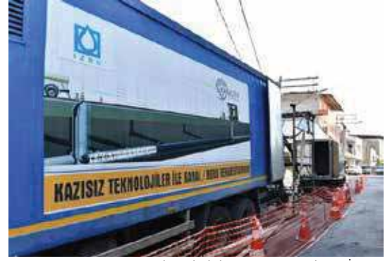
Kazısız Yöntemle Rehabilitasyon ve Yenileme İş
