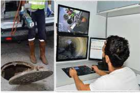
İZSU Kanal Temizleme Robotu
