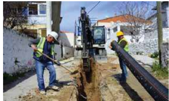
Urla İlçesi Gülbahçe Mahallesi Atık Su İnşaatı
