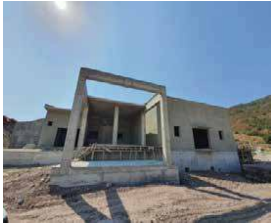
Foça İlçesi İçme Suyu Deposu
