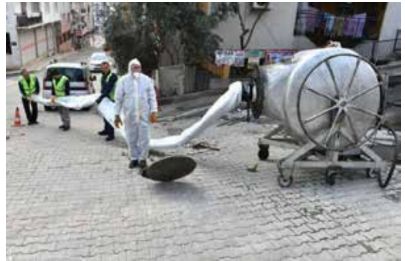
Kanalizasyon Hatlarının İç Kaplama Yöntemiyle İyileştirilmesi
