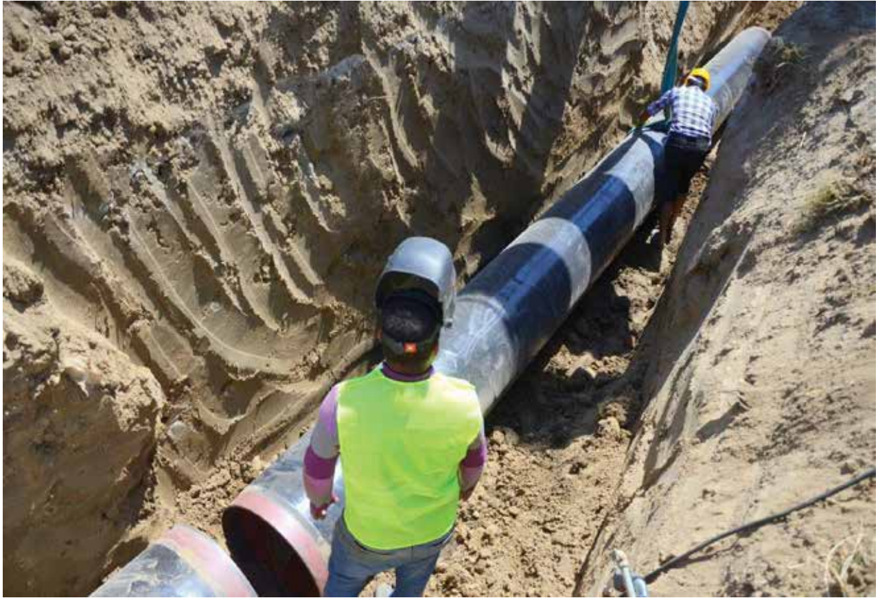
İçme Suyu Şebeke Hattı ve İsale Hattı Yenileme Çalışmaları
