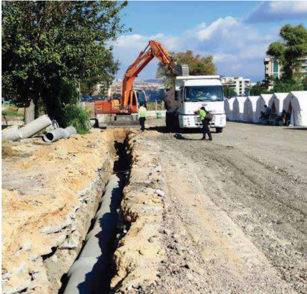
Depremzedeler İçin Yapılan Alt Yapı Çalışmaları
