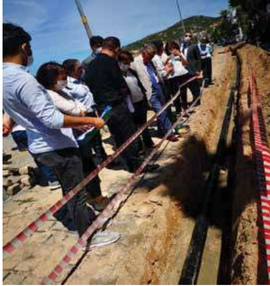
Foça İlçesi İçme Suyu İnşaatı İşi
