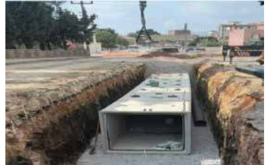
Kemalpaşa İlçesi Ulucak, Kuyucak, Damlacık ve Ansızca Yerleşimleri Altyapı İnşaatı
