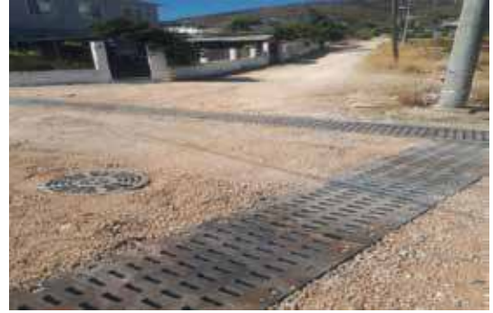
Urla İlçesi Gülbahçe Mahallesi Atık su ve Yağmur Suyu Şebekesi ile Kocadağ-Güllü-Cinlipınar Dere Islah İnşaatı
