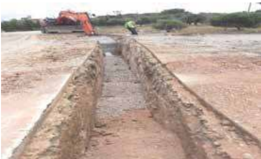
Karaburun İlçesi Mordoğan Mahallesi Atık Su ve Yağmur Suyu Şebekesi İnşaatı
