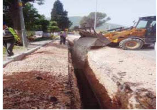
Kemalpaşa İlçesi Ulucak, Kuyucak, Damlacık ve Ansızca Yerleşimleri Altyapı Çalışmaları
