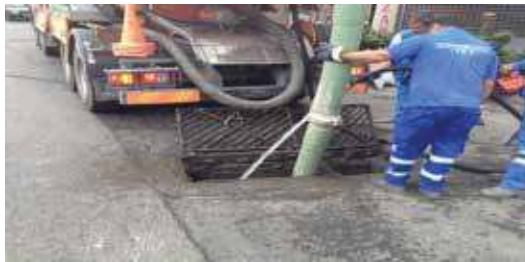
Tekli Yağmur Suyu Izgarası Temizliği
