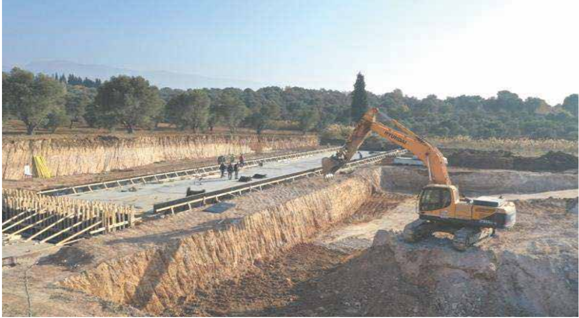
Kemalpaşa Ulucak Atık Su Arıtma Tesisi İnşaatı
