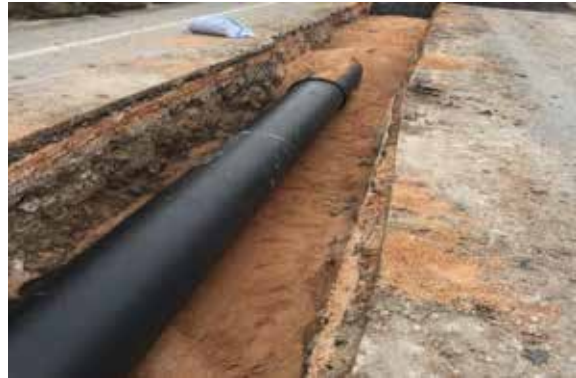
Çeşme İlçesi ve Bağlı Mahalleleri 2. Etap İçme Suyu İnşaatı
