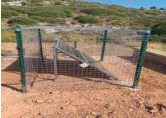
İçme Suyu Depoları Güneş Enerji Sistemi
