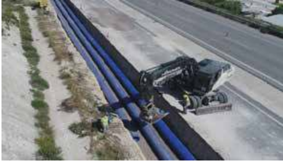
Çeşme İlçesi Alaçatı Mahallesi 18 Nolu Terfi Merkezi Revizyonu ile TM18-AAT arası İletim Hattı İnşaatı ve Elektrik İletim Tesisleri Yapımı İşi
