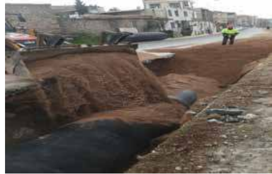
Bornova İlçesi Ana İletim Hatları ile Pınarbaşı İçme Suyu Ana İletim Hattı İnşaatı
