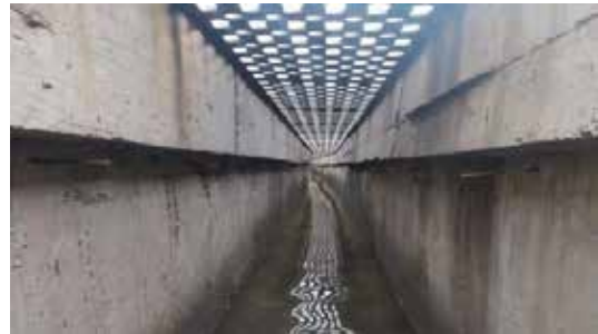
Tekli Yağmur Suyu Izgarası Yapımı
