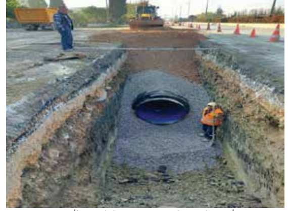
Menemen İlçesi Ulukent Sanayi Bölgesi Altyapı İnşaatı
