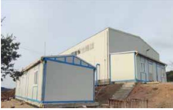
Bornova Karaçam Göleti İçme Suyu Arıtma Tesisi
