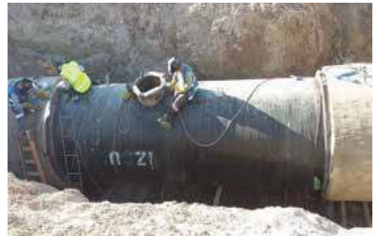
İçme Suyu Şebeke Hattı ve İsale Hattı Yenileme Çalışmaları
