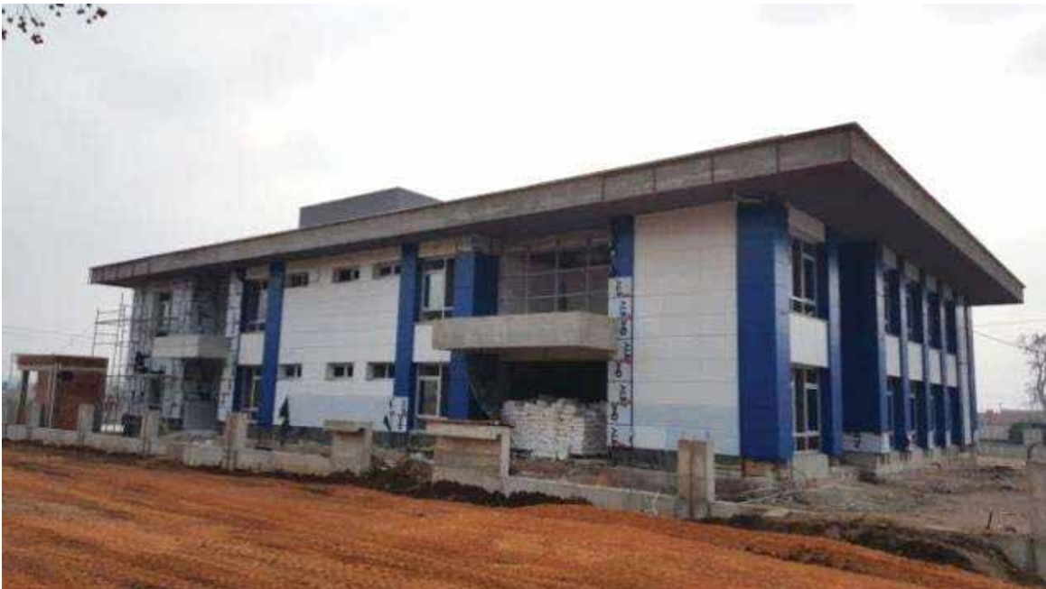
Bayındır Hizmet Binası İnşaatı
