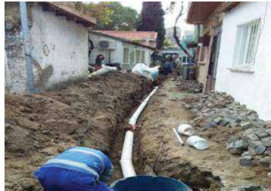
Kısa Metrajlı Kanalizasyon Hatlarının İmalatı
