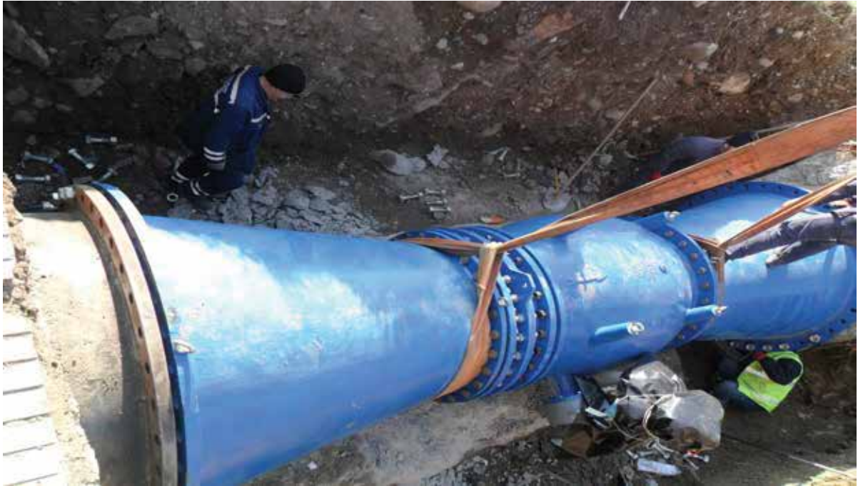
İsale Hattının Periyodik Bakım ve Onarımı Çalışmaları
