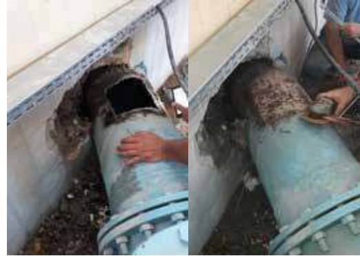
Pompa İstasyonları ve Hizmet Tesisleri Tadilat Çalışmaları
