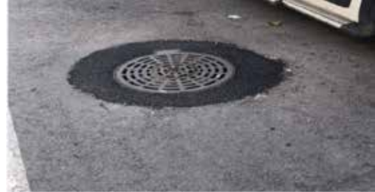
Baca Kapak ve Izgaraların Yol Seviyesine Getirilmesi
