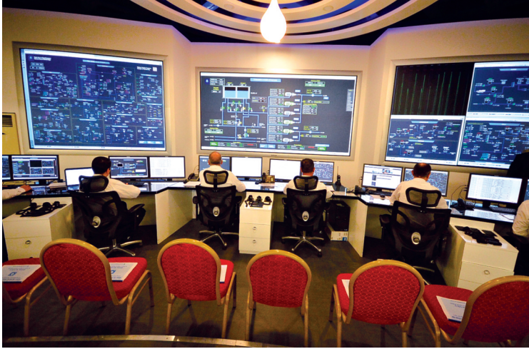
İZSU'nun içme suyu dağıtım sisteminin ana omurgasını SCADA oluşturmaktadır
