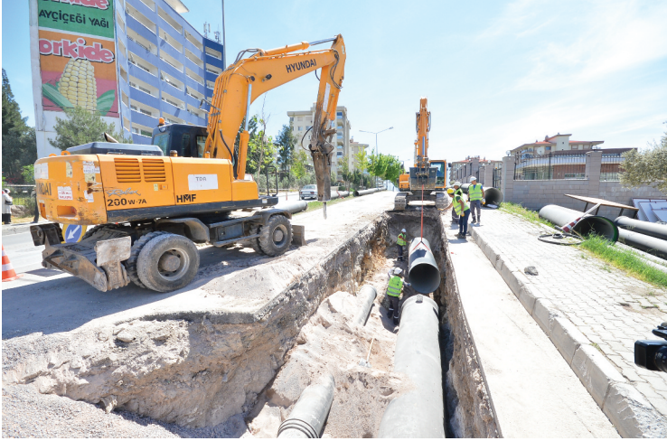
Gördes Barajı'ndaki suyu kentimize getirecek olan iletim hattı çalışmalarından bir görüntü
