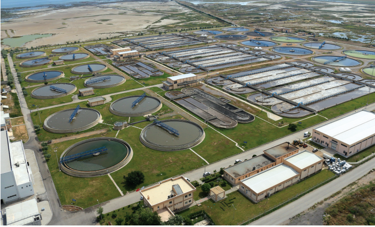
Çiğli Atıksu Arıtma Tesisi, kapasitesiyle Türkiye'nin en büyük ileri biyolojik prosese sahip tesisidir.
