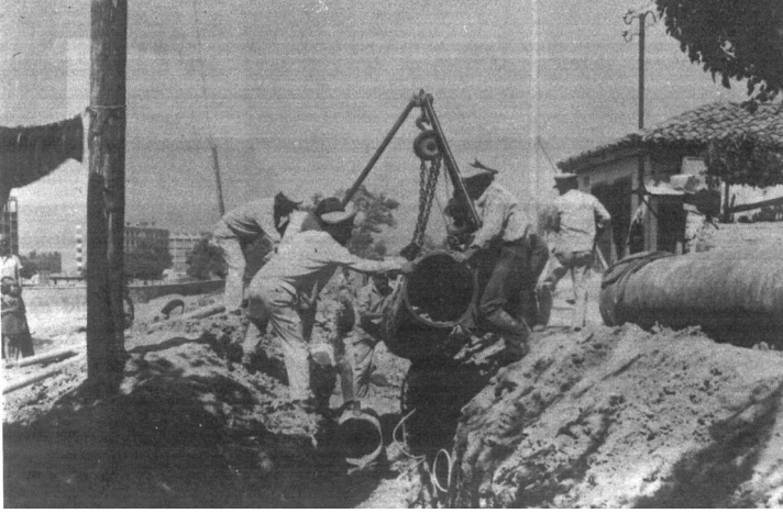
Halkapınar Su Fabrikası ile Kadifekale Su Deposu arası 500 mm'lik isale hattı tefrişatından bir görünüş
